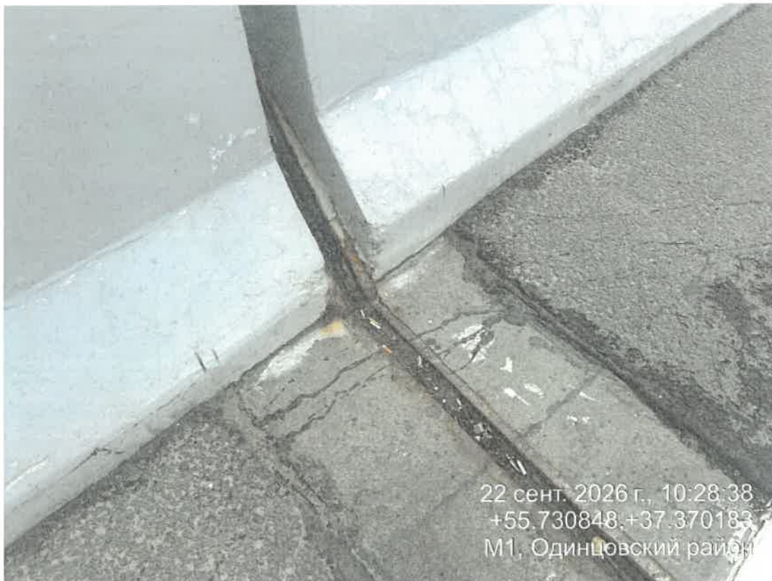
6. Коррозия опоры информационного
