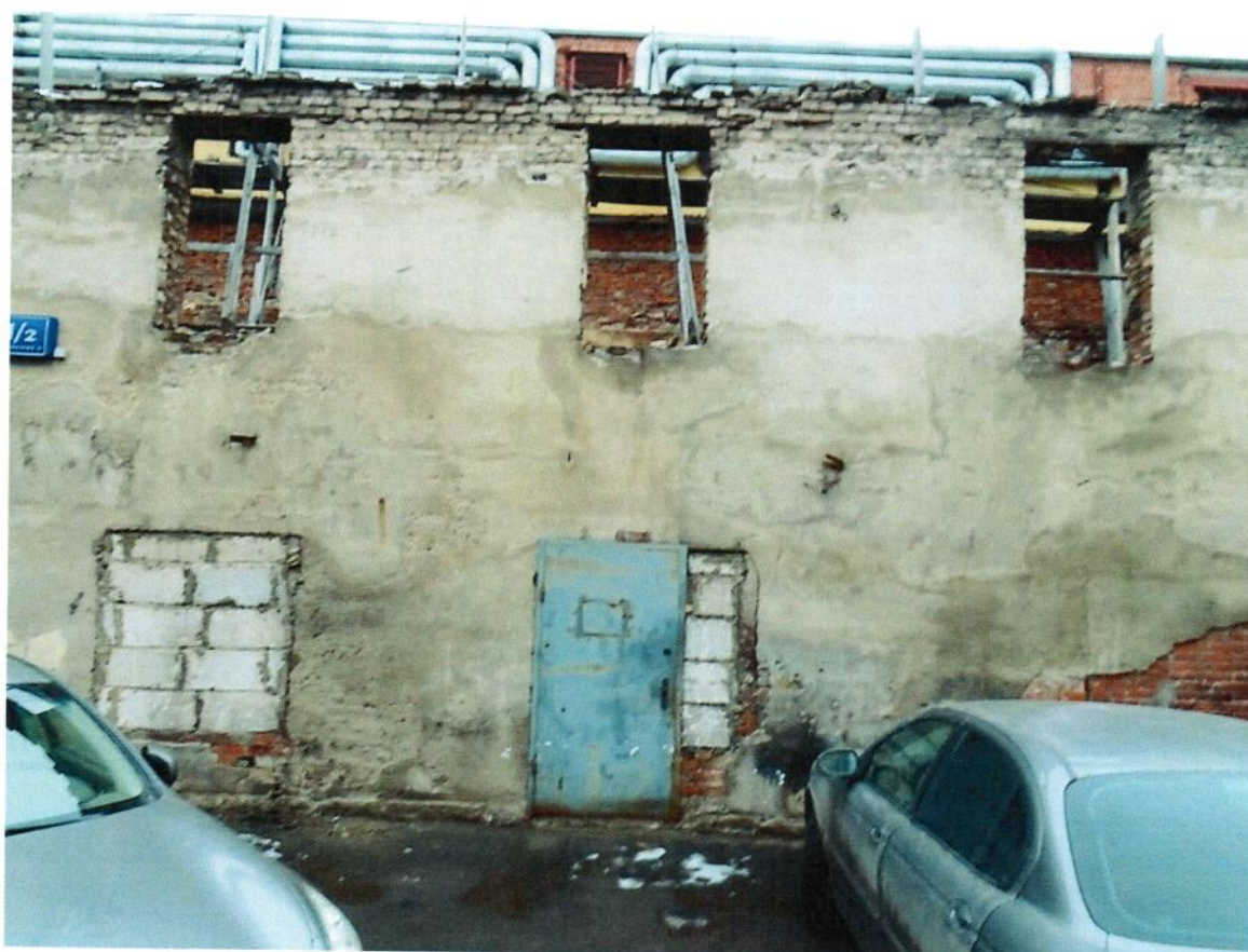
Фото 2. Фрагмент юго-восточного фасада, центральная часть.
