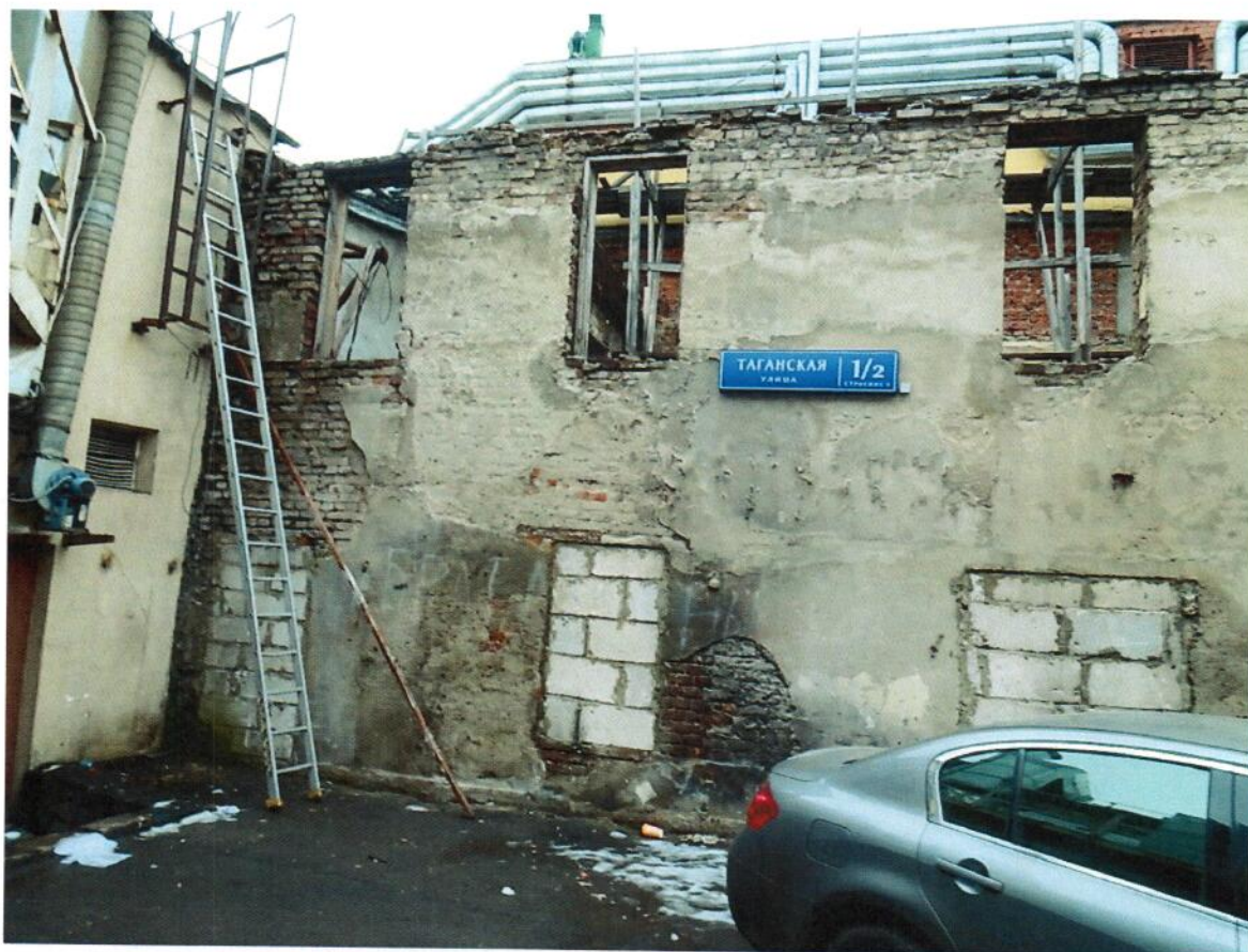
Фото 1. Фрагмент юго-восточного фасада.
