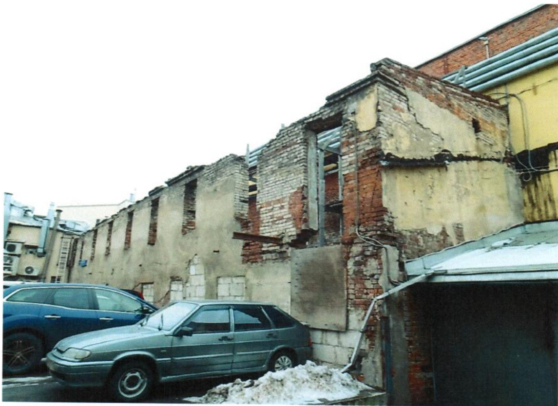
Фото 3. Восточный угол здания, юго-восточный и северо восточный фасады.
