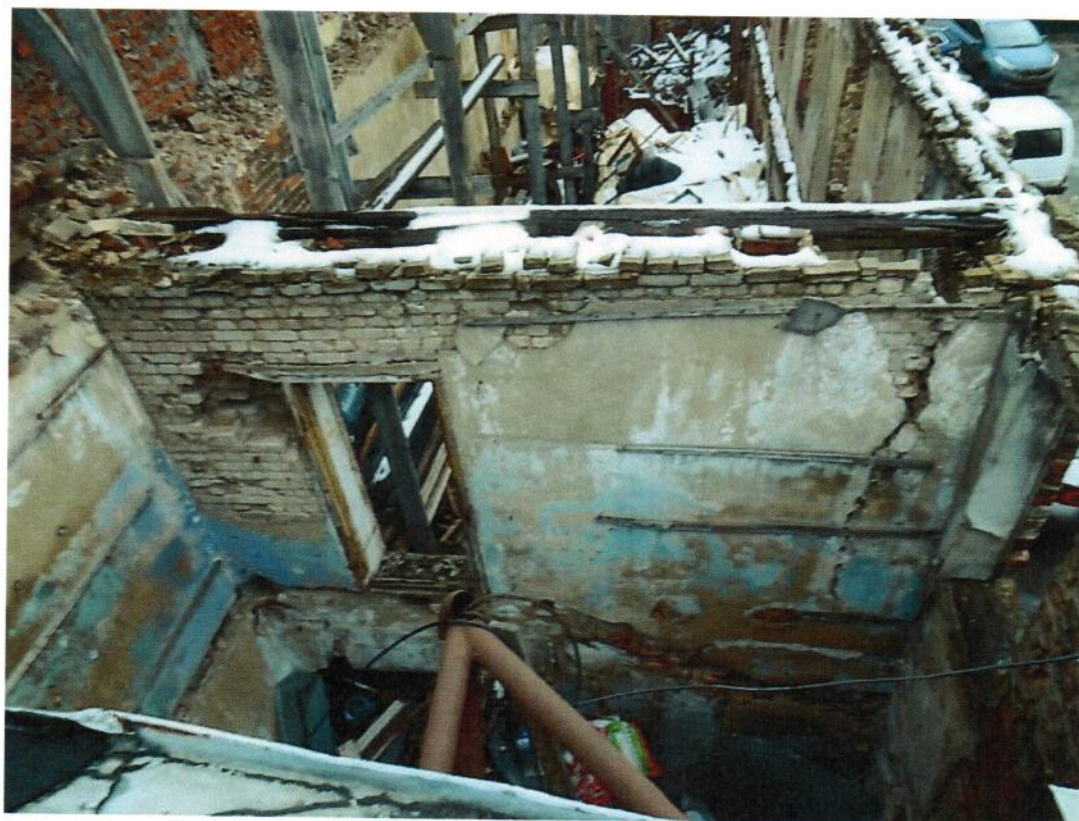
Фото 6. Интерьер. Общий вид лестничной клетки, вид сверху.
