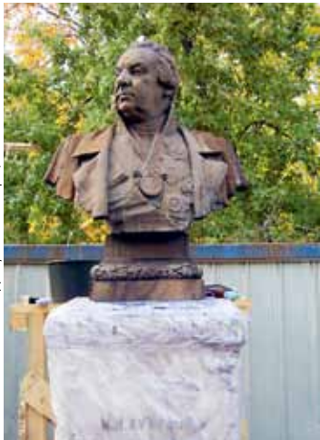
Под памятником-бюстом М. И. Кутузова пришлось ремонтировать фундамент
