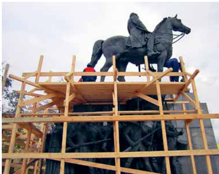
В конном памятнике М. И. Кутузову были исправлены дефекты литья
