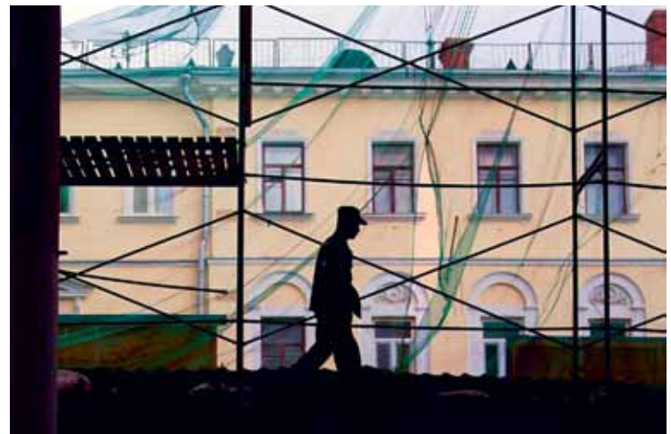
реконструкция исторического наследия стыдливо затянута сеточкой
