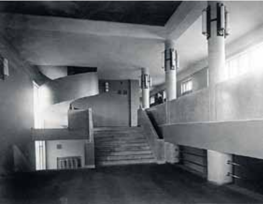
Братья Веснины. Дворец культуры Пролетарского района. 1931–1937 годы. Фойе третьего этажа и лестница в обсерваторию
