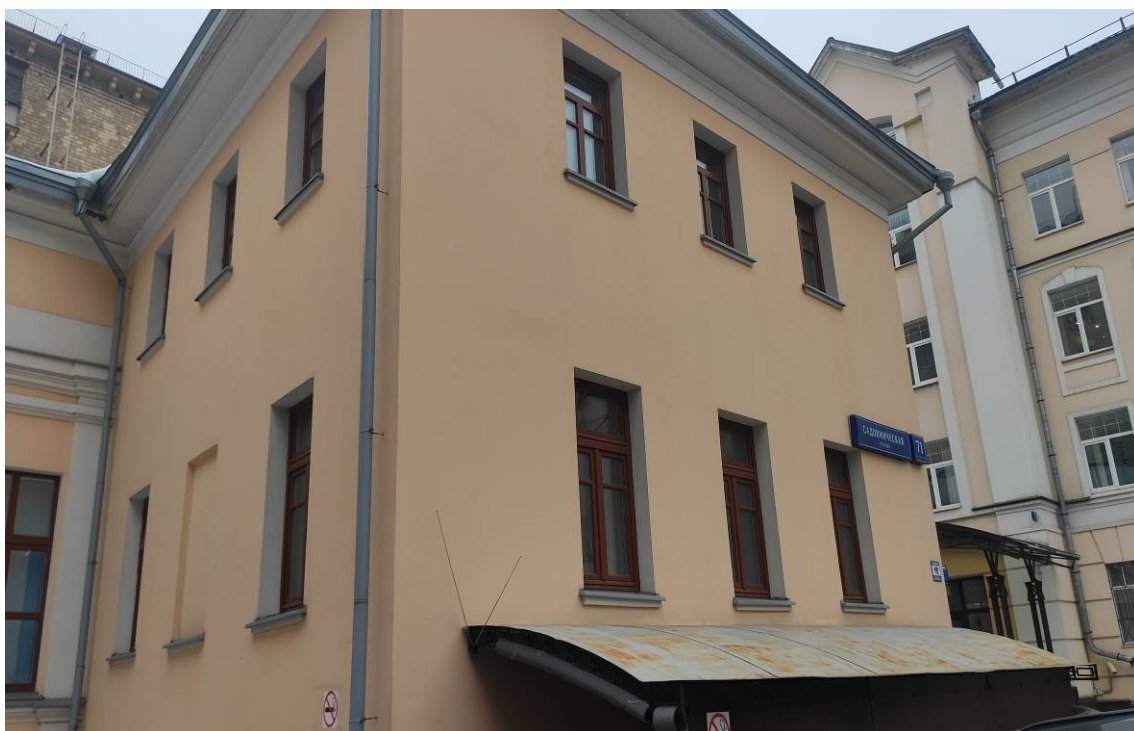
Фото 2. Вид центрального фасада с запада (дата съемки: март 2024 г.)
