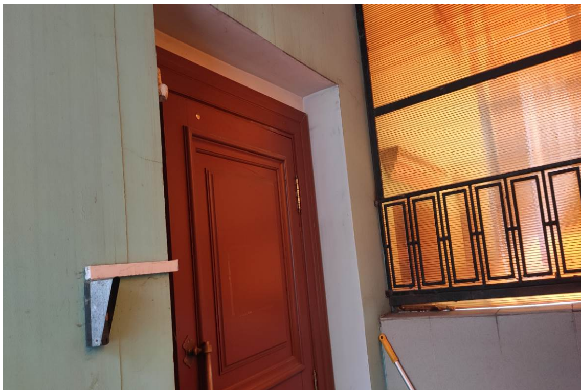
Фото 14. Вход с улицы в цокольный этаж (дата съемки: март 2024 г.)
