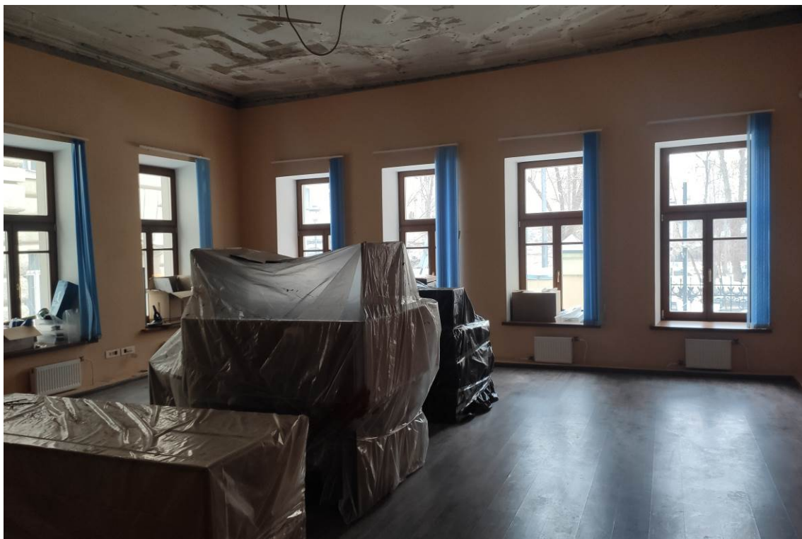
Фото 7. Вид интерьера первого этажа (дата съемки: март 2024 г.)
