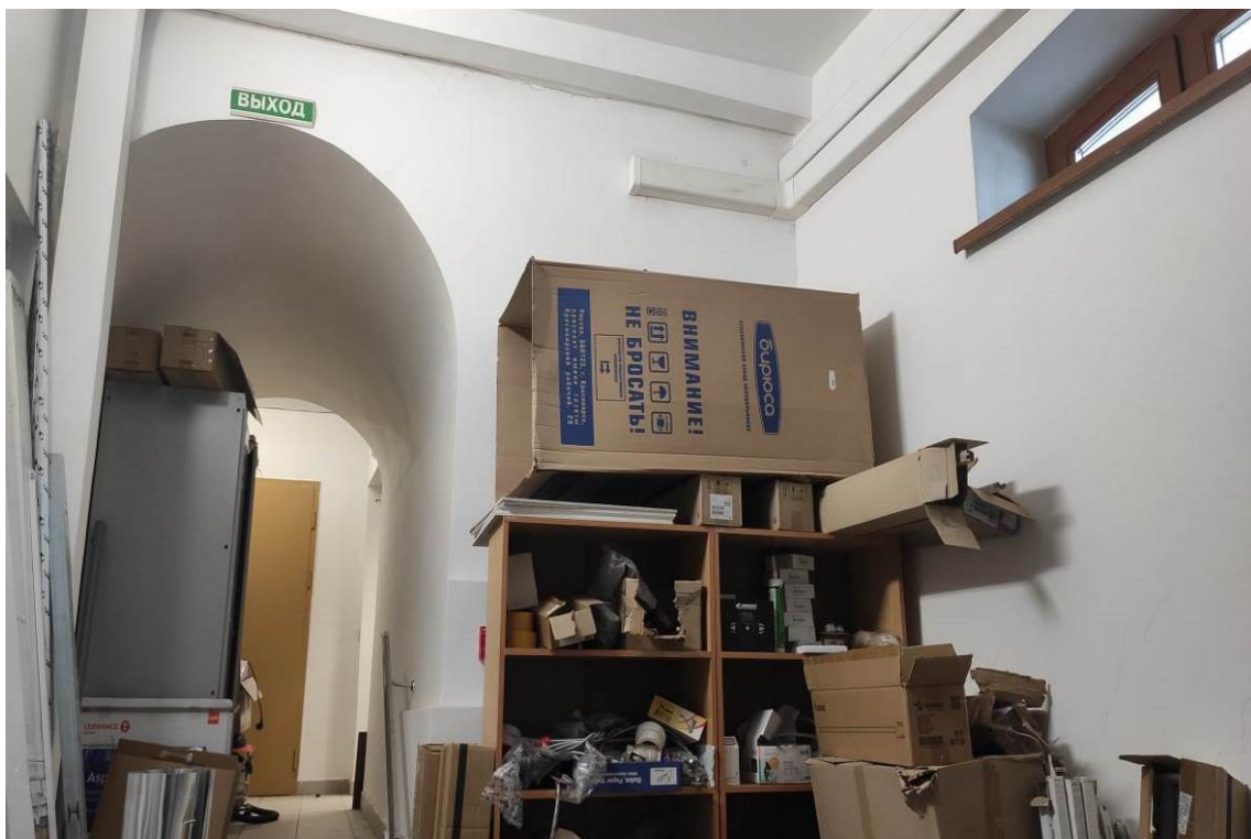
Фото 8. Вид интерьера цокольного этажа (дата съемки: март 2024 г.)
