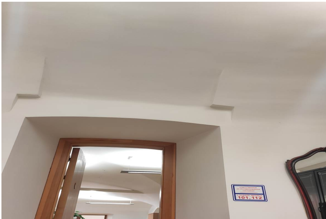
Фото 27. Вид интерьера цокольного этажа (дата съемки: март 2024 г.)
