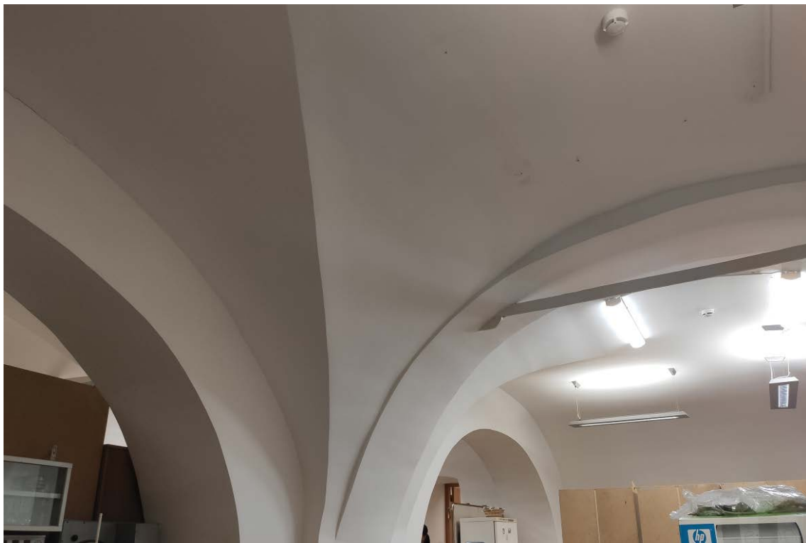
Фото 31. Вид интерьера цокольного этажа (дата съемки: март 2024 г.)
