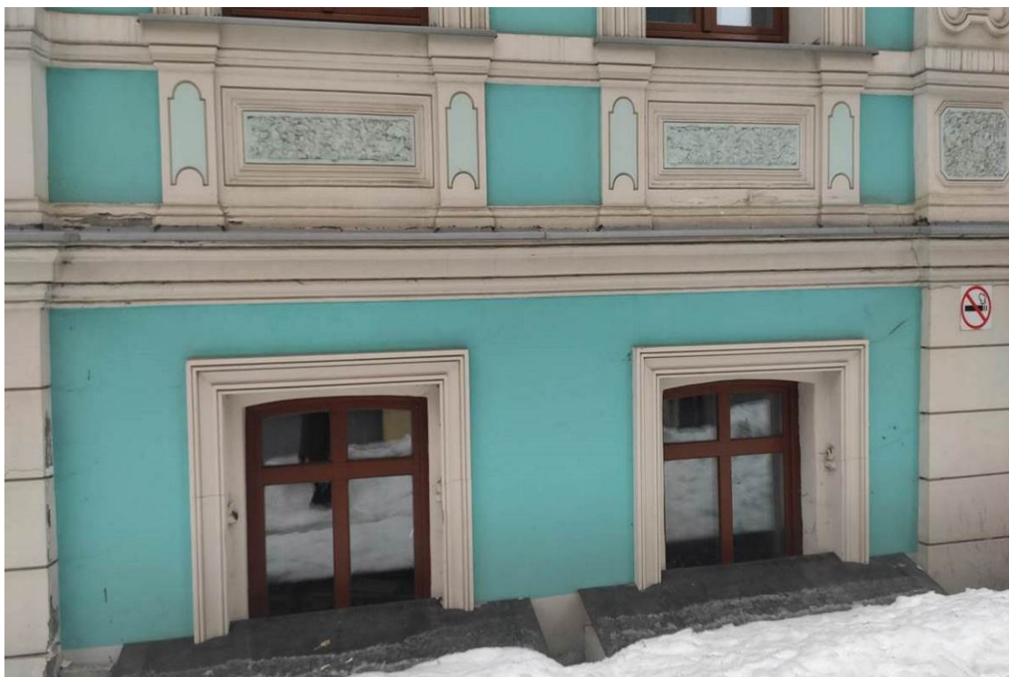
Фото 15. Вид фасада с востока (дата съемки: март 2024 г.)
