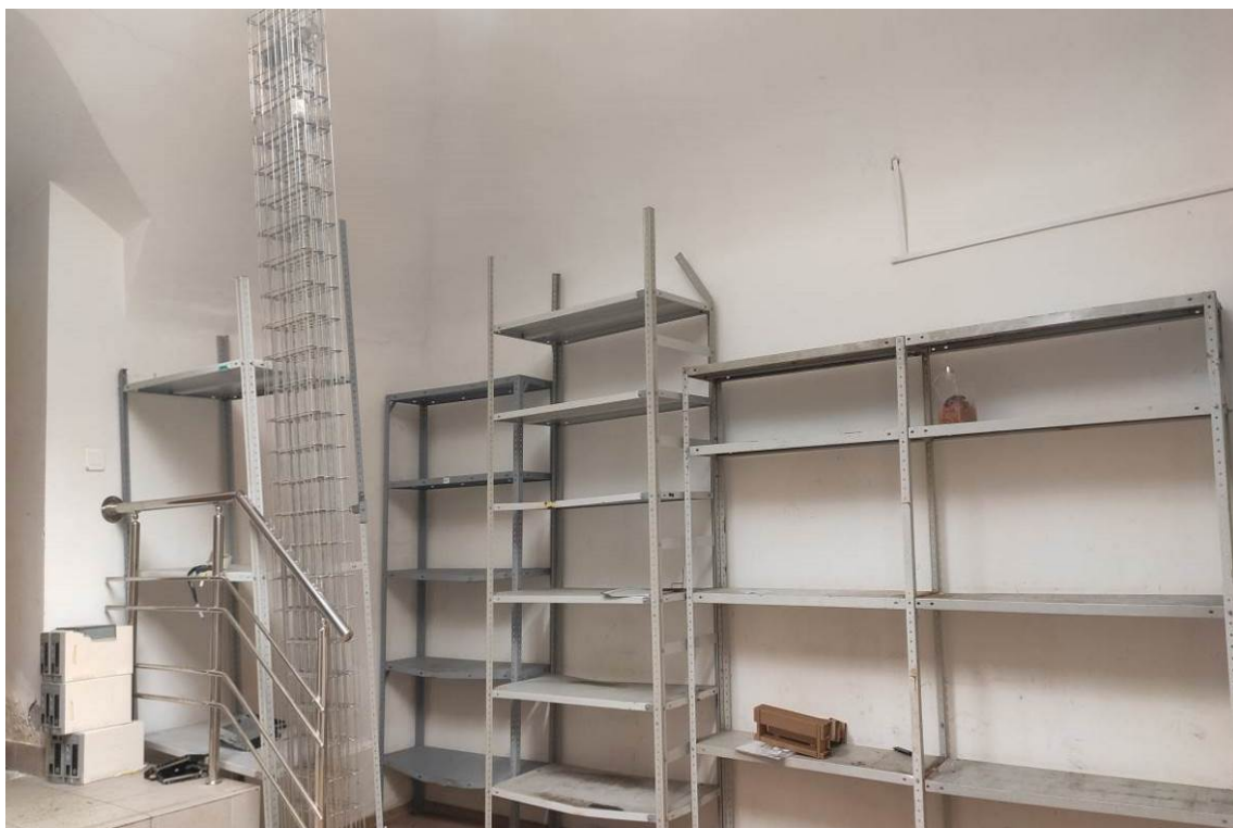
Фото 36. Вид интерьера цокольного этажа (дата съемки: март 2024 г.)
