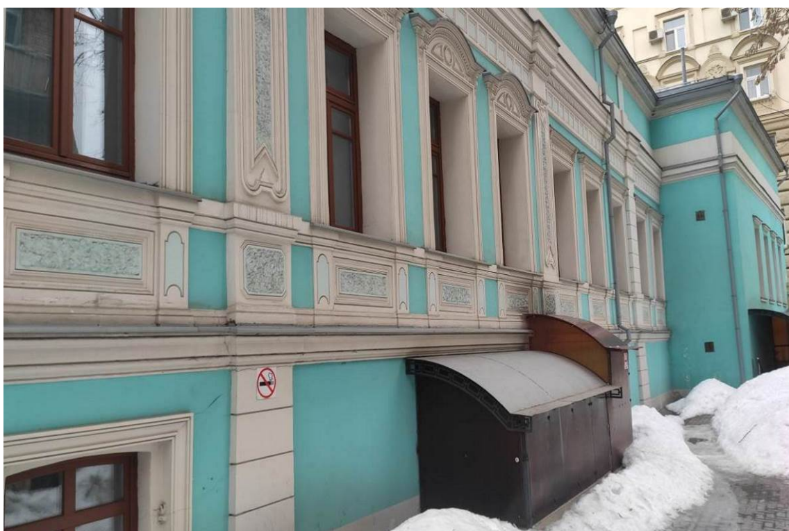
Фото 12. Вид фасада с востока (дата съемки: март 2024 г.)
