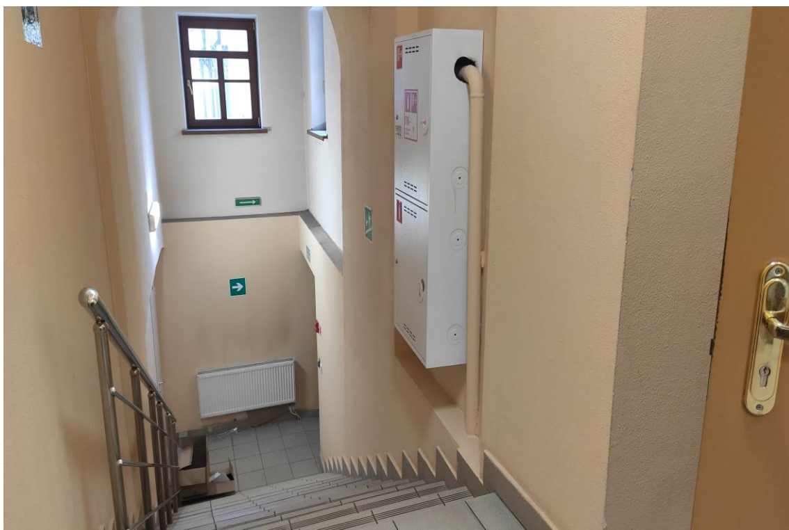
Фото 20. Вид лестницы на цокольный этаж (дата съемки: март 2024 г.)
