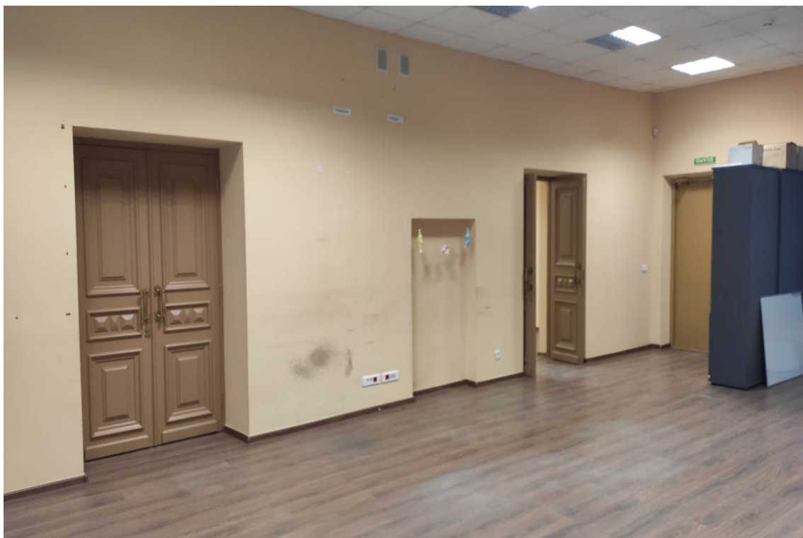
Фото 16. Вид интерьера первого этажа (дата съемки: март 2024 г.)
