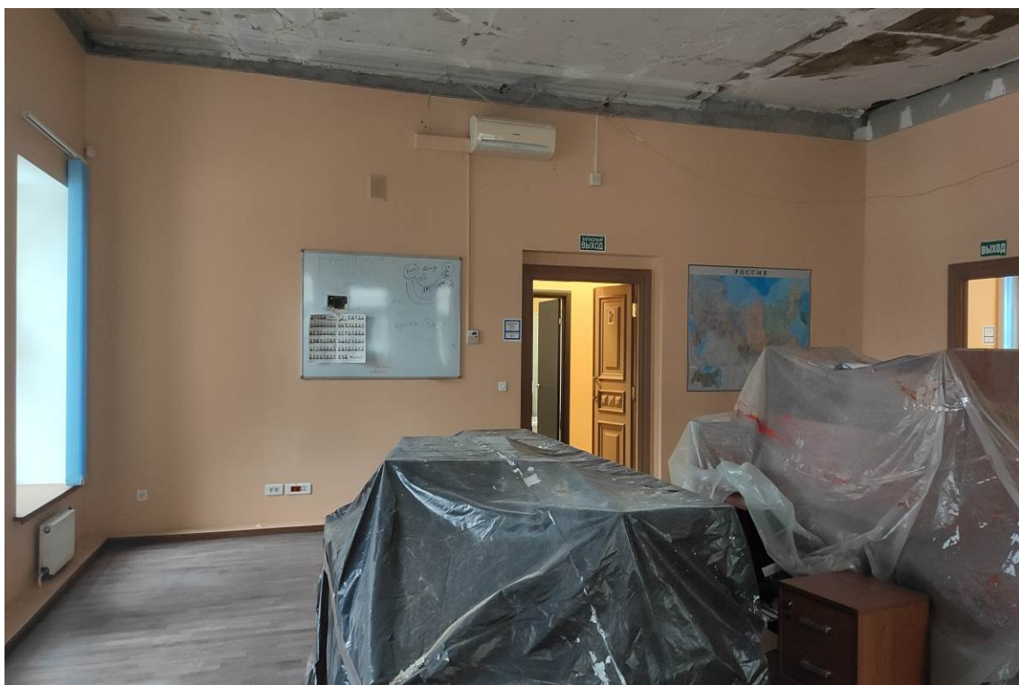
Фото 8. Вид интерьера первого этажа (дата съемки: март 2024 г.)
