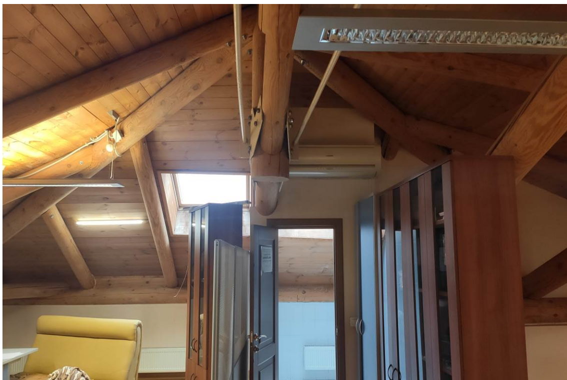
Фото 10. Вид интерьера второго этажа (дата съемки: март 2024 г.)
