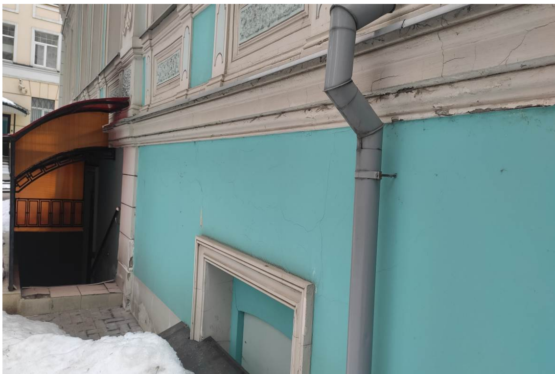
Фото 33. Вход с улицы в цокольный этаж (дата съемки: март 2024 г.)
