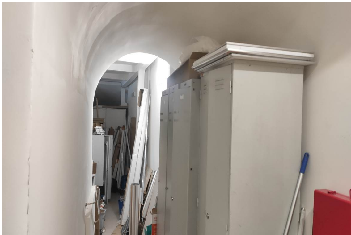
Фото 6. Вид интерьера цокольного этажа (дата съемки: март 2024 г.)
