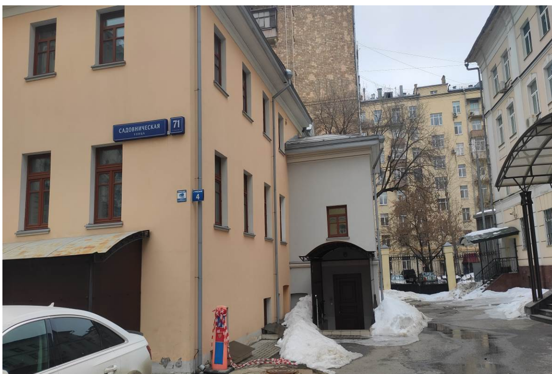
Фото 7. Вид фасада с юго-запада (дата съемки: март 2024 г.)
