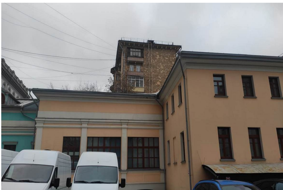
Фото 6. Вид центрального фасада с запада (дата съемки: март 2024 г.)
