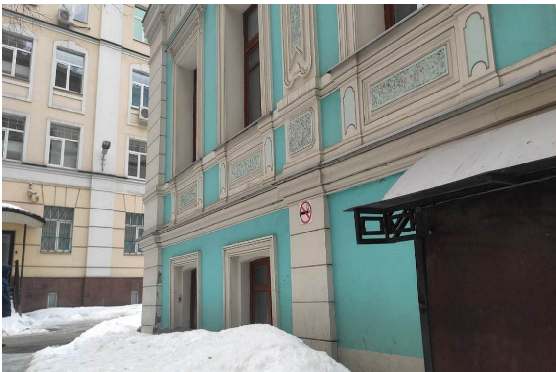
Фото 16. Вид фасада с северо-востока (дата съемки: март 2024 г.)
