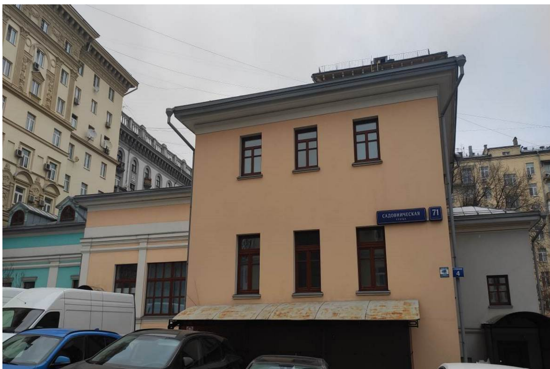
Фото 1. Вид центрального фасада с запада (дата съемки: март 2024 г.)
