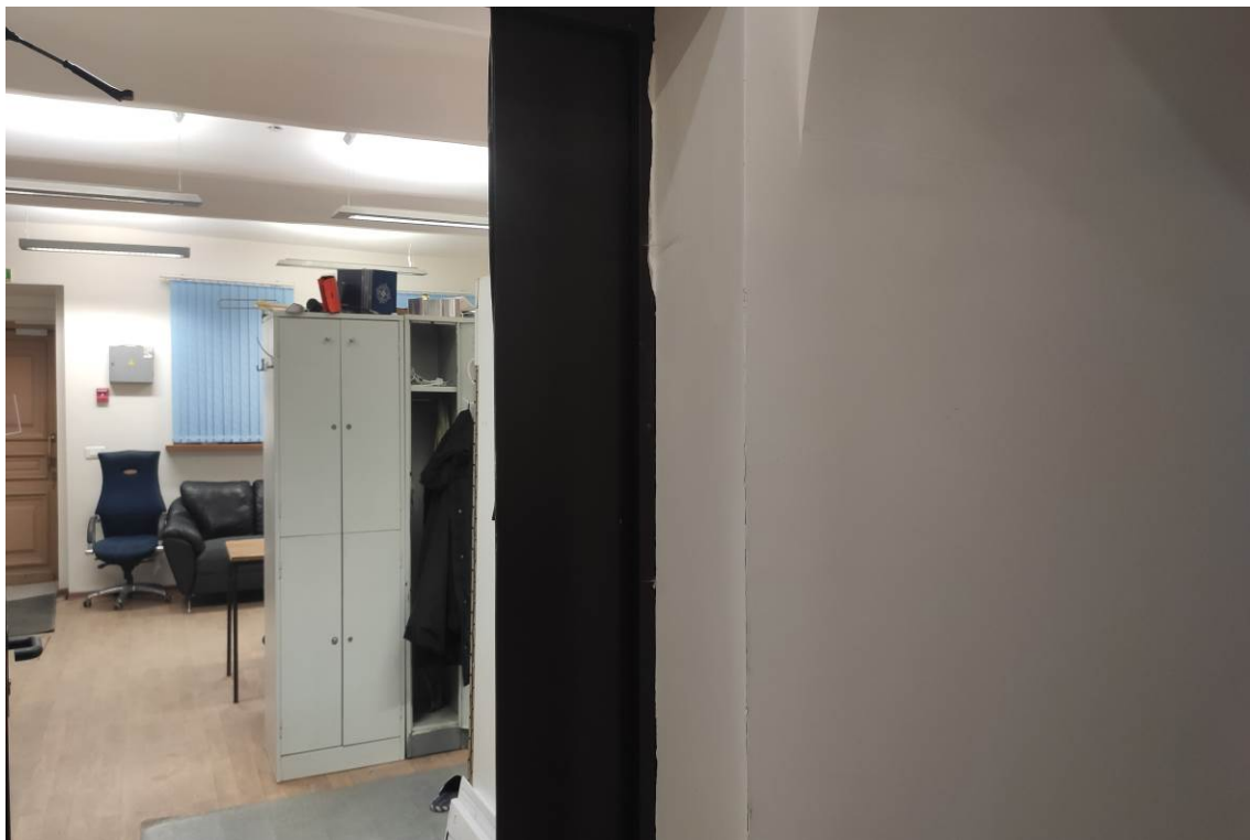
Фото 11. Вид интерьера цокольного этажа (дата съемки: март 2024 г.)
