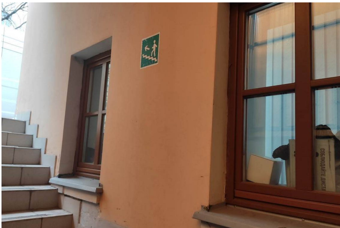
Фото 12. Вход с улицы в цокольный этаж (дата съемки: март 2024 г.)
