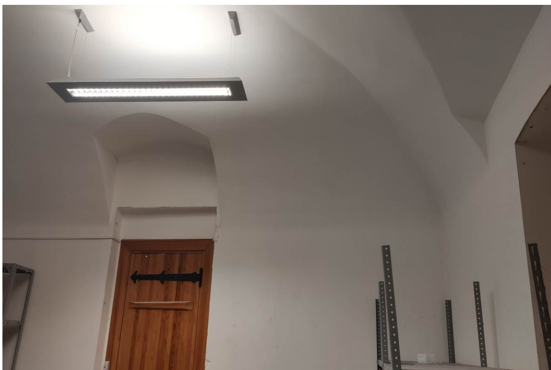
Фото 34. Вид интерьера цокольного этажа (дата съемки: март 2024 г.)
