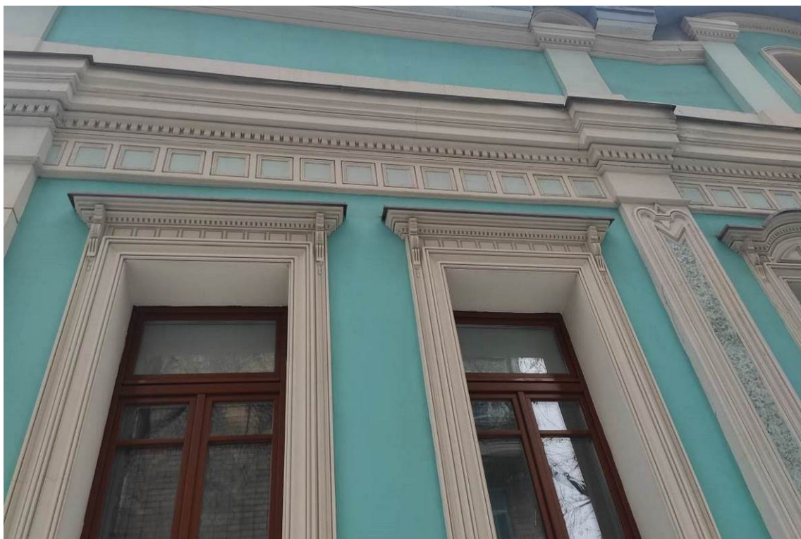
Фото 14. Вид фасада с востока (дата съемки: март 2024 г.)
