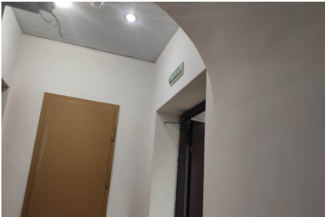
Фото 9. Вид интерьера цокольного этажа (дата съемки: март 2024 г.)
