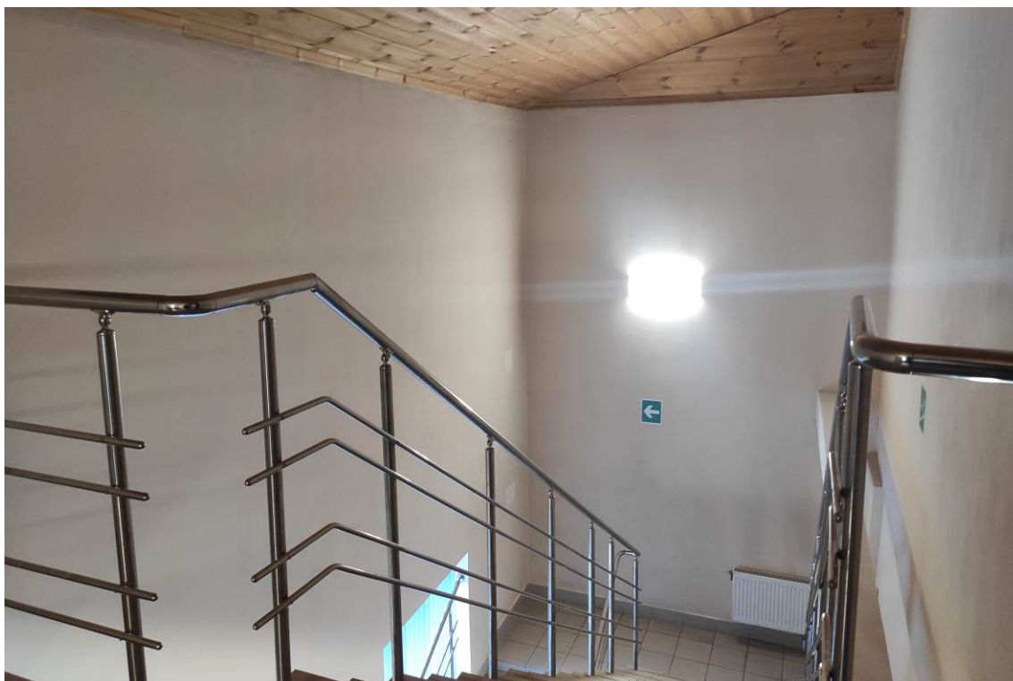
Фото 3. Вид лестничного пролета второго этажа (дата съемки: март 2024 г.)
