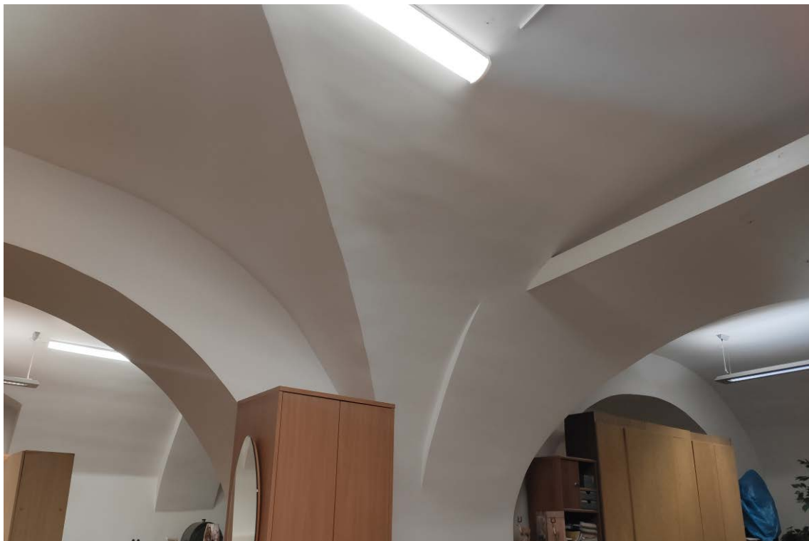
Фото 23. Вид интерьера цокольного этажа (дата съемки: март 2024 г.)
