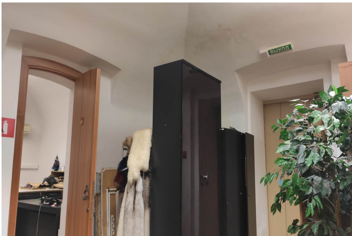
Фото 24. Вид интерьера цокольного этажа (дата съемки: март 2024 г.)
