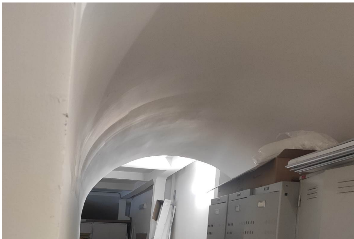
Фото 10. Вид интерьера цокольного этажа (дата съемки: март 2024 г.)
