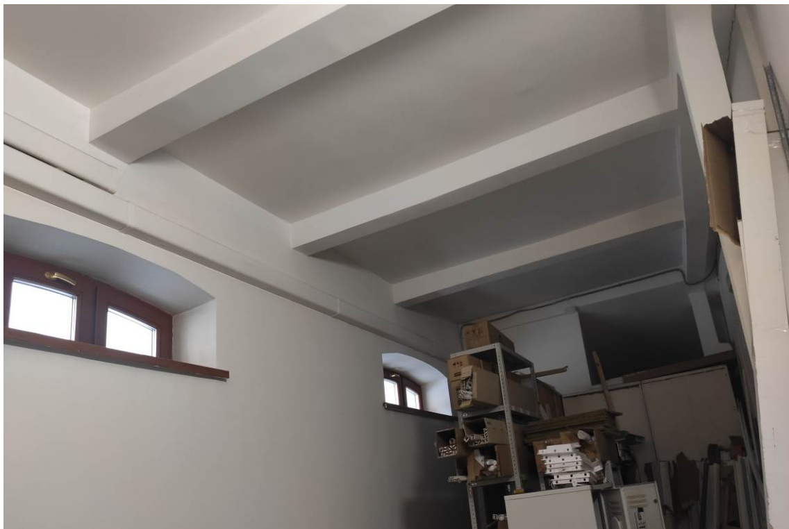
Фото 7. Вид интерьера цокольного этажа (дата съемки: март 2024 г.)
