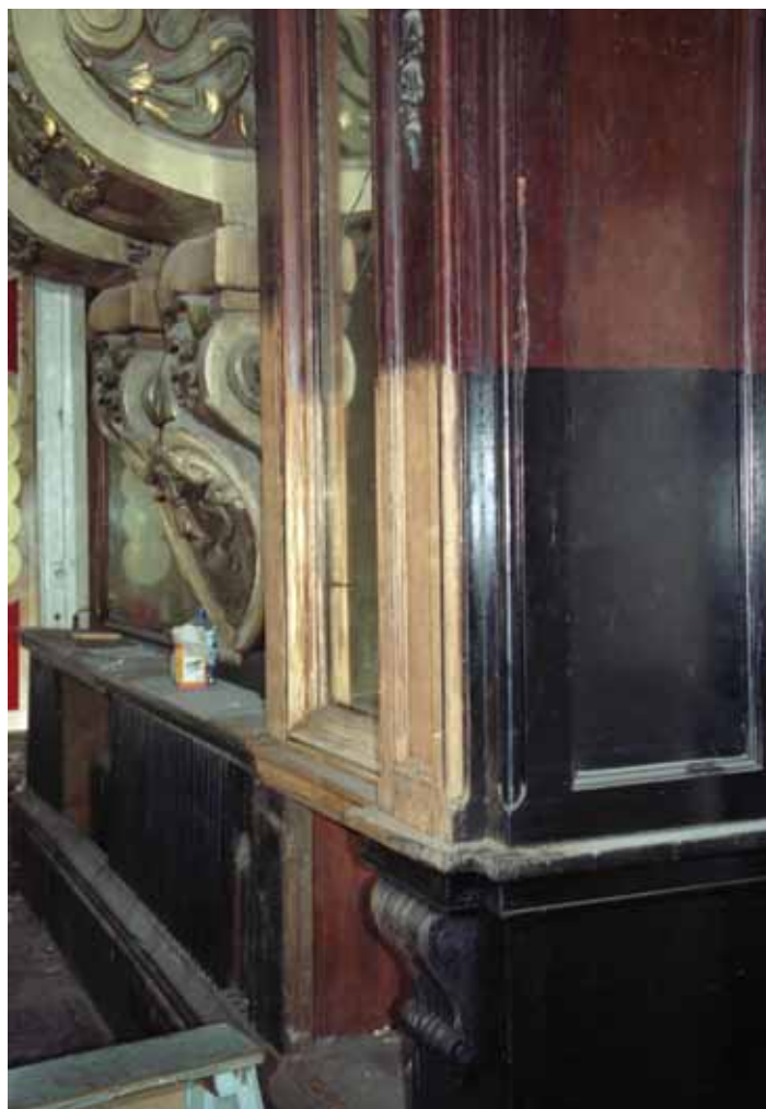
Реставрация мебели: корпус шкафа, частично «освобожденный» от черного лака.
