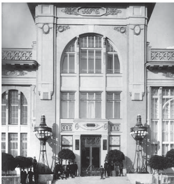
Центральный вход в ресторан «Яр», 1910-е годы.
