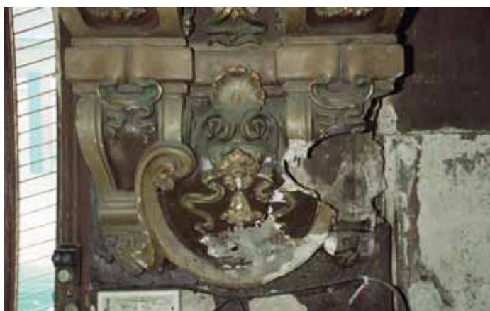
Фрагмент настенной лепнины до начала реставрационных работ.
