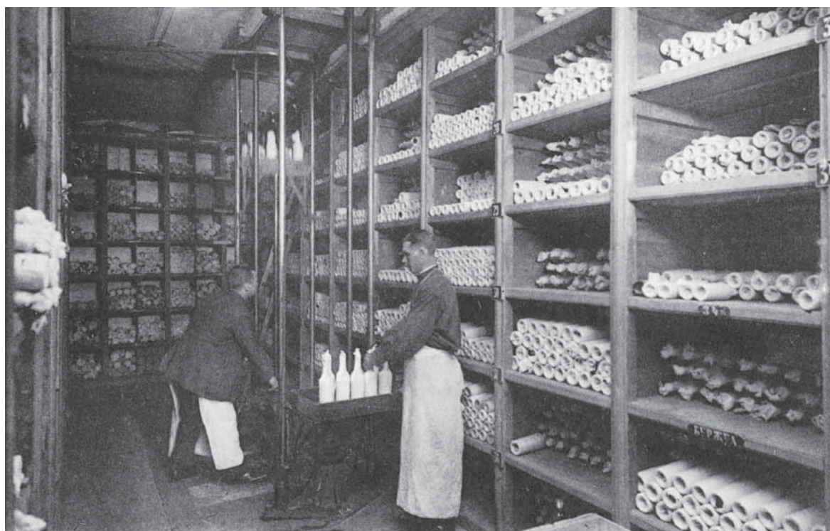
Склад в подвале. Подъемные механизмы для доставки товаров в зал.
