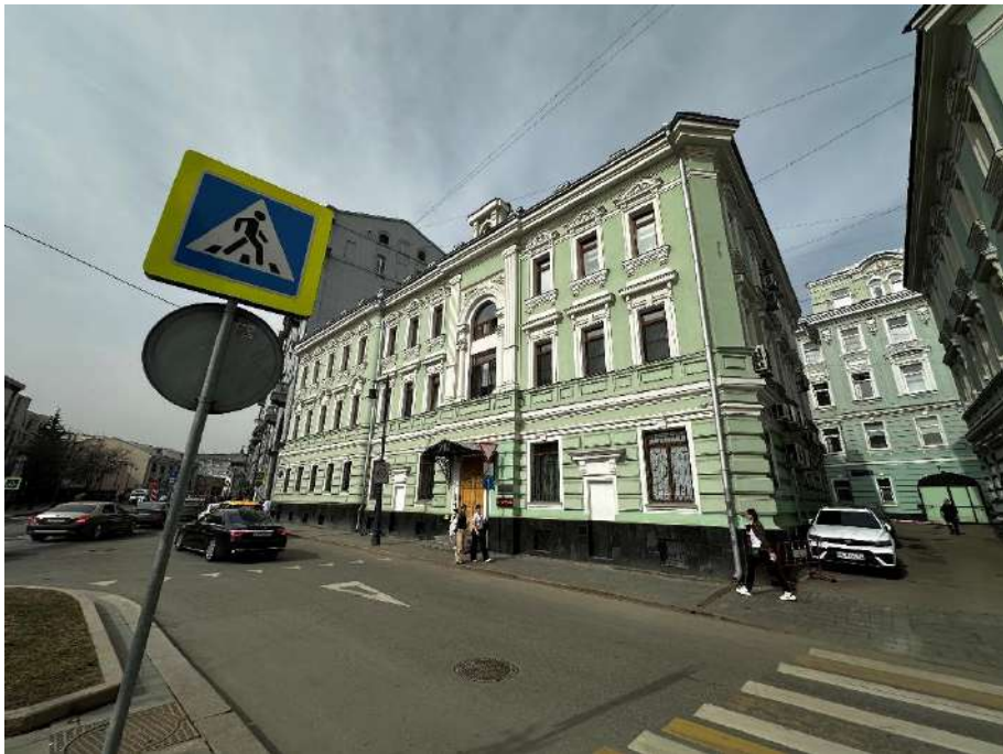
Фото №2. Вид на восточный фасад здания с ул. Солянка.
