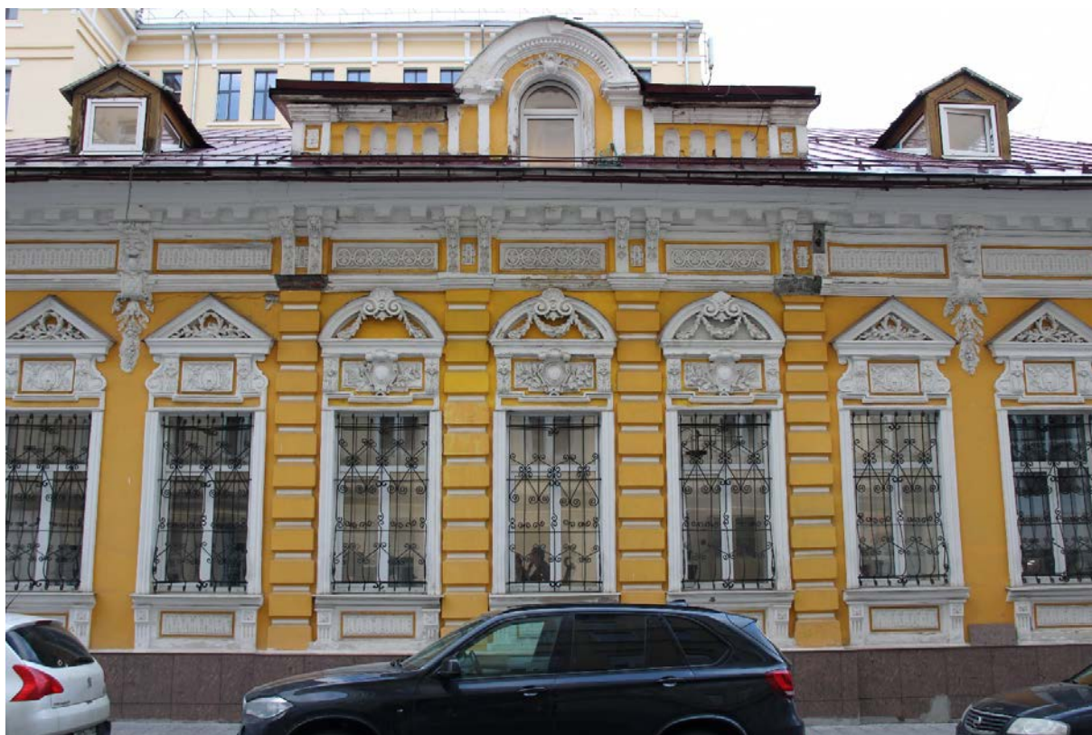
3. Центральная часть южного фасада
