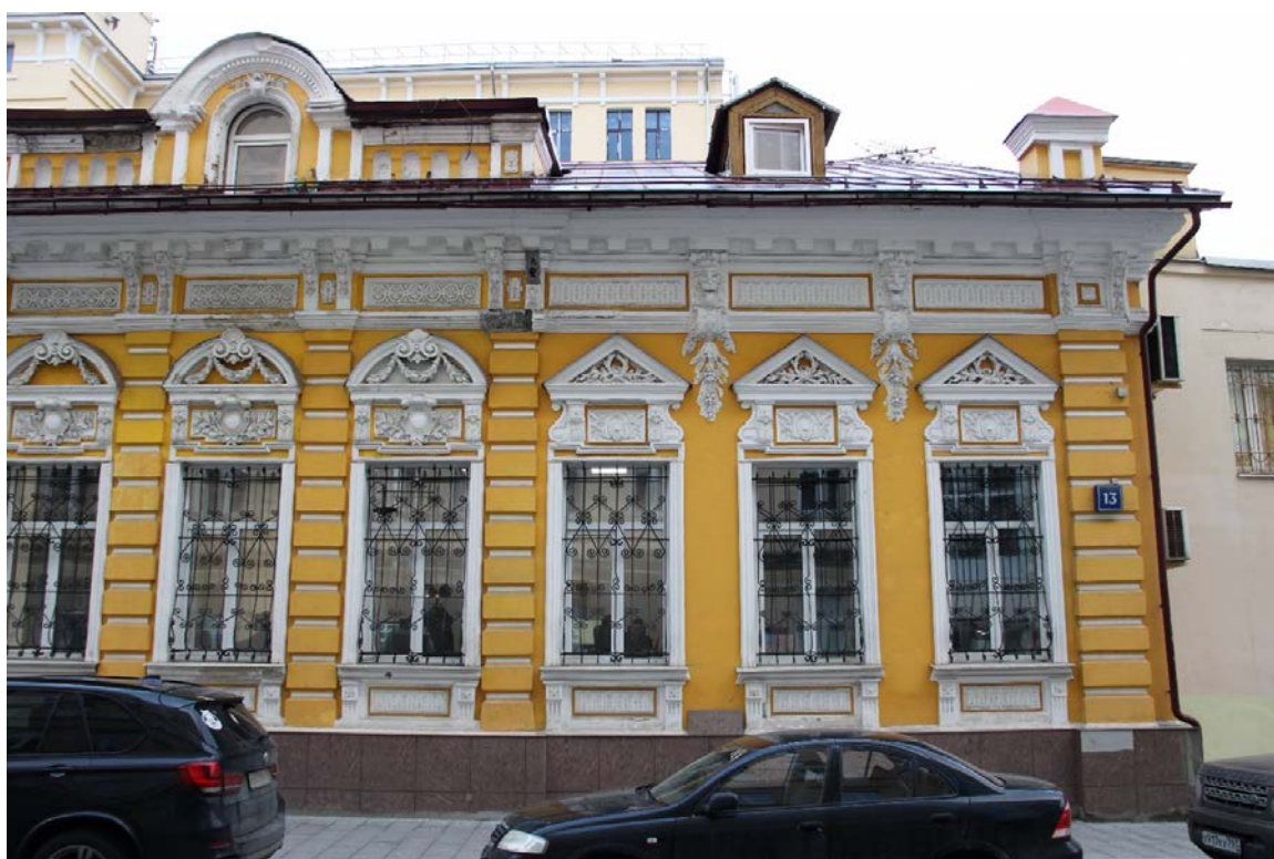
2. Фрагмент главного фасада. Восточная часть
