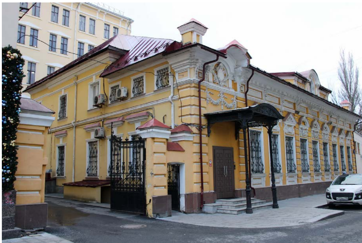
7. Юго-западный угол здания
