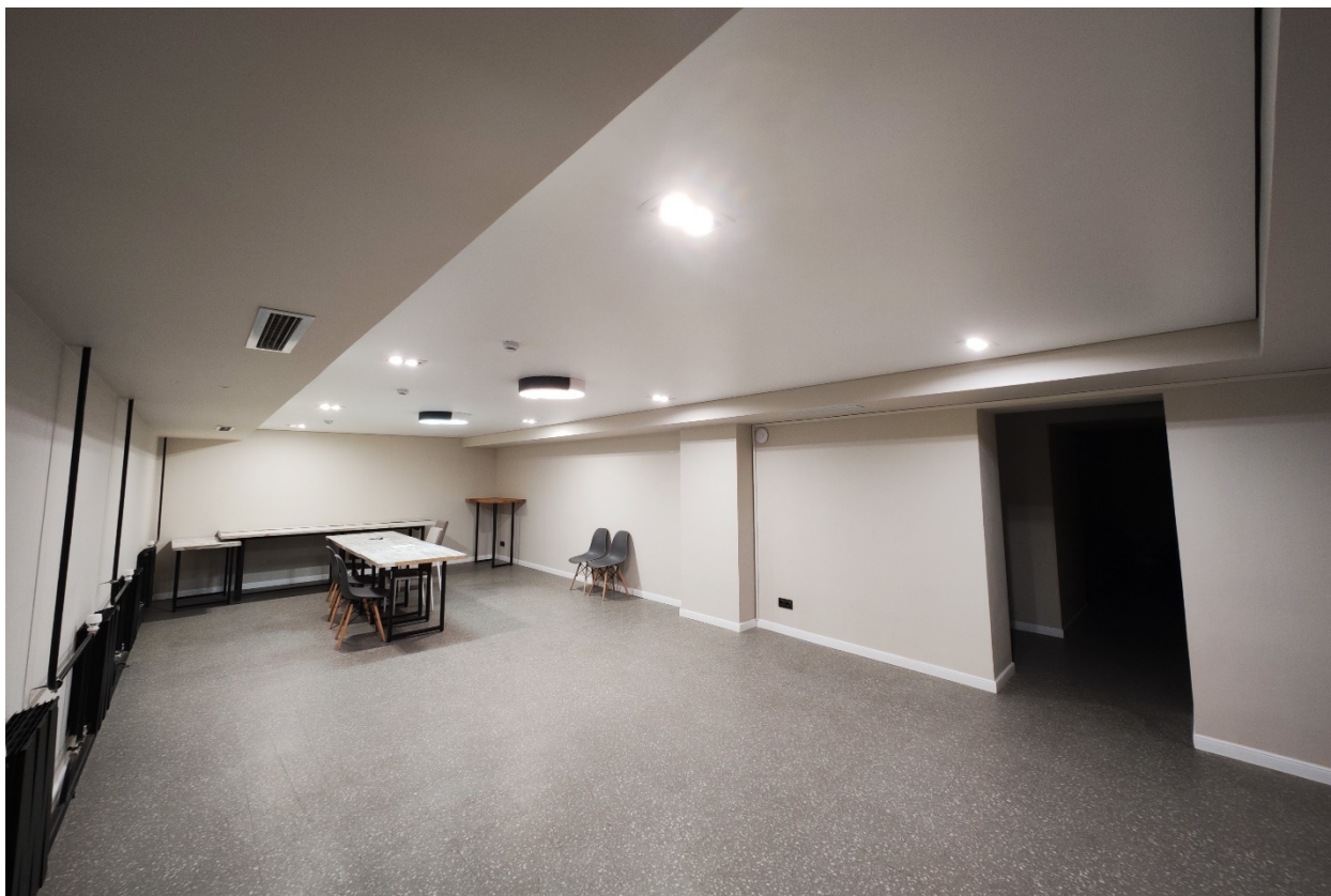
1. Помещение подвального этажа
