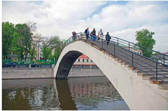
Конструк- тивистский мостик через Водоотводный канал
