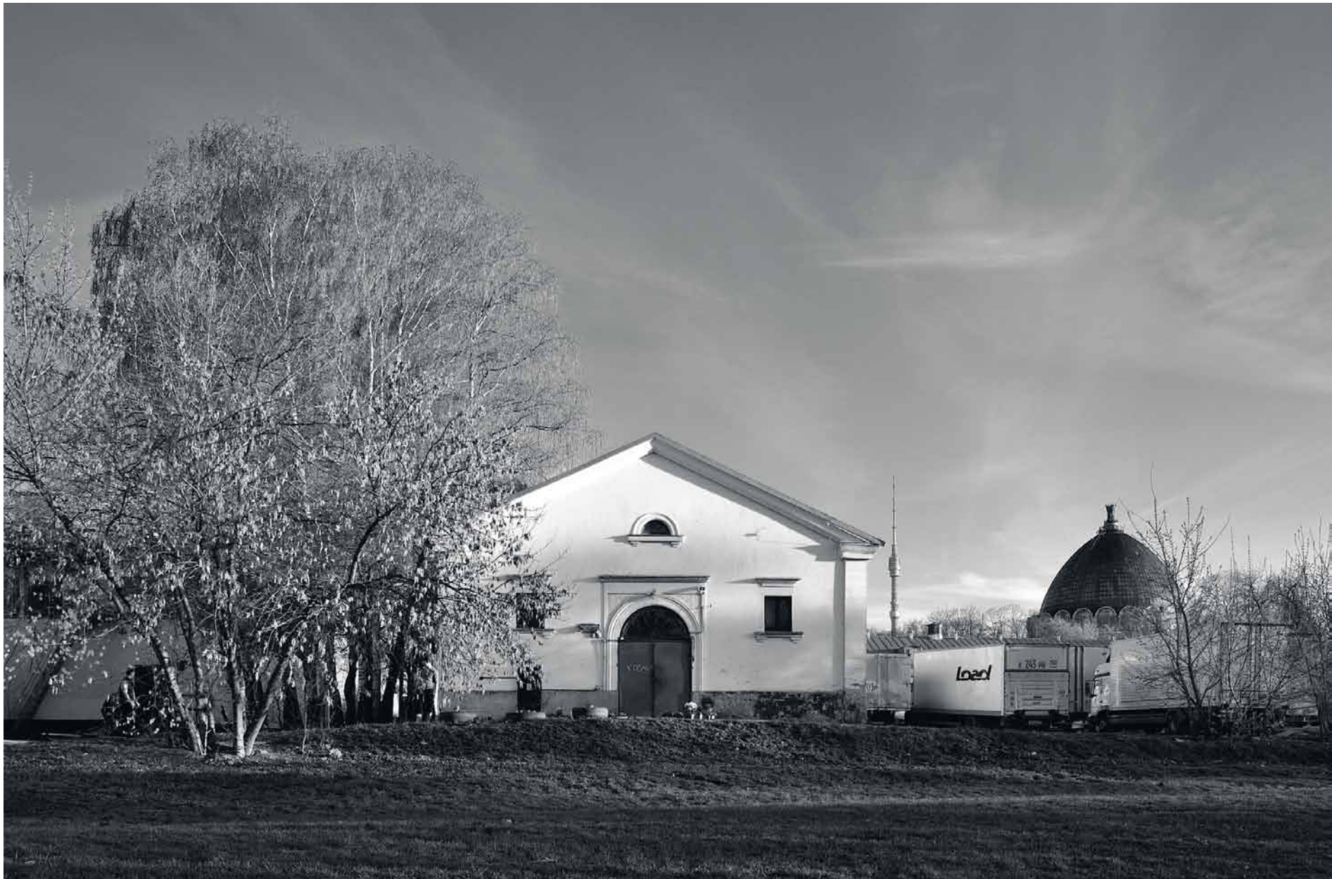
Павильон «Коневодство». Вид со стороны пруда. 1953, арх. М. Титов
