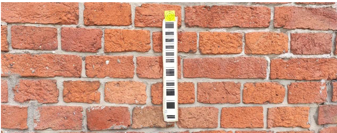
Рис. 14 Конструкция деформационной марки в виде штрих-кодовой наклейки металлический стержень (анкер), выступающий на 10-20 мм из железобетонной (кирпичной) конструкции и заходящий в нее не менее чем на 45 мм или грунтового массива/отмостки наблюдаемого сооружения, располагается на уровне 0,3-0,6 м. от поверхности земли или перекрытия, на котором производятся измерения. Верх стержня предназначен для установки рейки (рисунок 3);
