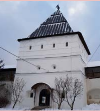
«Башня пятигранная на западной стене» (Крестьянская пл., д. 10, стр. 29)
