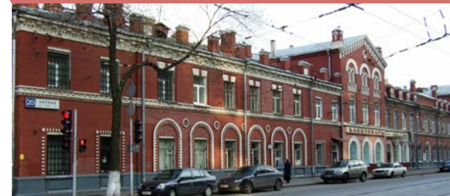
▶ «Ансамбль Миусского трамвайного депо, 1874 г., 1908-1910 гг., 1930-е гг., арх.: Н.К. Жуков, М.Н. Глейнин, инж.: Н.А. Сытенко, В.Г. Шухов» (ул. Лесная, д. 20)
