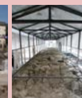
Раскрытие кладки стены
