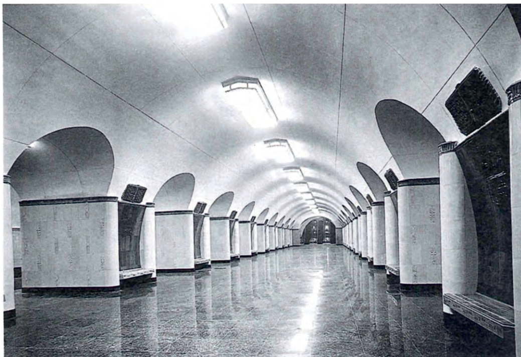
Из книги: Московское метро: Подземный памятник архитектуры / сост. И.В. Чепкунова, М.А. Костюк, Е.Ю. Желудкова. М., 2016. Станция метро «Рижская». Перронный зал. Фотография А.А. Александрова 1958 г.
