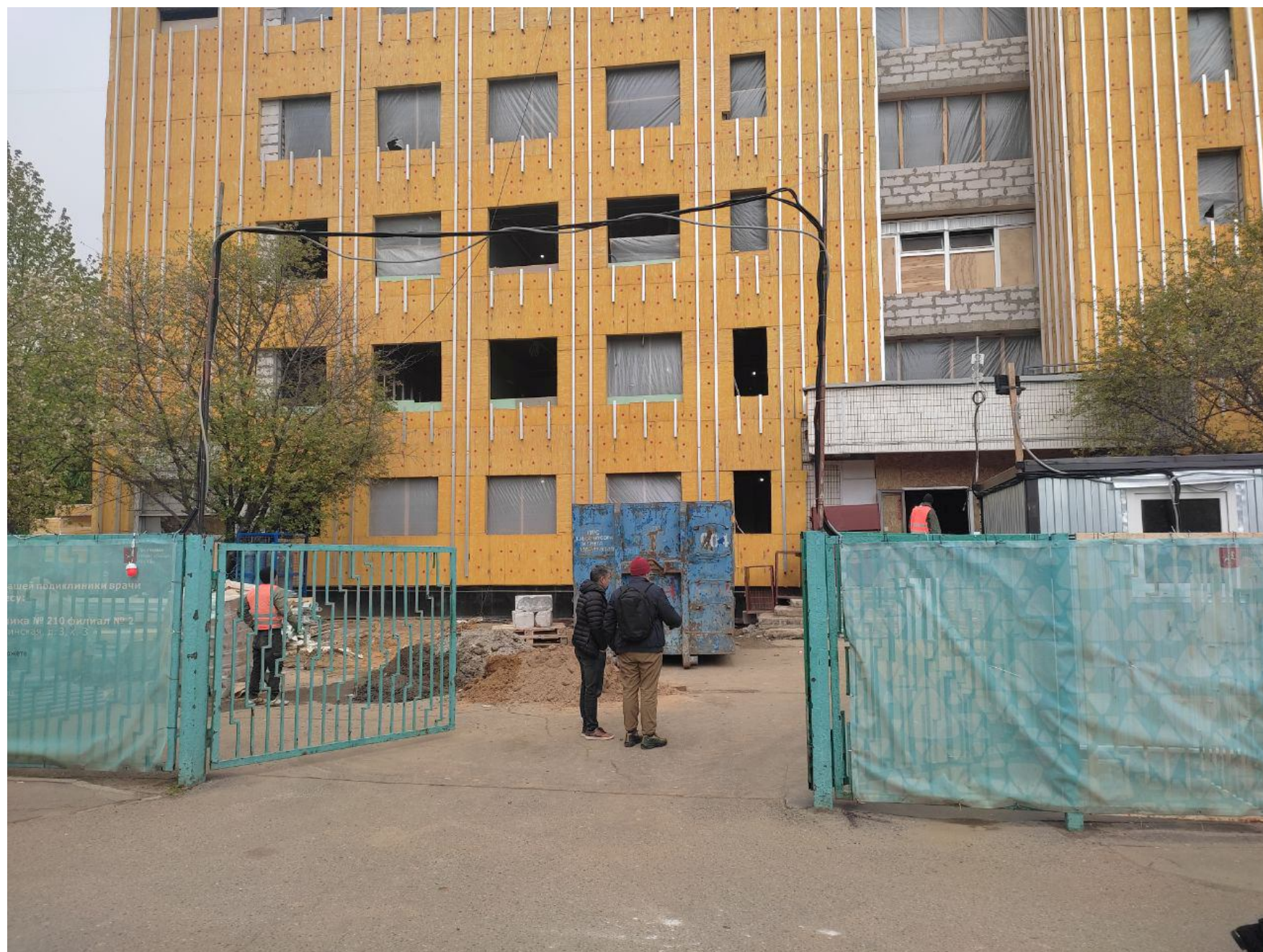
Илл. 15. Исследуемый участок. Современное состояние.
