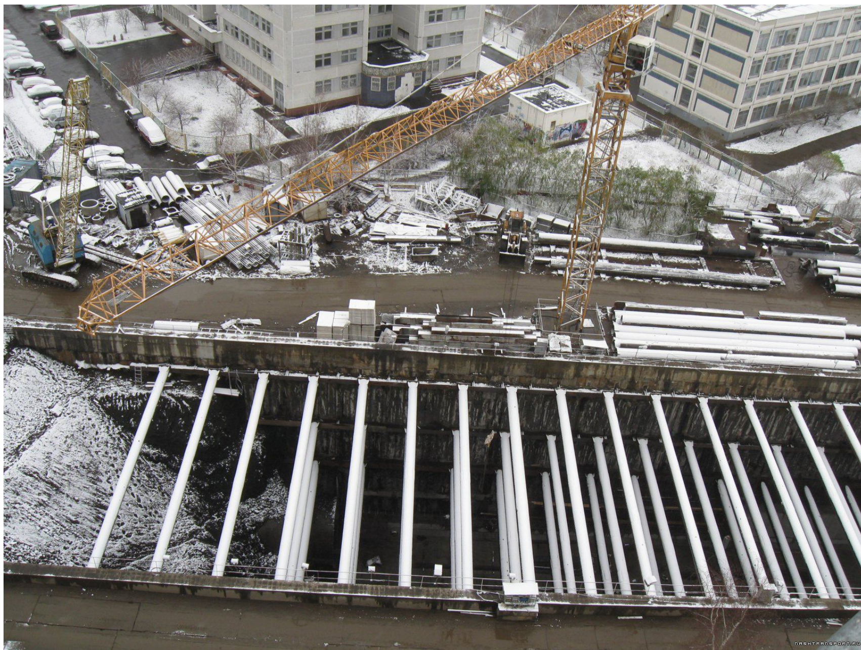
Илл. 12. Строительство выхода станции метро «Борисово». Источник: https://www.nashtransport.ru/uploads/1290340871/large.gallery_13974_199_1963397.jpg.ee5b235f342ea884b62f2e17218d6fda.jpg Снимок 2010 г. Вид с востока.
