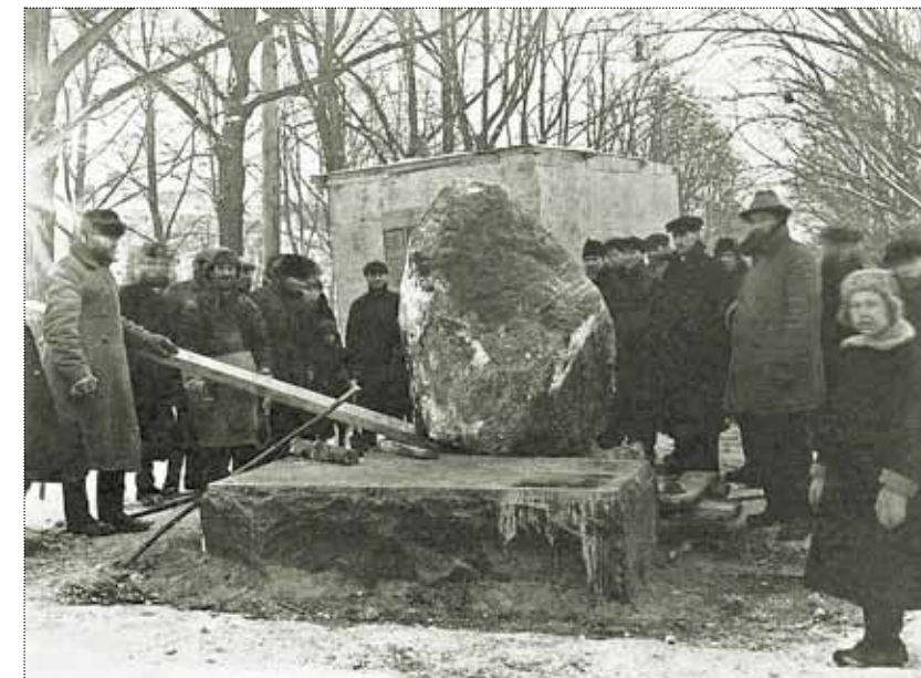
Производство работ по постановке памятника на Новинском бульваре. Фото: ГЦТМ А.А. Бахрушина, 1929 год
