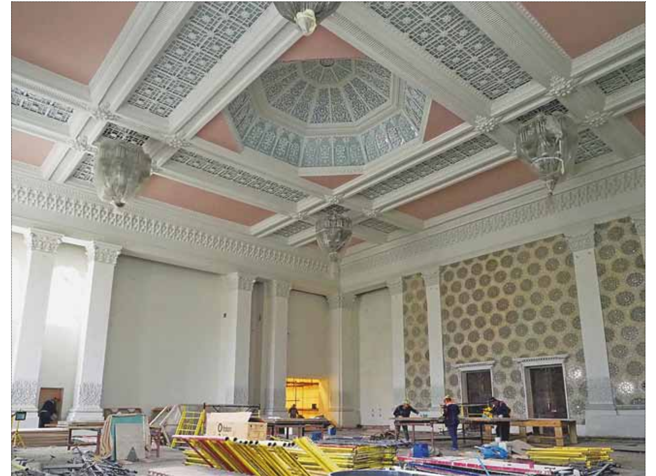
На данный момент в павильоне № 66 завершены все работы по реставрации дверей, окон и люстр. Фото: АО «ГК «ЕКС», 2018 год
