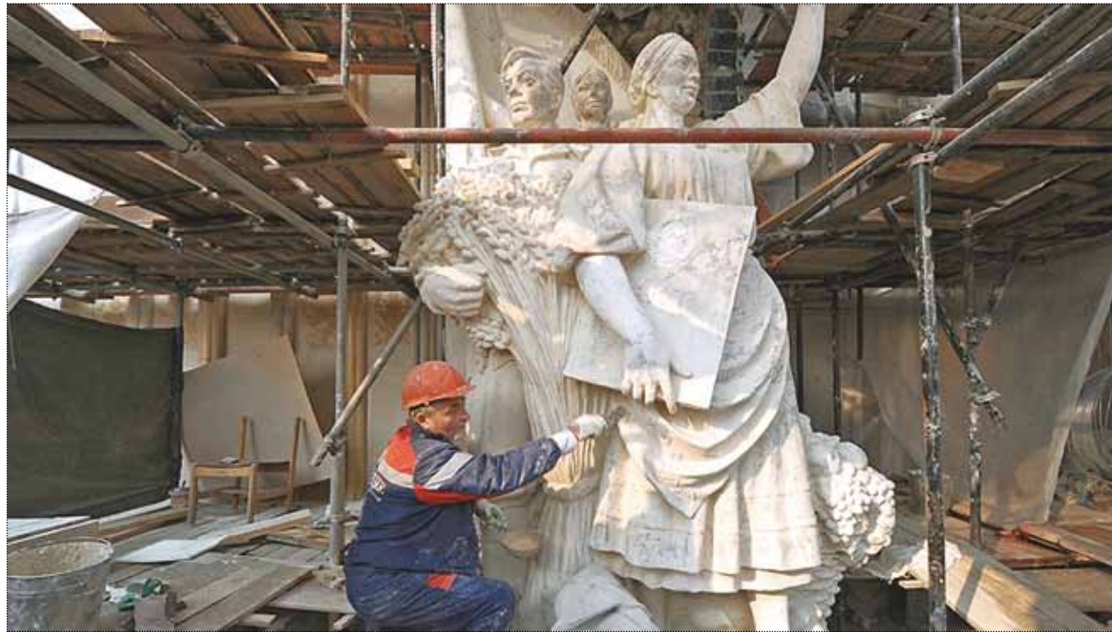
Павильон № 58 «Земледелие» («Украинская ССР»). Сейчас здесь восстанавливают декоративные решетки, капители, керамические панно, герб главного фасада, поверхности основания и внутреннего витража ротонды, металлические флагштоки, основание шпиля и другие детали. Фото: Мосгорнаследие, 2017 год
