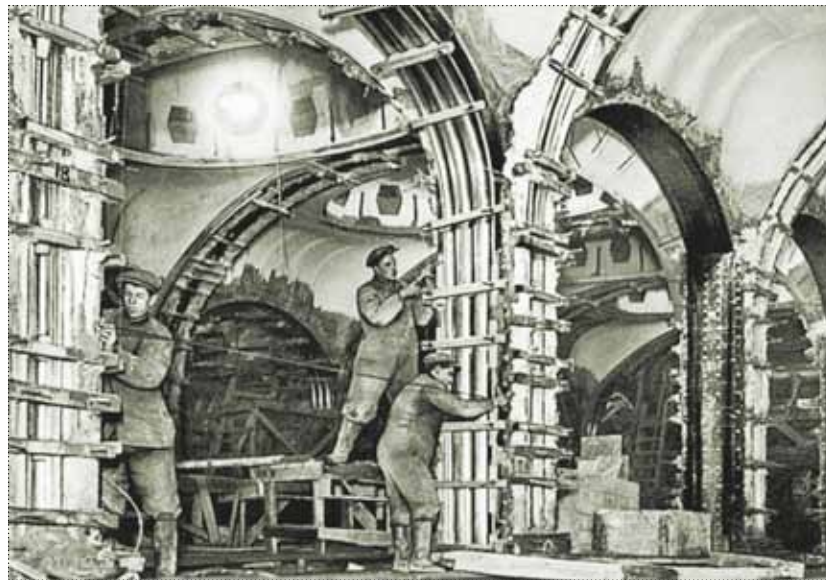
Монтаж колонн на станции «Маяковская». Фото 1937–1938 годов
