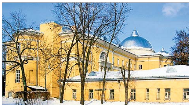
4-я Градская больница (бывшая Павловская). Внизу: главный корпус и фрагмент ризалита западного фасада
