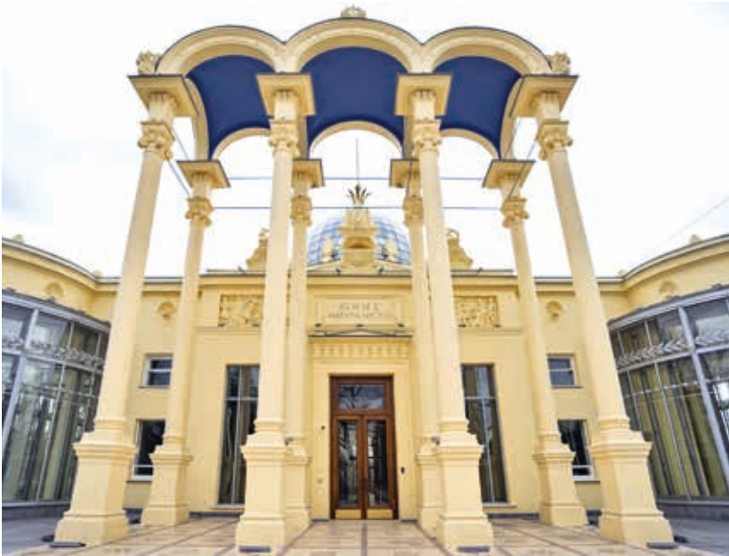
(1) Фрагмент главного фасада. Колоннада после завершения работ. 2025 год
