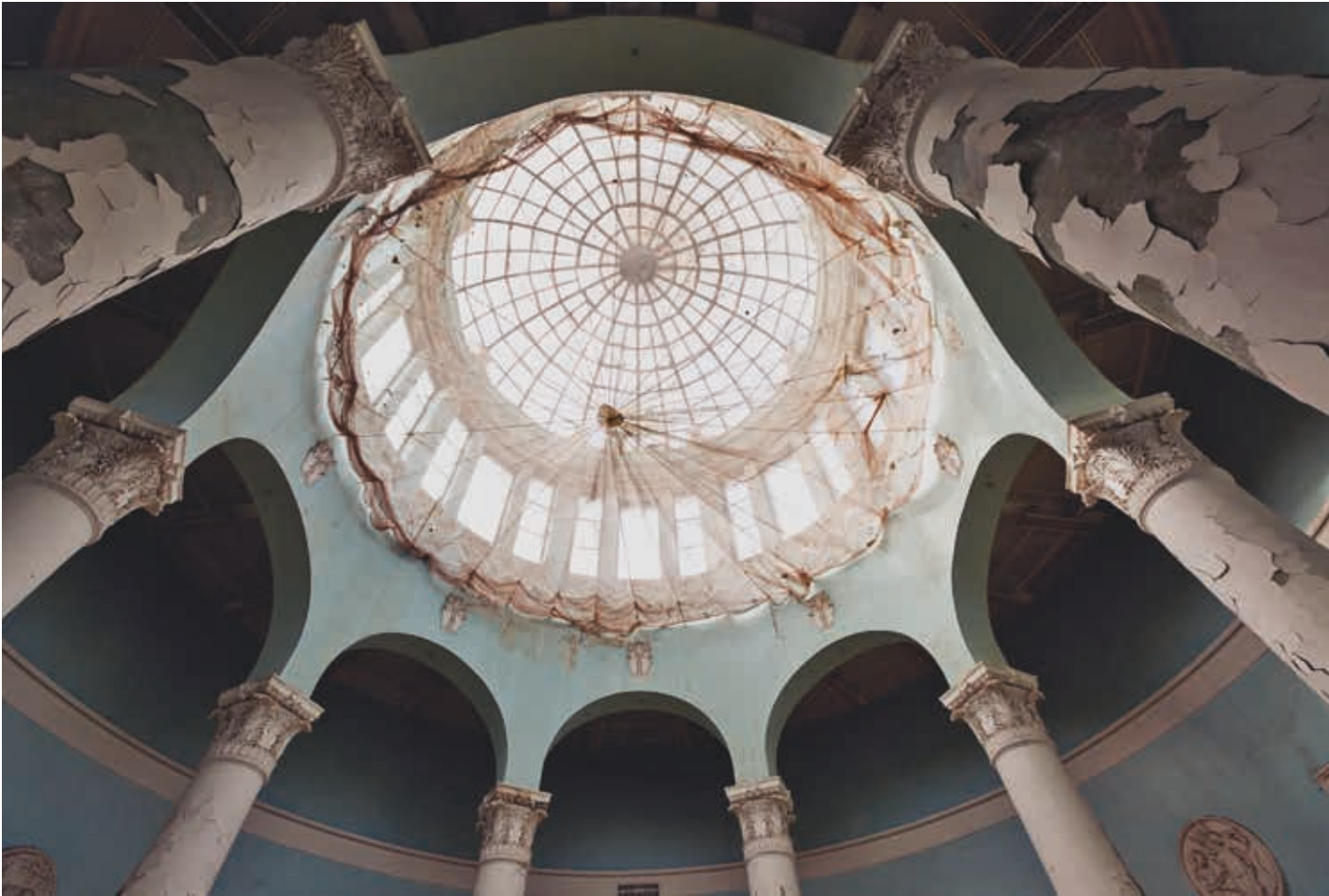
(7) Зал организационной работы до реставрации. 2019 год
