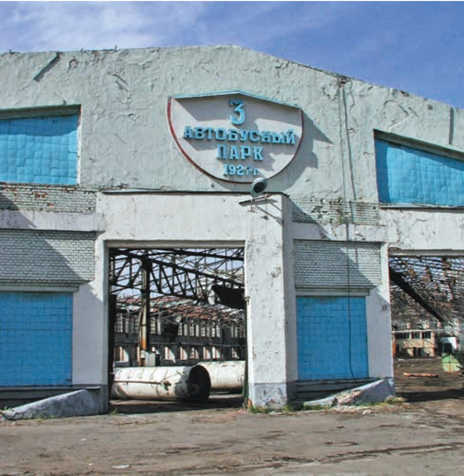
Бахметьевский автобусный гараж (ул. Образцова, д. 11, стр. 1А). Общий вид центральной части главного (восточного) фасада до реставрации. Фото 2001 года
