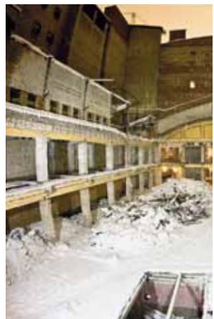
Вид после разбора конструкций атриума в январе 2012 года
