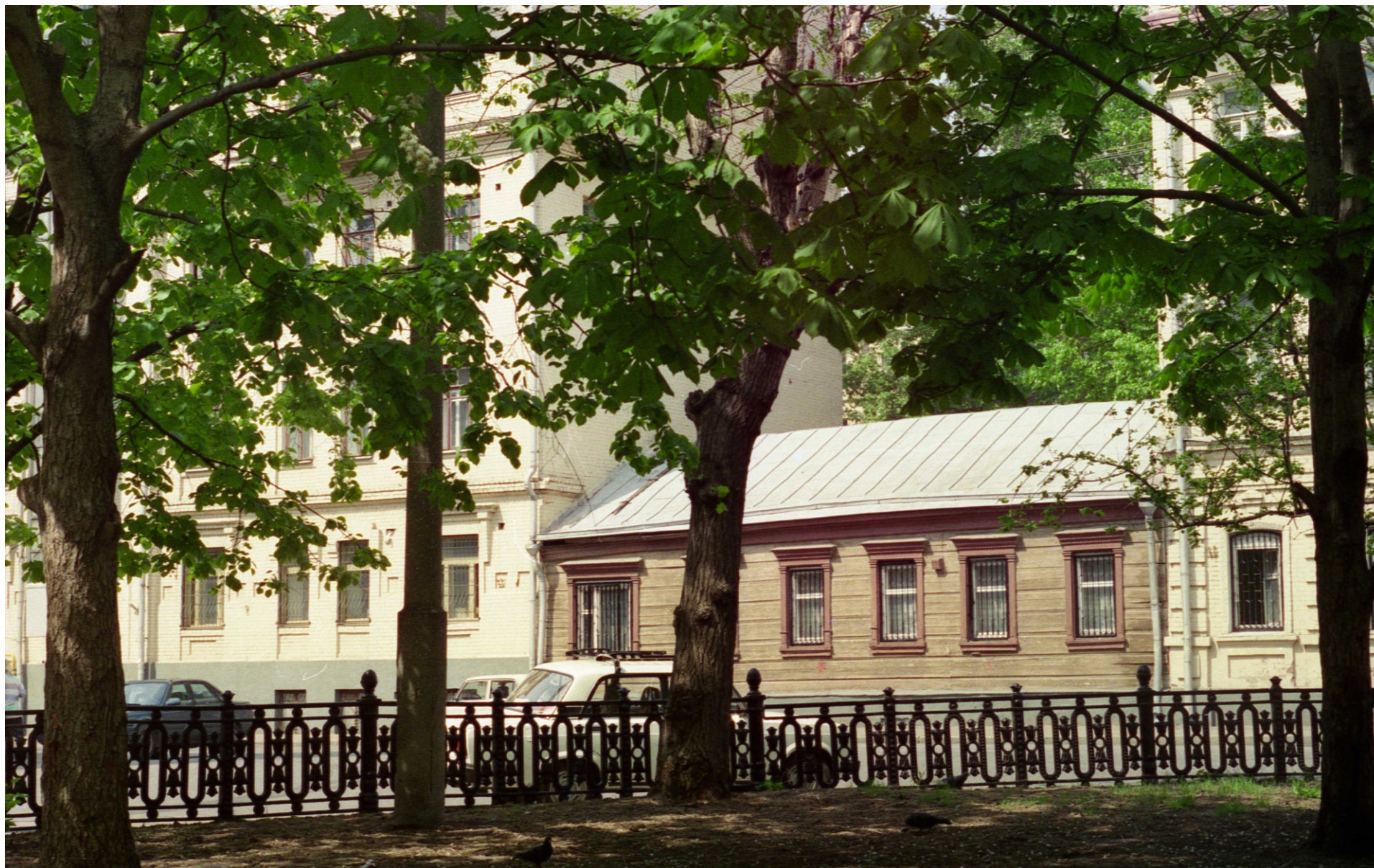
Илл. 18. Переулок Каменная Слобода, д. 2/1. Автор: Л. Б. Арутюнян. Источник: https://pastvu.com/p/1171907 Снимок 1996-1997 г. Вид с юго-востока.
