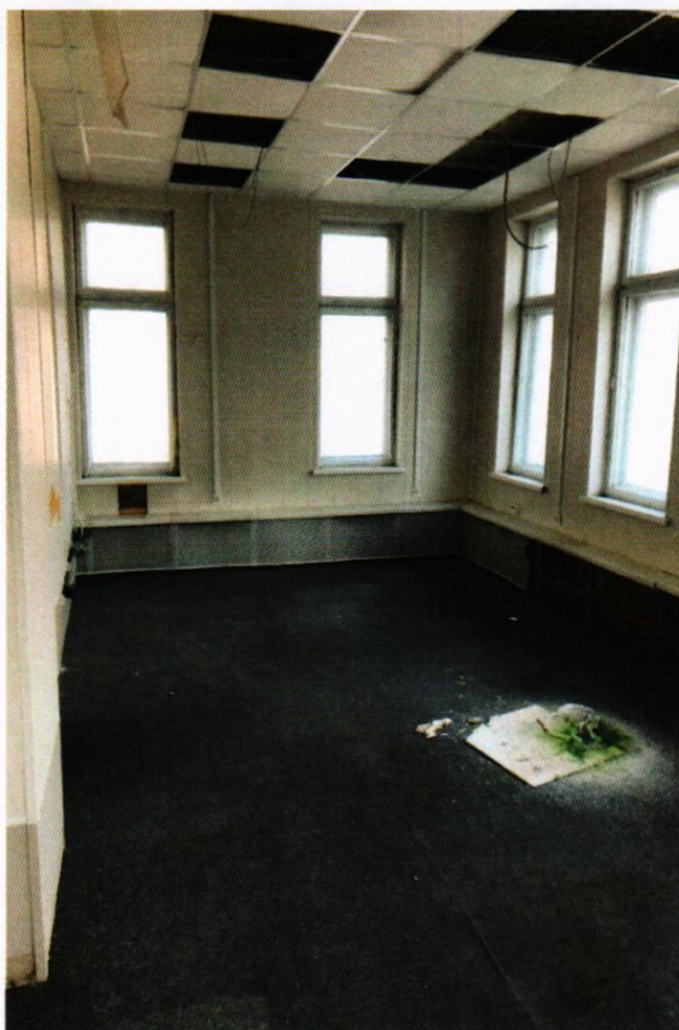
Фото 13. Фрагмент интерьера. 2-й этаж. Напольное покрытие – ковролин.
