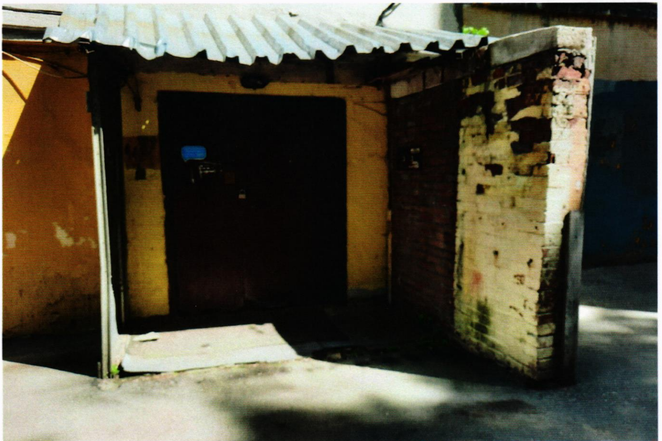
Фото 6. Вид с запада. Боковой фасад. Металлическое дверное заполнение.
