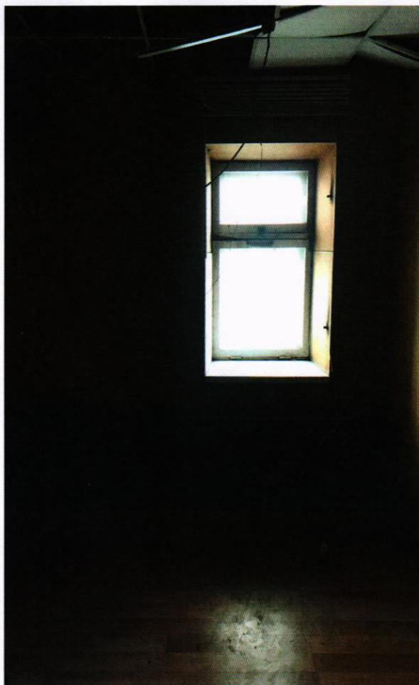
Фото 11. Фрагмент интерьера. 1-й этаж. Навесной потолок.
