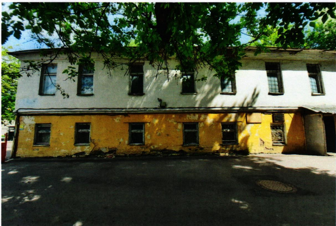
Фото 9. Вид с запада. Боковой фасад. Скатная кровля.
