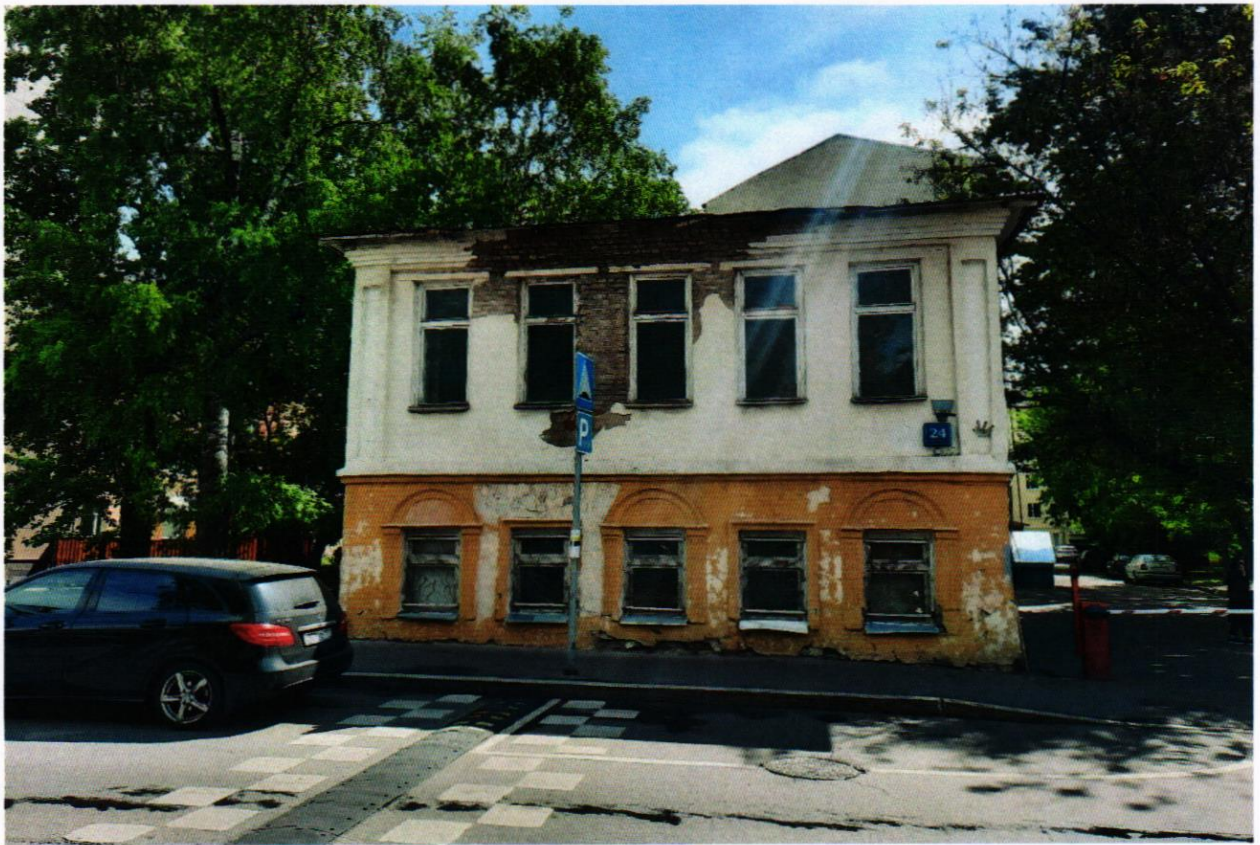
Фото 3. Вид с северо-запада. Главный фасад. Угловые пилястры.
