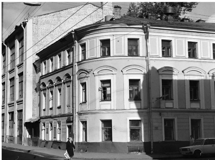
Вид с Большого Златоустинского переулка на здание школы М.Ф. Казакова. 1987г.
