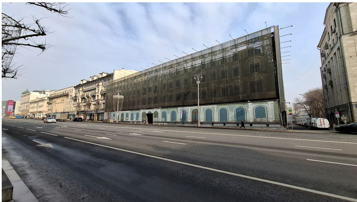
Т.ф. №7. Общий вид на Объект с юга.
