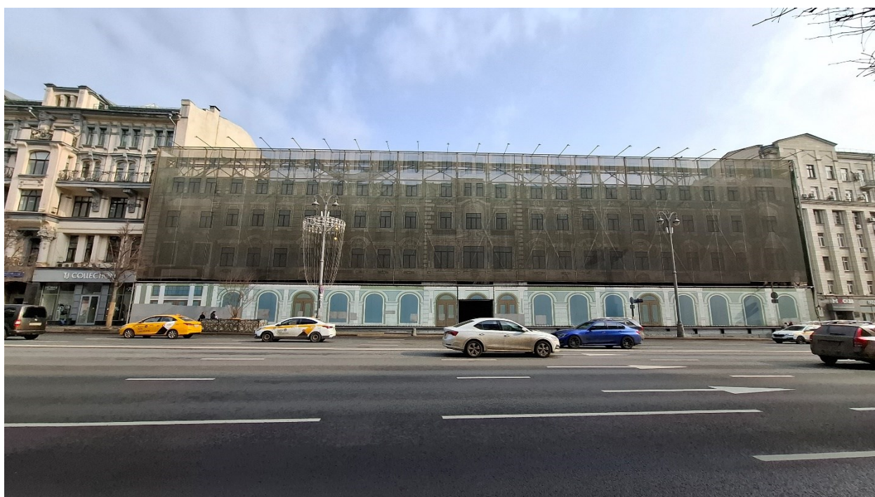
Т.ф. №6. Общий вид на Объект с юго-запада.
