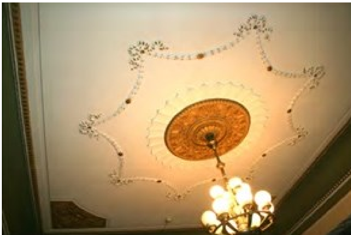
Т.ф. №39. Вид на потолочную лепнину и люстру лестничной площадки парадной лестницы второго этажа Объекта.
