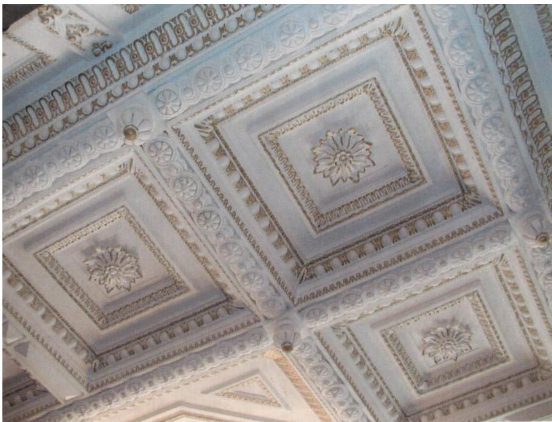
Т.ф. №16. Вид на лепнину потолка бывшей булочной первого этажа Объекта.
