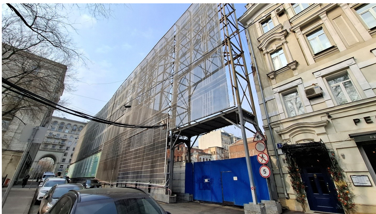
Т.ф. №14. Общий вид на Объект с востока.
