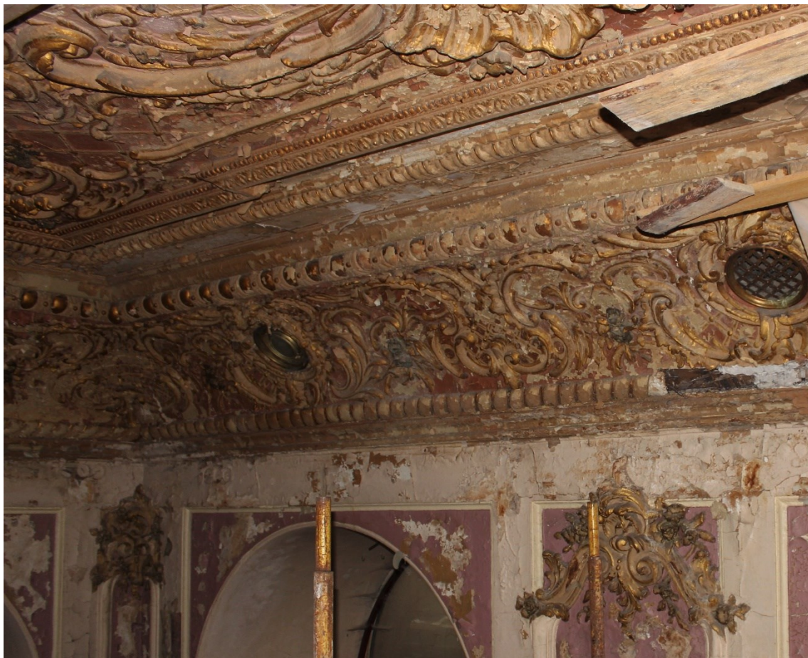
Т.ф. №24. Вид на фрагмент лепнины потолка бывшей кофейни первого этажа Объекта.
