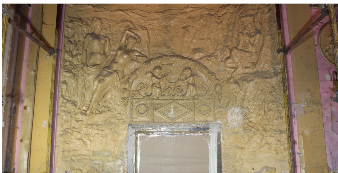
Т.ф. №26. Вид на фрагмент декоративной настенной лепнины ресторана первого этажа Объекта.
