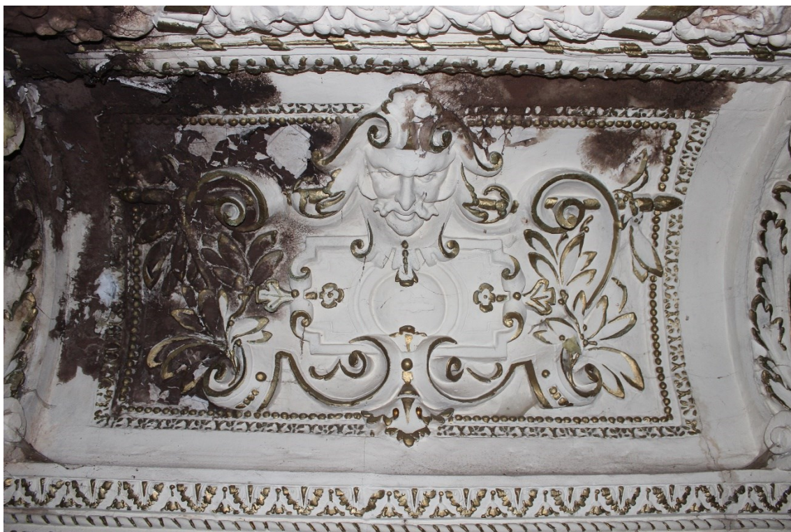
Т.ф. №20. Вид на фрагмент лепнины кондитерской первого этажа Объекта.
