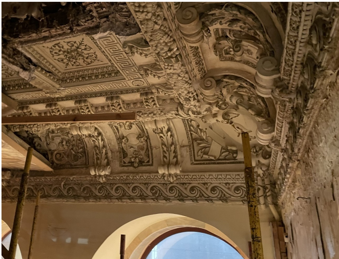
Т.ф. №18. Вид на лепнину потолка кондитерской первого этажа Объекта.
