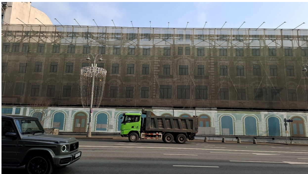
Т.ф. №5. Общий вид на Объект с юго-запада.
