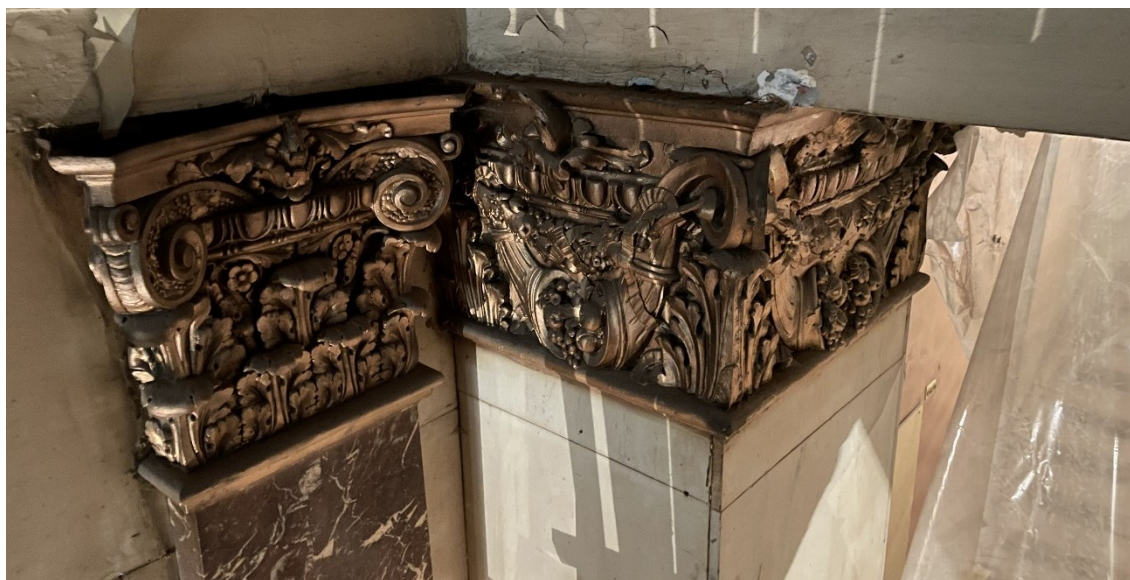
Т.ф. №32. Вид на фрагмент декоративных капителей вестибюля первого этажа Объекта.
