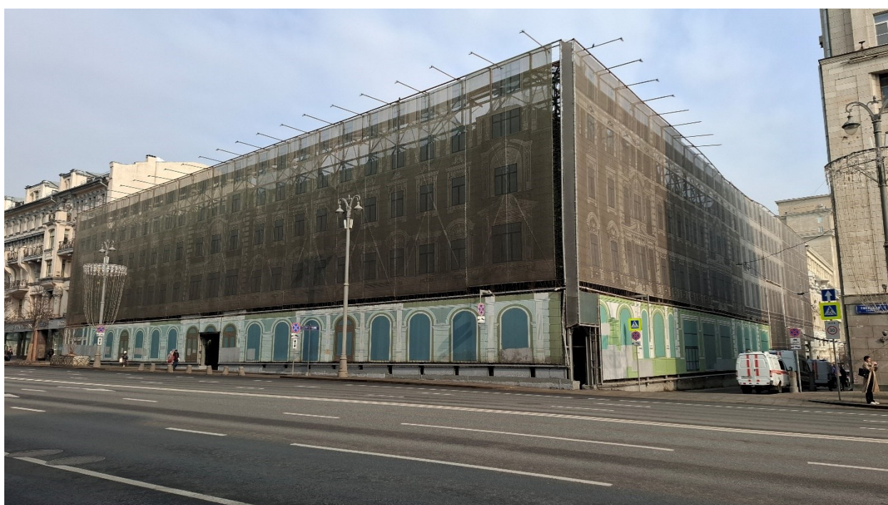
Т.ф. №8. Общий вид на Объект с юга.
