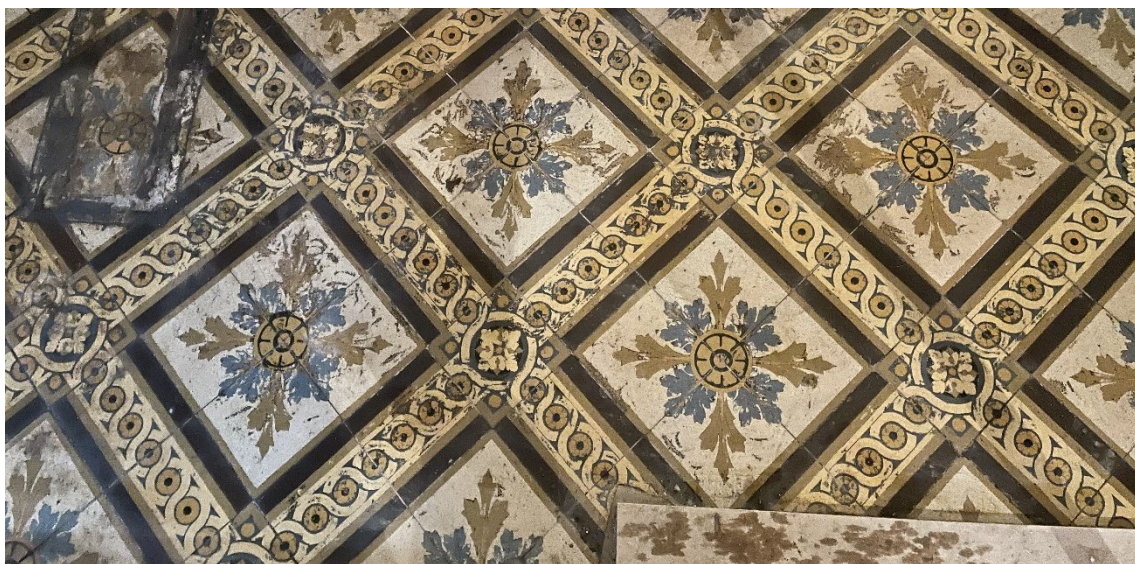
Т.ф. №23. Вид на фрагмент покрытия пола бывшей кофейни первого этажа Объекта.
