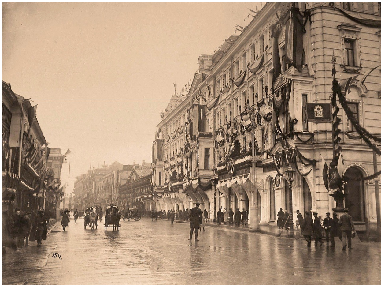
51. Вид празднично украшенных к торжествам коронации домов на Тверской улице. Вид на фасады Объекта. Период создания: 1896 г. Направление съемки: север. Источник: https://pastvu.com/p/223961
