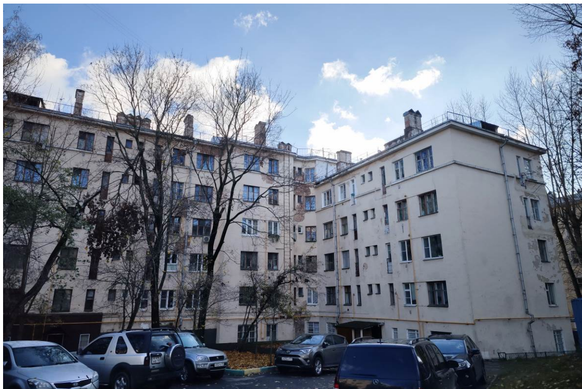
Фото 8. Вид корпуса с северо-западной стороны по адресу: ул. Преображенский Вал, корп. 1 (дата съемки октябрь 2024 г.)
