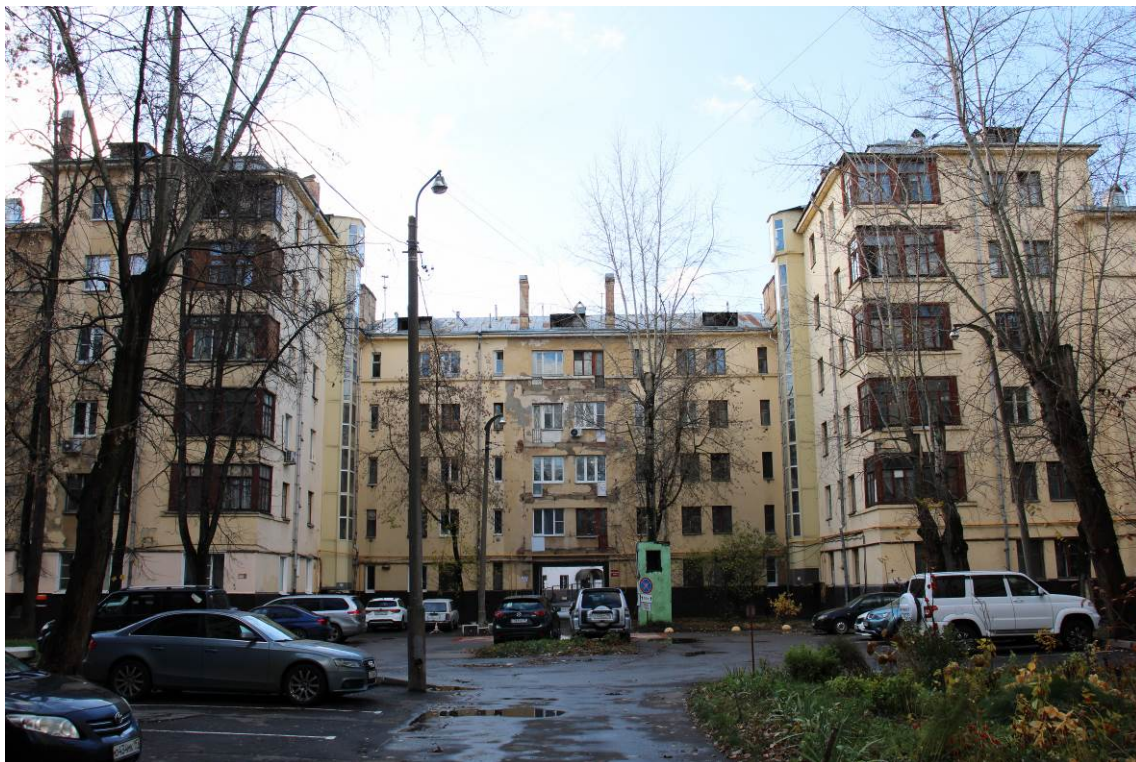
Фото 7. Вид корпуса с северо-восточной стороны по адресу: ул. Преображенский Вал, корп. 6 (дата съемки октябрь 2024 г.)
