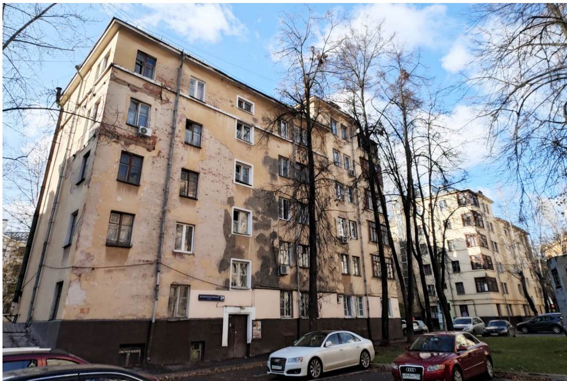
Фото 9. Вид корпуса с северо-восточной стороны по адресу: ул. Преображенский Вал, корп. 6 (дата съемки октябрь 2024 г.)
