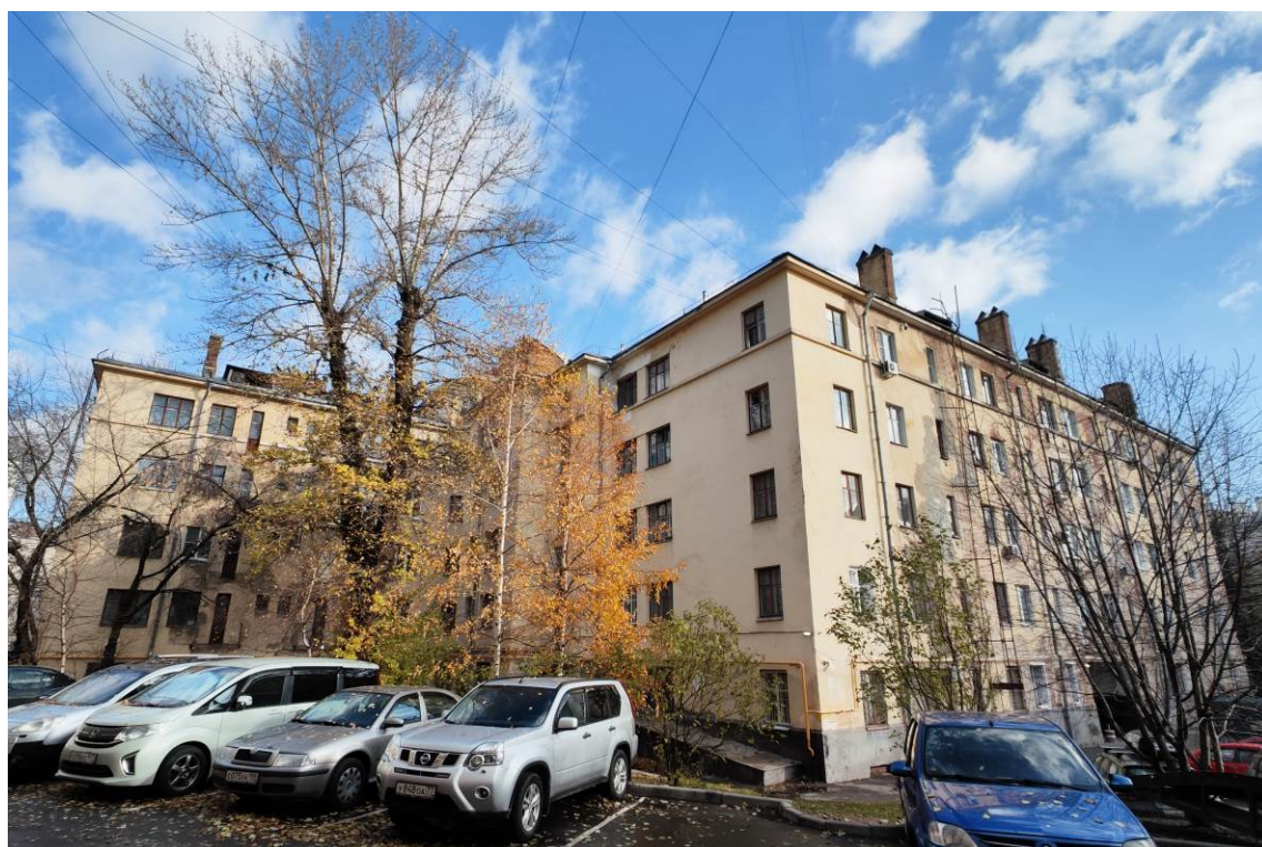
Фото 2. Вид корпуса с северо-восточной стороны по адресу: ул. Преображенский Вал, корп. 6 (дата съемки октябрь 2024 г.)
