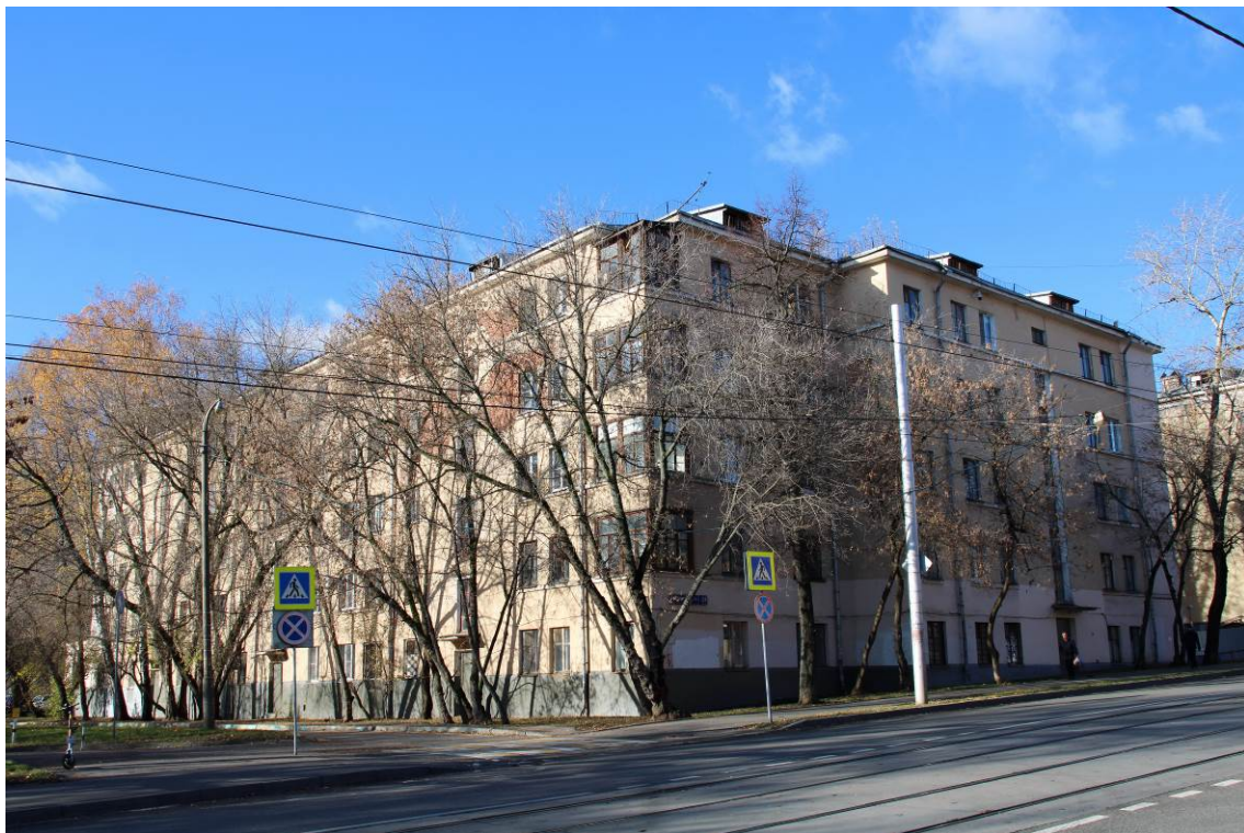
Фото 4. Вид корпуса с северо-восточной стороны по адресу: ул. Преображенский Вал, корп. 3 (дата съемки октябрь 2024 г.)
