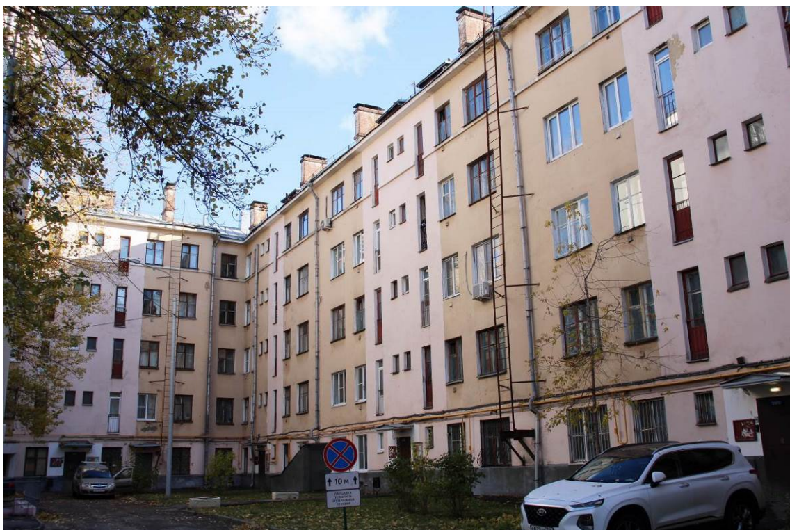
Фото 11. Вид корпуса с северо-восточной стороны по адресу: ул. Преображенский Вал, корп. 3 (дата съемки октябрь 2024 г.)
