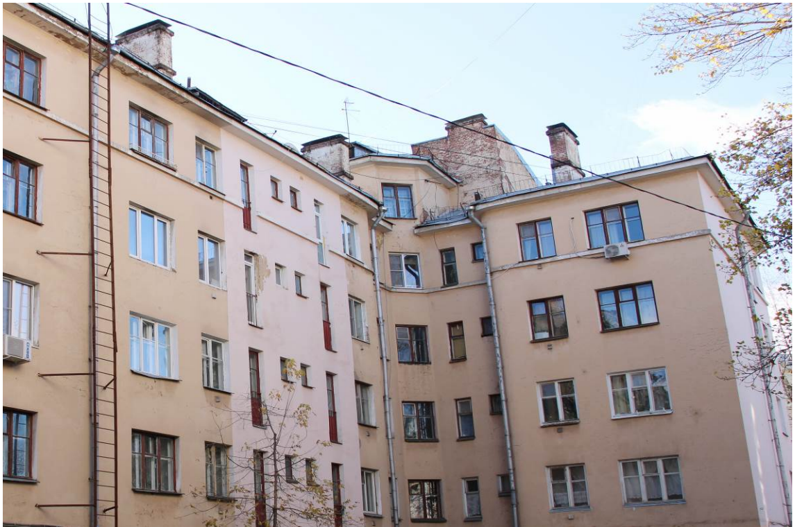
Фото 9. Вид корпуса с северо-восточной стороны по адресу: ул. Преображенский Вал, корп. 3 (дата съемки октябрь 2024 г.)
