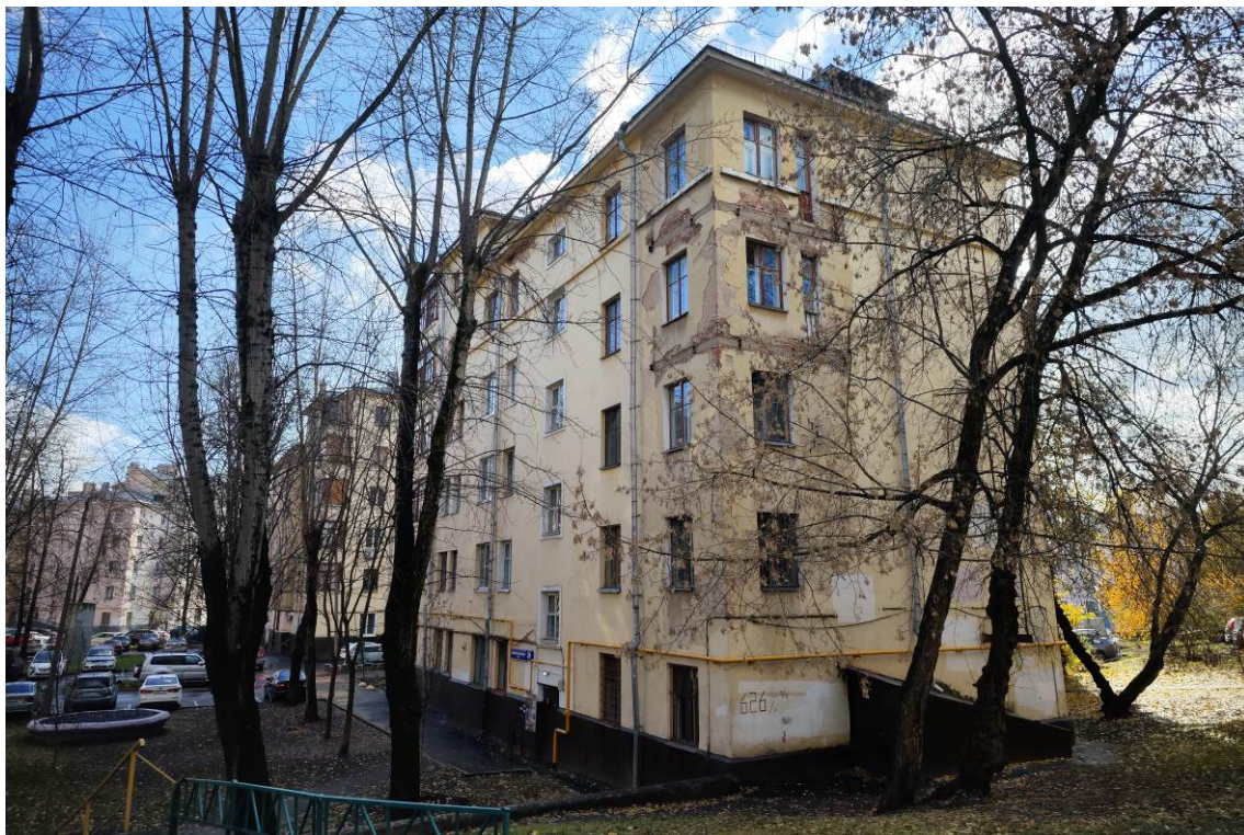
Фото 5. Вид корпуса с северо-восточной стороны по адресу: ул. Преображенский Вал, корп. 6 (дата съемки октябрь 2024 г.)
