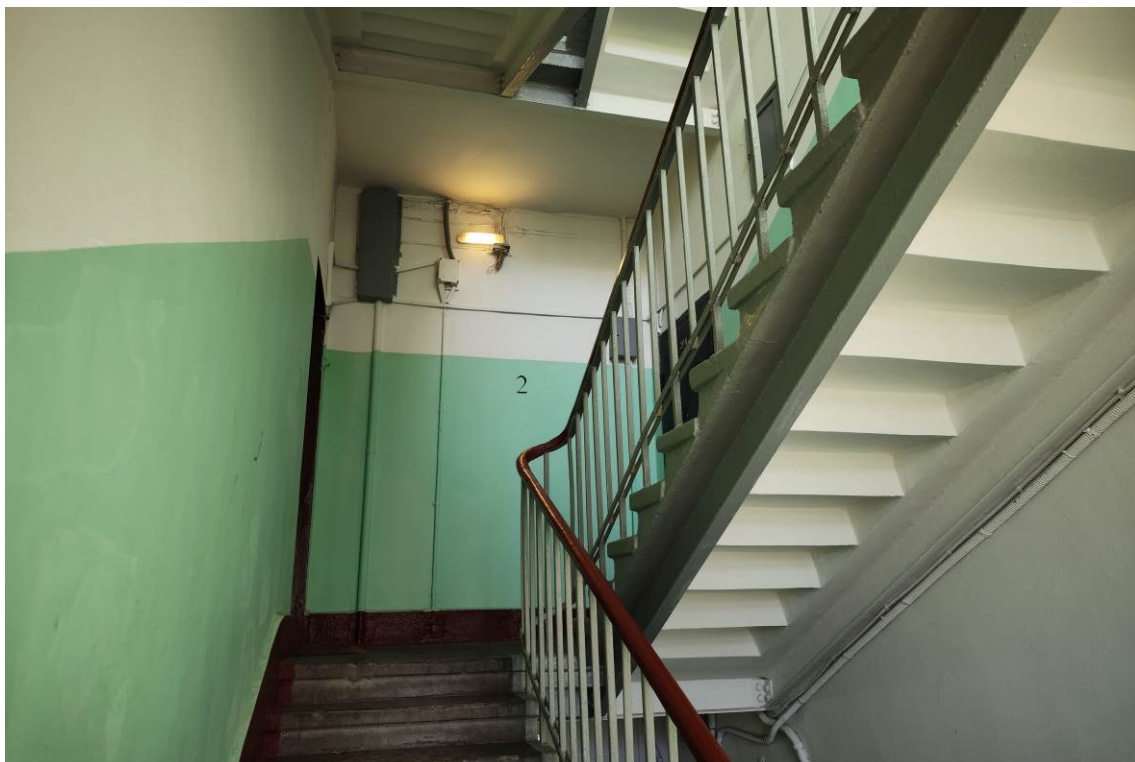
Фото 12. Вид интерьера подъезда по адресу: ул. Преображенский Вал, д. 24, кор. 3 (дата съемки октябрь 2024 г.)
