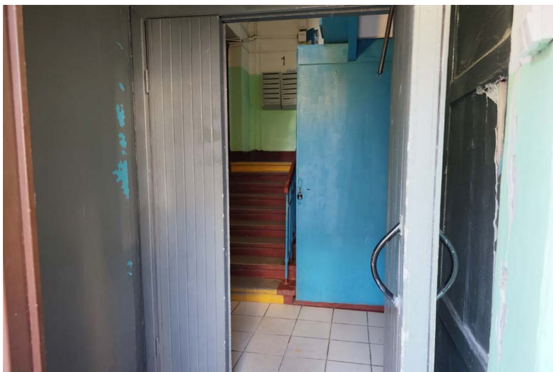
Фото 2. Вид интерьера подъезда по адресу: ул. Преображенский Вал, д. 24, кор. 6 (дата съемки октябрь 2024 г.)
