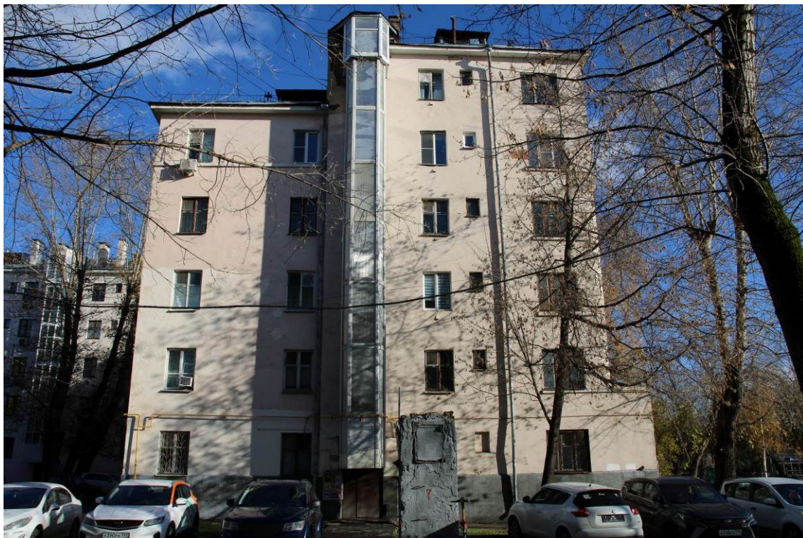
Фото 7. Вид корпуса с северо-восточной стороны по адресу: ул. Преображенский Вал, корп. 3 (дата съемки октябрь 2024 г.)
