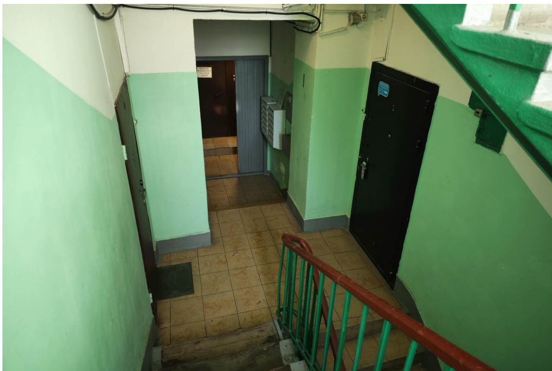
Фото 2. Вид интерьера подъезда по адресу: ул. Преображенский Вал, д. 24, кор. 1 (дата съемки октябрь 2024 г.)
