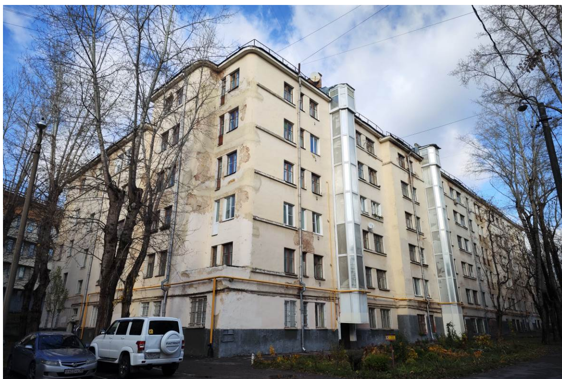
Фото 6. Вид корпуса с юго-запада по адресу: ул. Преображенский Вал, корп. 1 (дата съемки октябрь 2024 г.)
