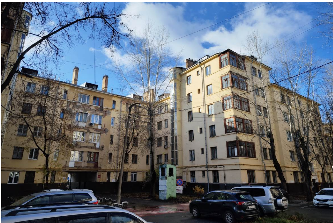
Фото 6. Вид корпуса с северо-восточной стороны по адресу: ул. Преображенский Вал, корп. 6 (дата съемки октябрь 2024 г.)
