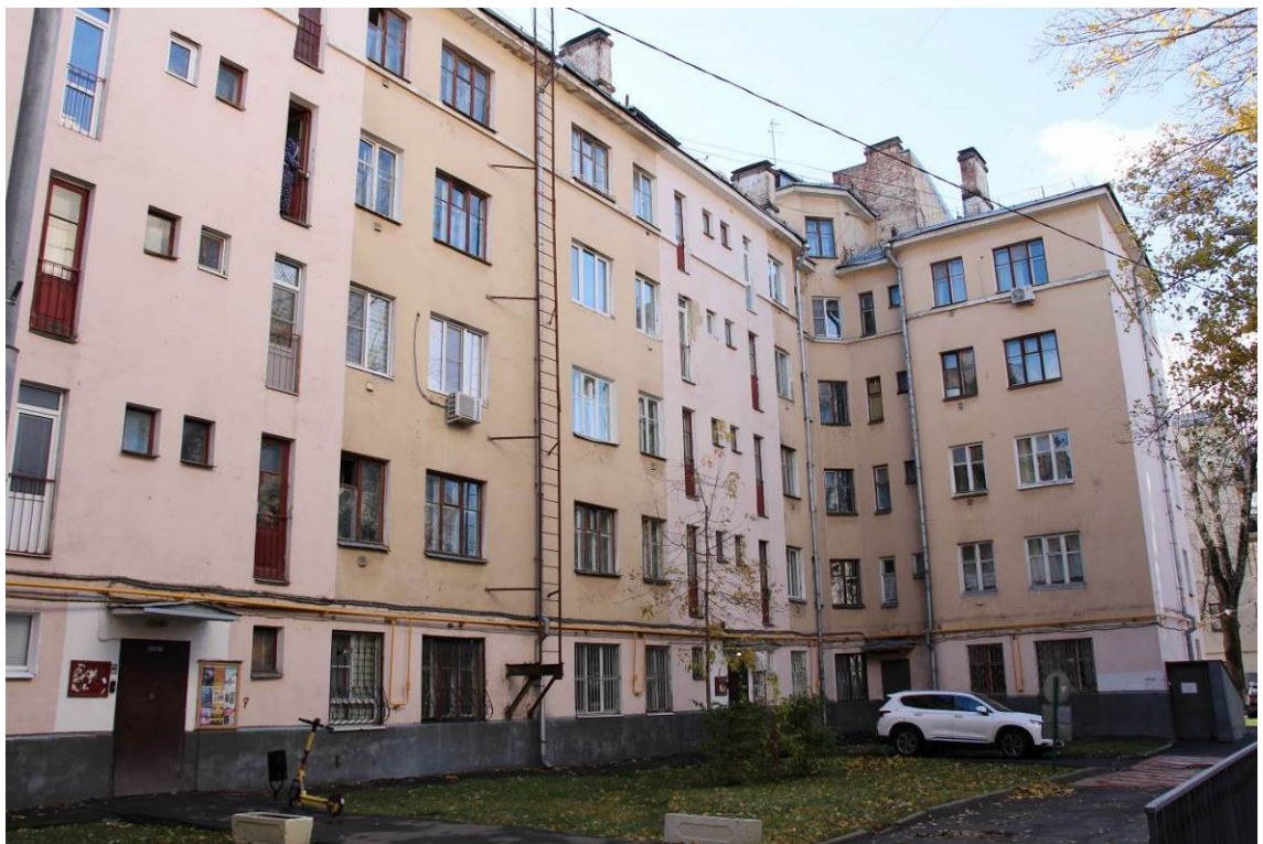
Фото 10. Вид корпуса с северо-восточной стороны по адресу: ул. Преображенский Вал, корп. 3 (дата съемки октябрь 2024 г.)
