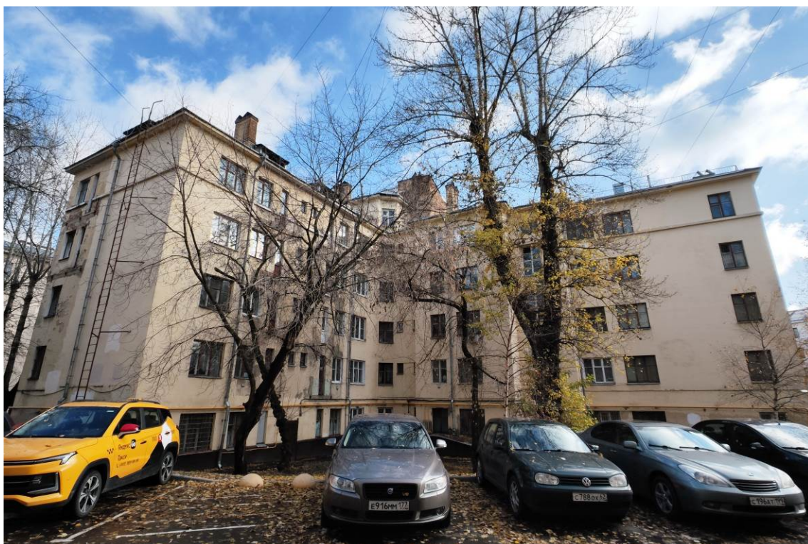
Фото 3. Вид корпуса с северо-восточной стороны по адресу: ул. Преображенский Вал, корп. 6 (дата съемки октябрь 2024 г.)
