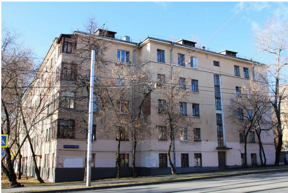
Фото 3. Вид корпуса с северо-восточной стороны по адресу: ул. Преображенский Вал, корп. 3 (дата съемки октябрь 2024 г.)
