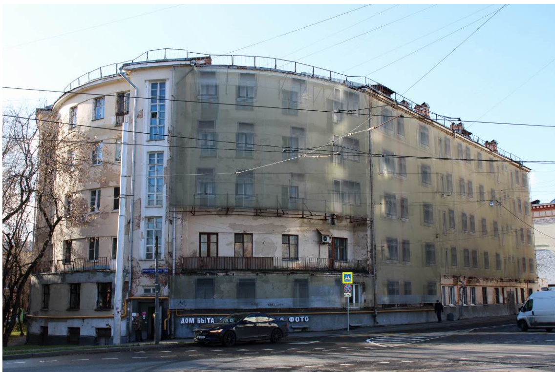
Фото 1. Вид корпуса с северо-восточной стороны по адресу: ул. Преображенский Вал, корп. 1 (дата съемки октябрь 2024 г.)
