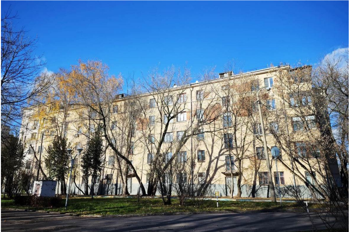
Фото 5. Вид корпуса с северо-восточной стороны по адресу: ул. Преображенский Вал, корп. 3 (дата съемки октябрь 2024 г.)
