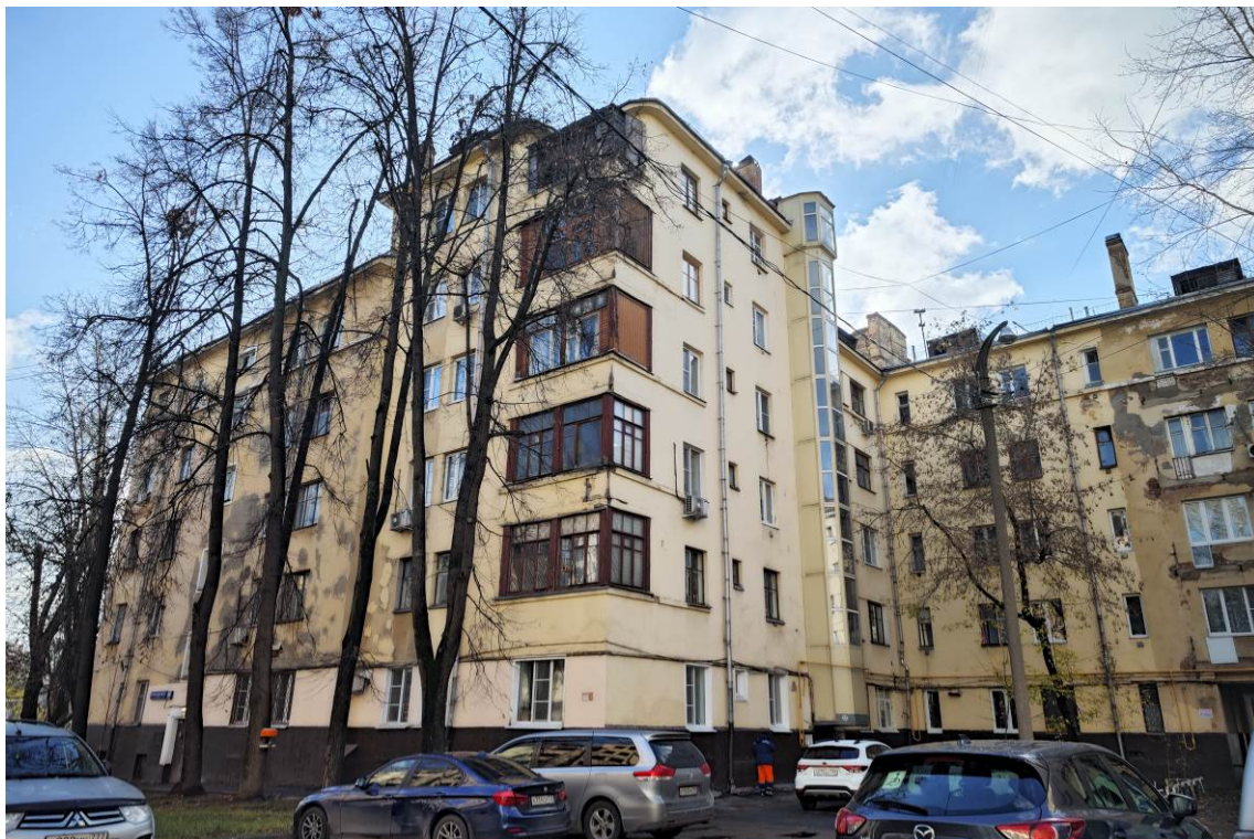
Фото 8. Вид корпуса с северо-восточной стороны по адресу: ул. Преображенский Вал, корп. 6 (дата съемки октябрь 2024 г.)
