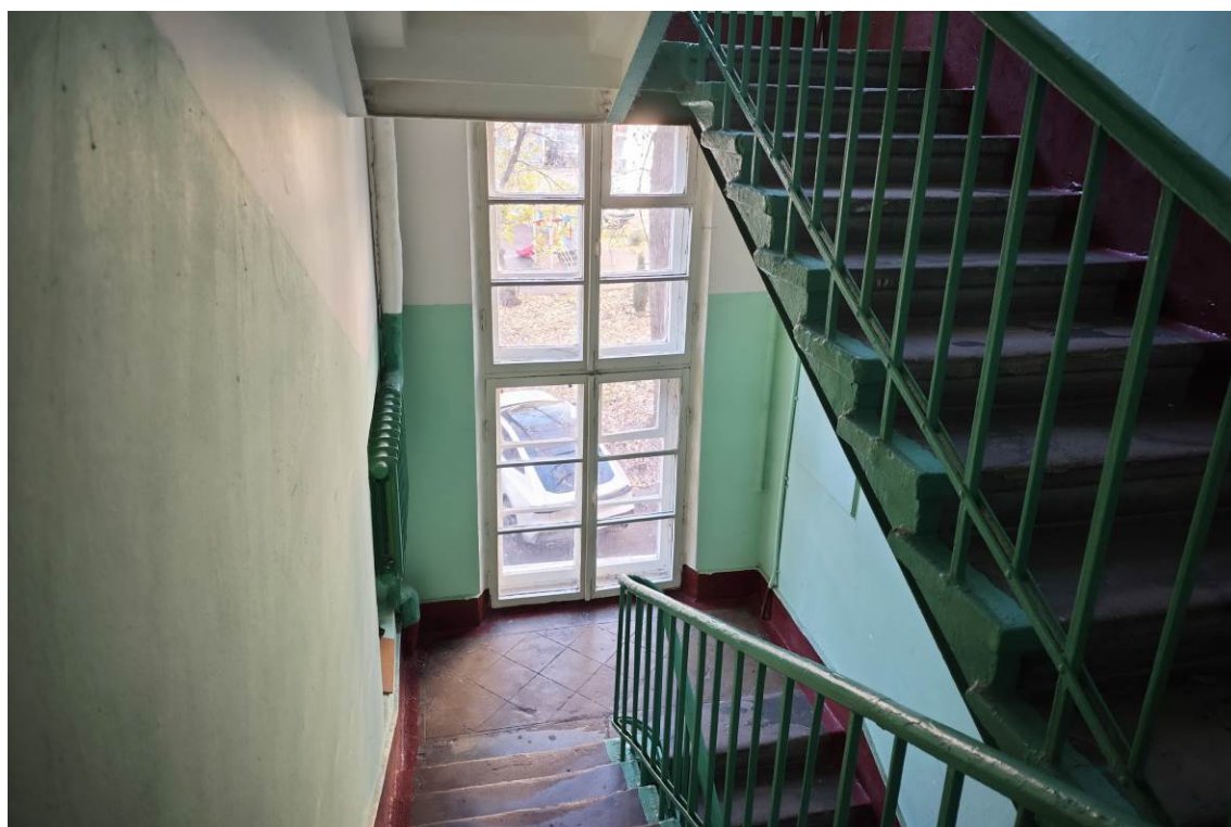
Фото 10. Вид интерьера подъезда по адресу: ул. Преображенский Вал, д. 24, кор. 1 (дата съемки октябрь 2024 г.)
