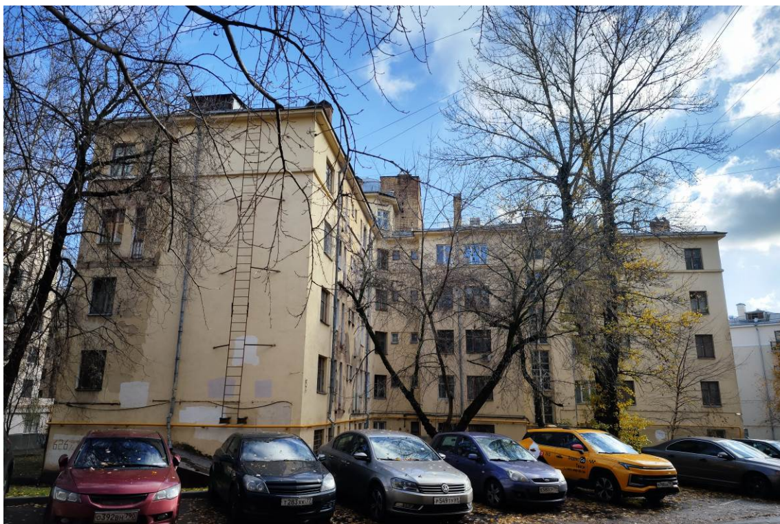
Фото 4. Вид корпуса с северо-восточной стороны по адресу: ул. Преображенский Вал, корп. 6 (дата съемки октябрь 2024 г.)
