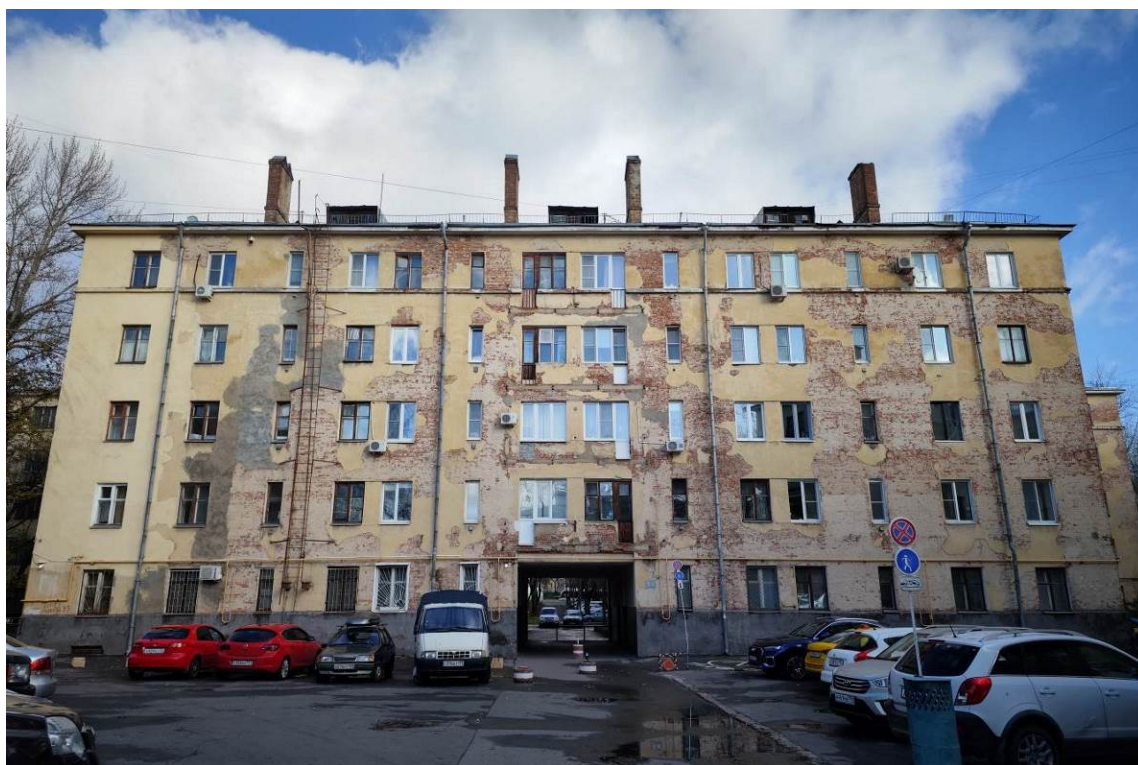
Фото 1. Вид корпуса с северо-восточной стороны по адресу: ул. Преображенский Вал, корп. 6 (дата съемки октябрь 2024 г.)
