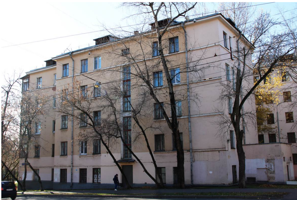
Фото 1. Вид корпуса с северо-восточной стороны по адресу: ул. Преображенский Вал, корп. 3 (дата съемки октябрь 2024 г.)
