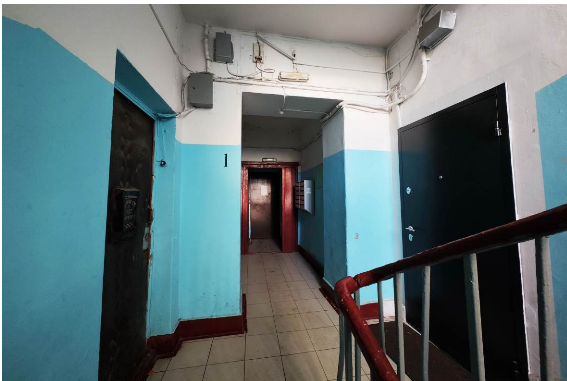
Фото 6. Вид интерьера подъезда по адресу: ул. Преображенский Вал, д. 24, кор. 3 (дата съемки октябрь 2024 г.)
