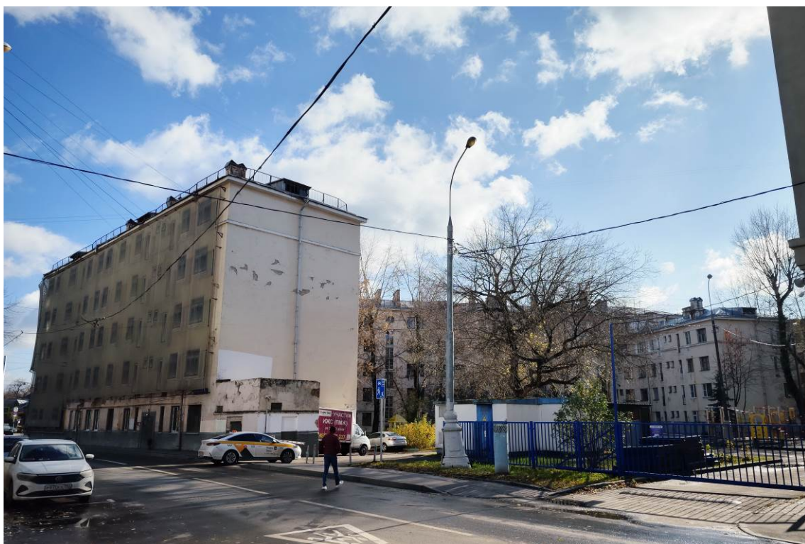
Фото 12. Вид корпуса с севера по адресу: ул. Преображенский Вал, корп. 1 (дата съемки октябрь 2024 г.)
