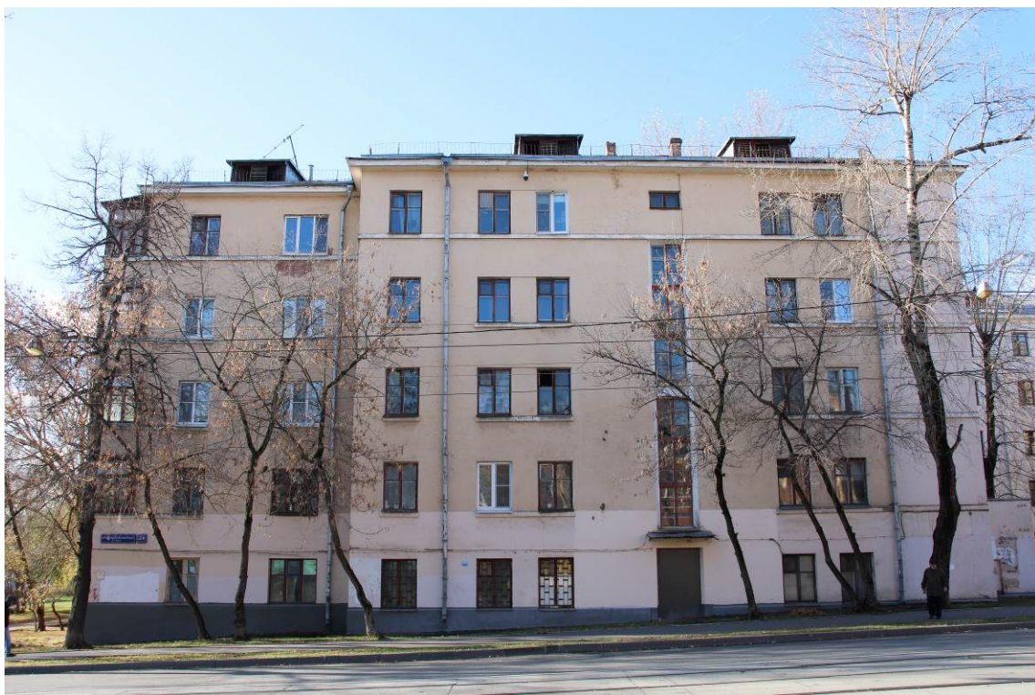
Фото 2. Вид корпуса с восточной стороны по адресу: ул. Преображенский Вал, корп. 3 (дата съемки октябрь 2024 г.)
