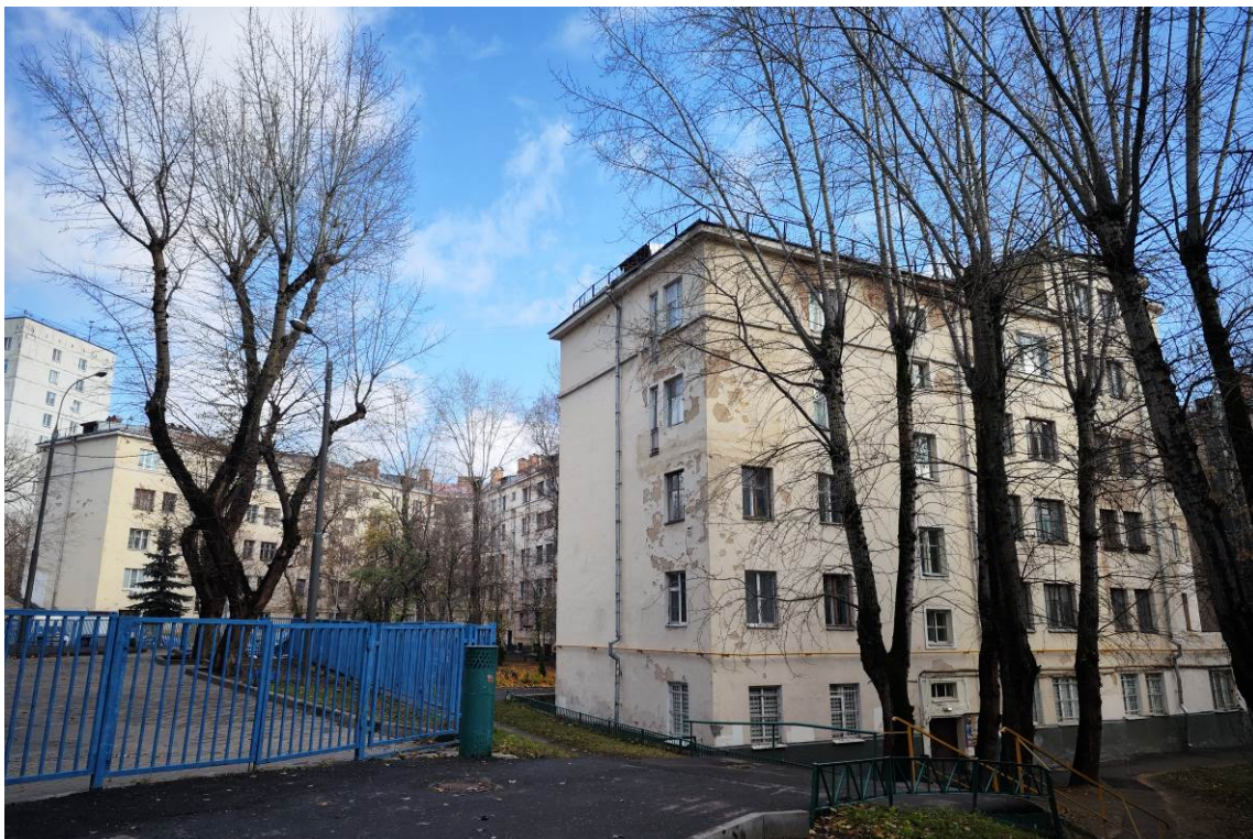
Фото 7. Вид корпуса с запада по адресу: ул. Преображенский Вал, корп. 1 (дата съемки октябрь 2024 г.)
