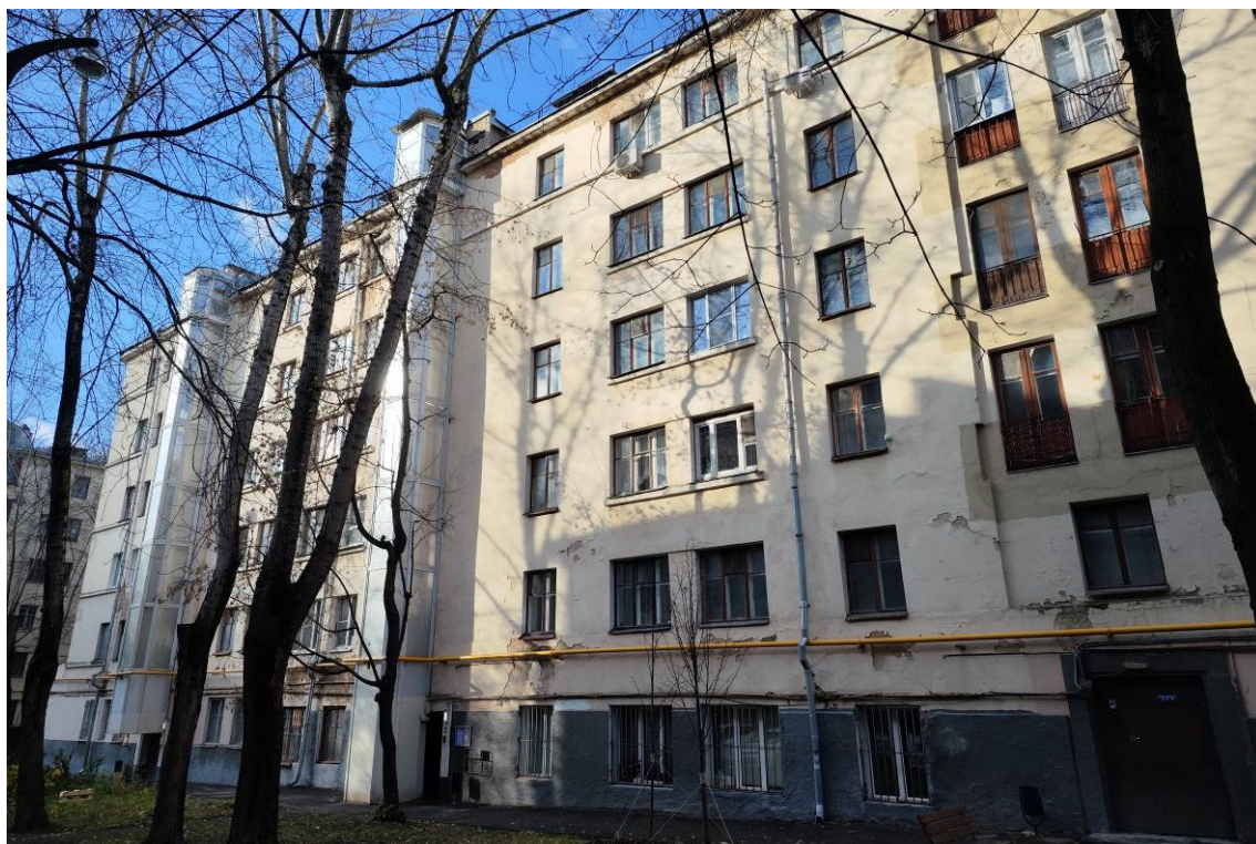
Фото 5. Вид корпуса с южной стороны по адресу: ул. Преображенский Вал, корп. 1 (дата съемки октябрь 2024 г.)
