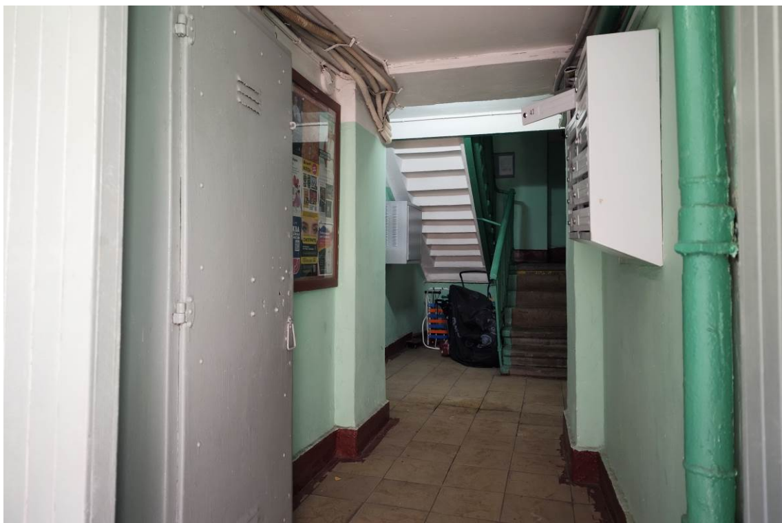
Фото 9. Вид интерьера подъезда по адресу: ул. Преображенский Вал, д. 24, кор. 1 (дата съемки октябрь 2024 г.)
