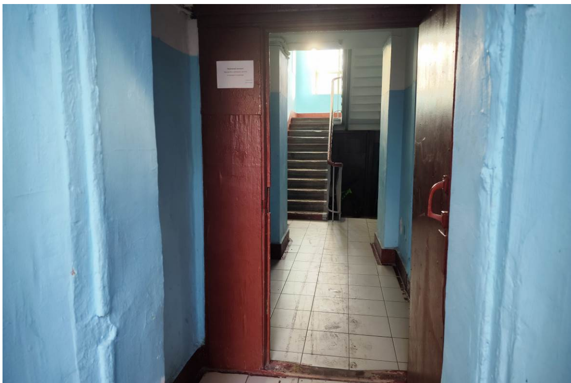
Фото 5. Вид интерьера подъезда по адресу: ул. Преображенский Вал, д. 24, кор. 3 (дата съемки октябрь 2024 г.)
