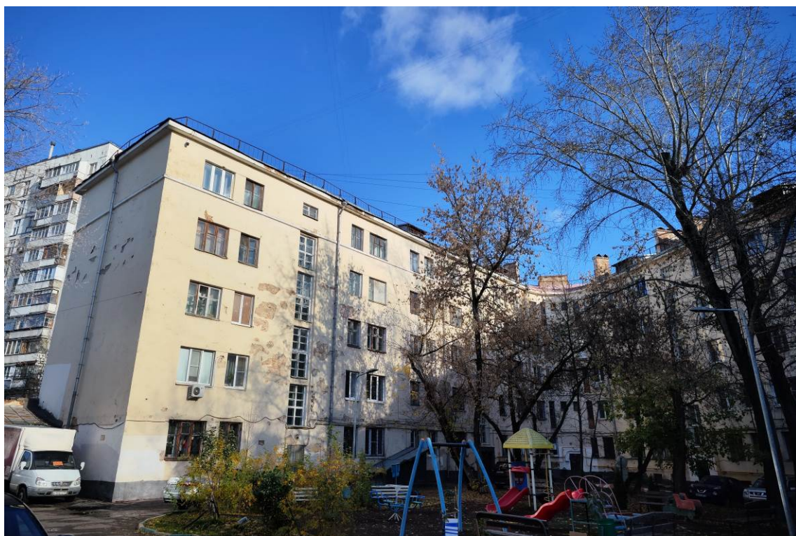
Фото 10. Вид корпуса с запада по адресу: ул. Преображенский Вал, корп. 1 (дата съемки октябрь 2024 г.)
