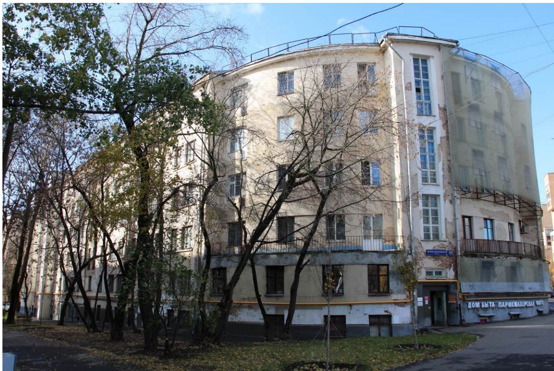
Фото 3. Вид корпуса с восточной стороны по адресу: ул. Преображенский Вал, корп. 1 (дата съемки октябрь 2024 г.)
