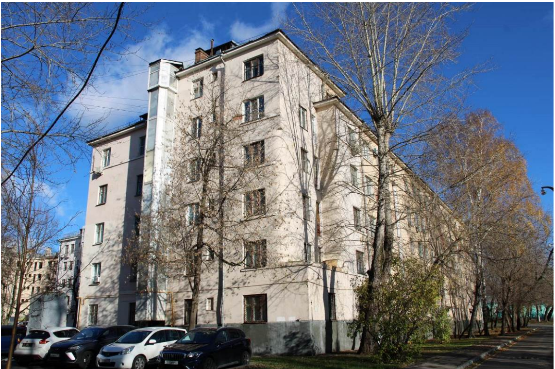
Фото 6. Вид корпуса с северо-восточной стороны по адресу: ул. Преображенский Вал, корп. 3 (дата съемки октябрь 2024 г.)
