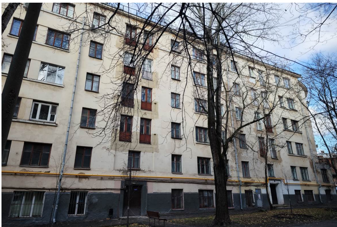
Фото 4. Вид корпуса с восточной стороны по адресу: ул. Преображенский Вал, корп. 1 (дата съемки октябрь 2024 г.)
