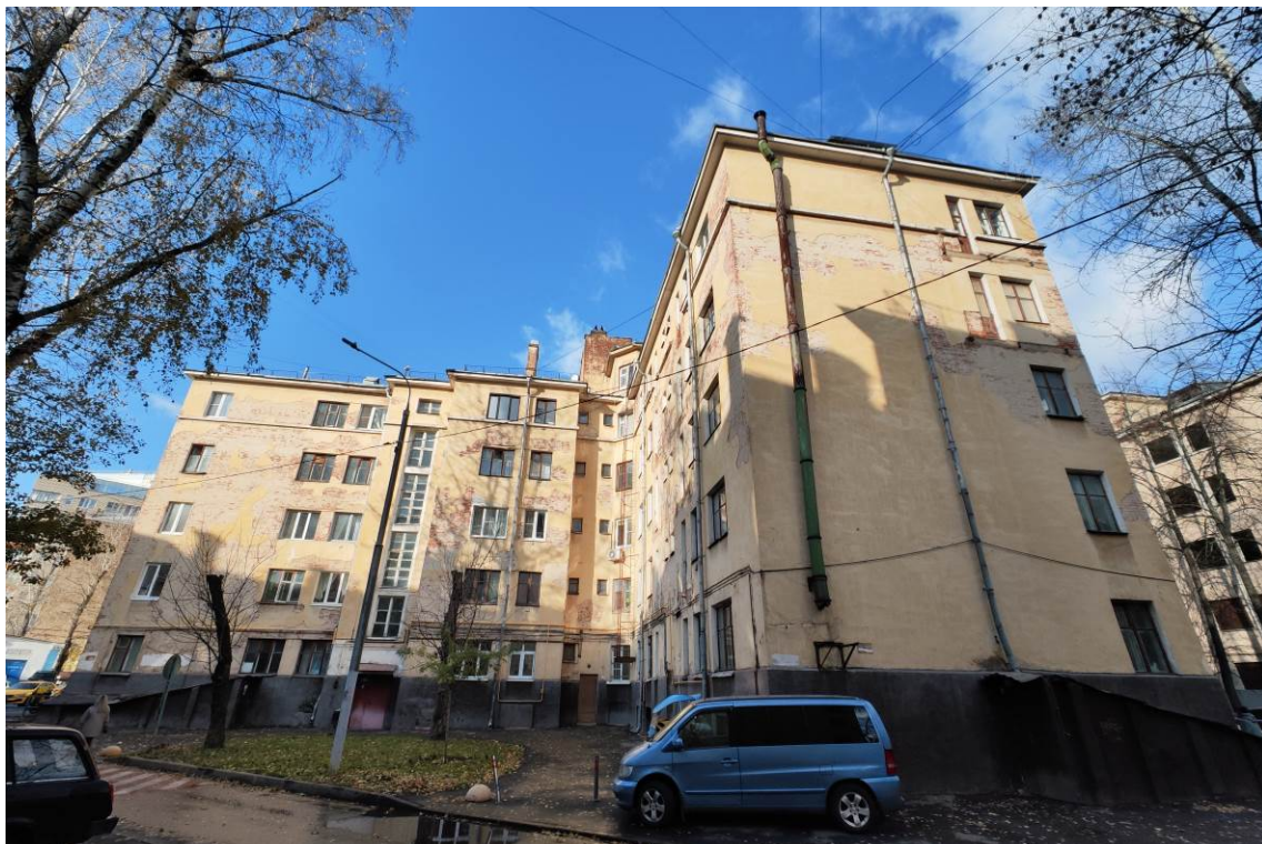
Фото 11. Вид корпуса с северо-восточной стороны по адресу: ул. Преображенский Вал, корп. 6 (дата съемки октябрь 2024 г.)
