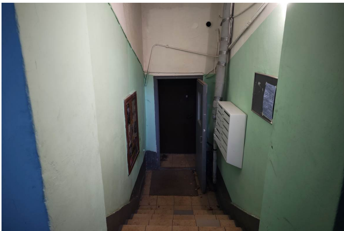
Фото 8. Вид интерьера подъезда по адресу: ул. Преображенский Вал, д. 24, кор. 1 (дата съемки октябрь 2024 г.)
