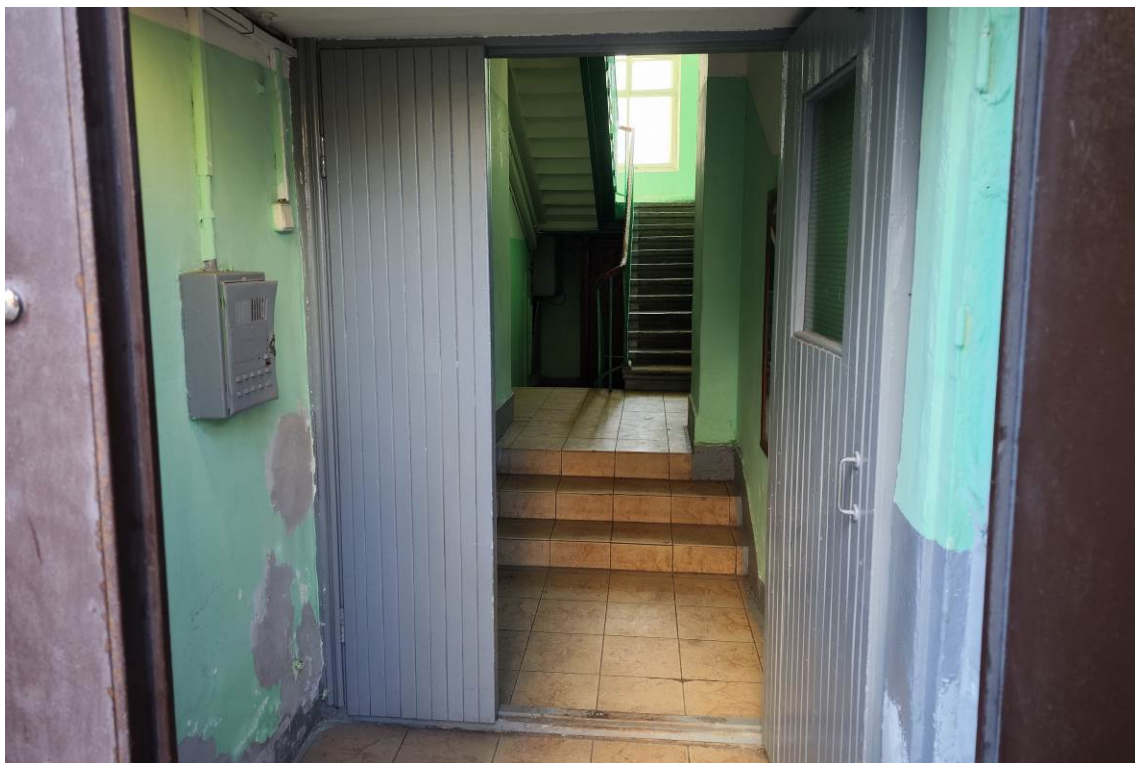
Фото 1. Вид интерьера подъезда по адресу: ул. Преображенский Вал, д. 24, кор. 1 (дата съемки октябрь 2024 г.)
