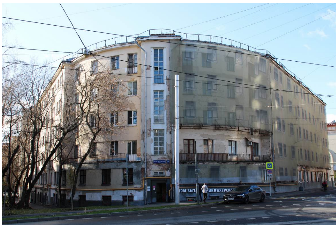
Фото 2. Вид корпуса с северо-восточной стороны по адресу: ул. Преображенский Вал, корп. 1 (дата съемки октябрь 2024 г.)
