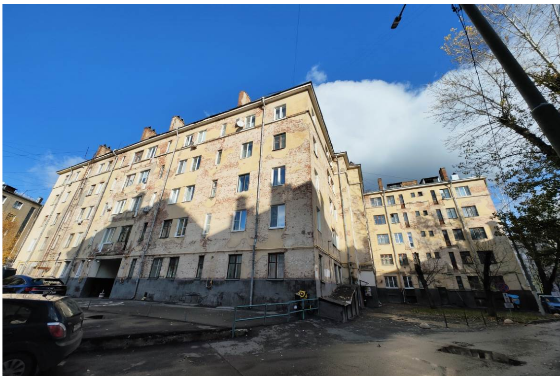
Фото 12. Вид корпуса с северо-восточной стороны по адресу: ул. Преображенский Вал, корп. 6 (дата съемки октябрь 2024 г.)
