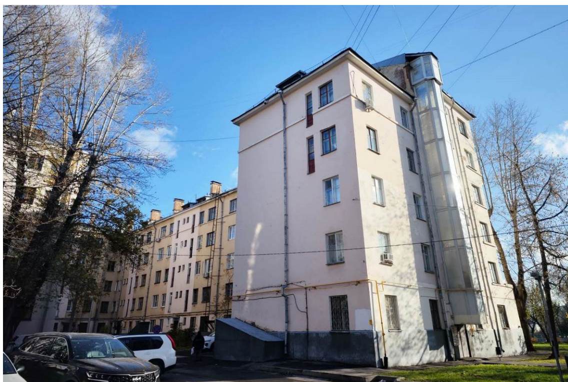
Фото 8. Вид корпуса с северо-восточной стороны по адресу: ул. Преображенский Вал, корп. 3 (дата съемки октябрь 2024 г.)
