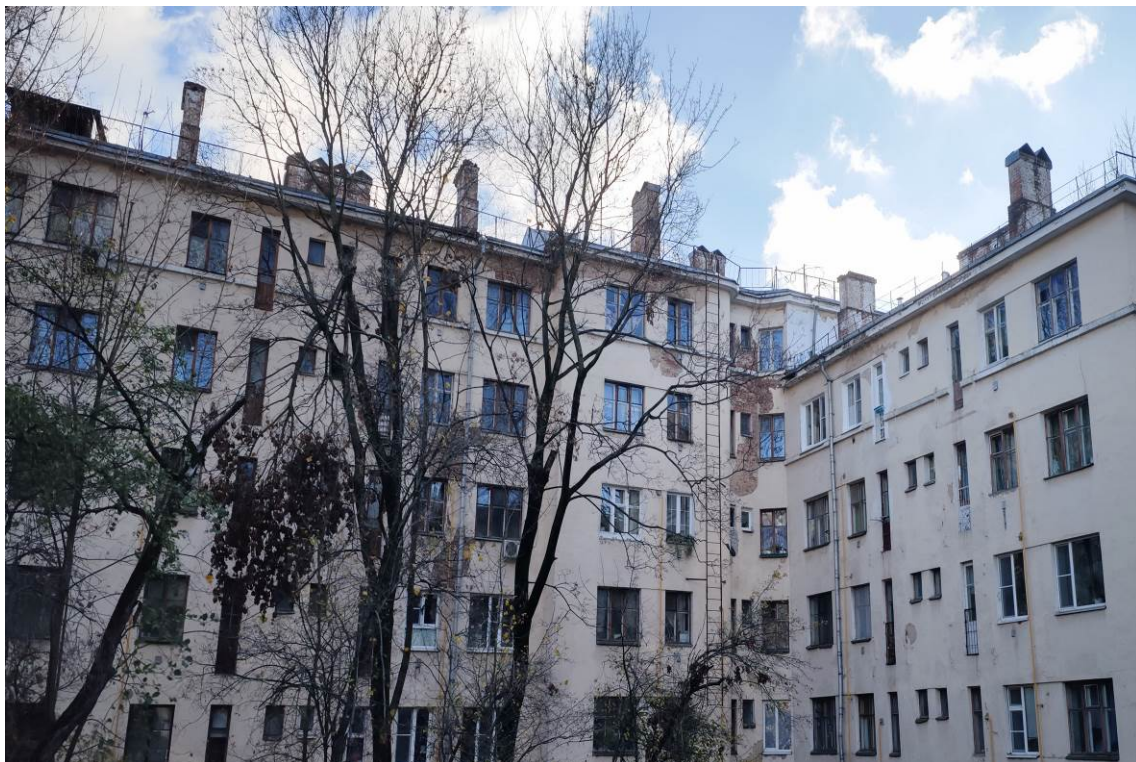
Фото 9. Вид корпуса с северо-западной стороны по адресу: ул. Преображенский Вал, корп. 1 (дата съемки октябрь 2024 г.)
