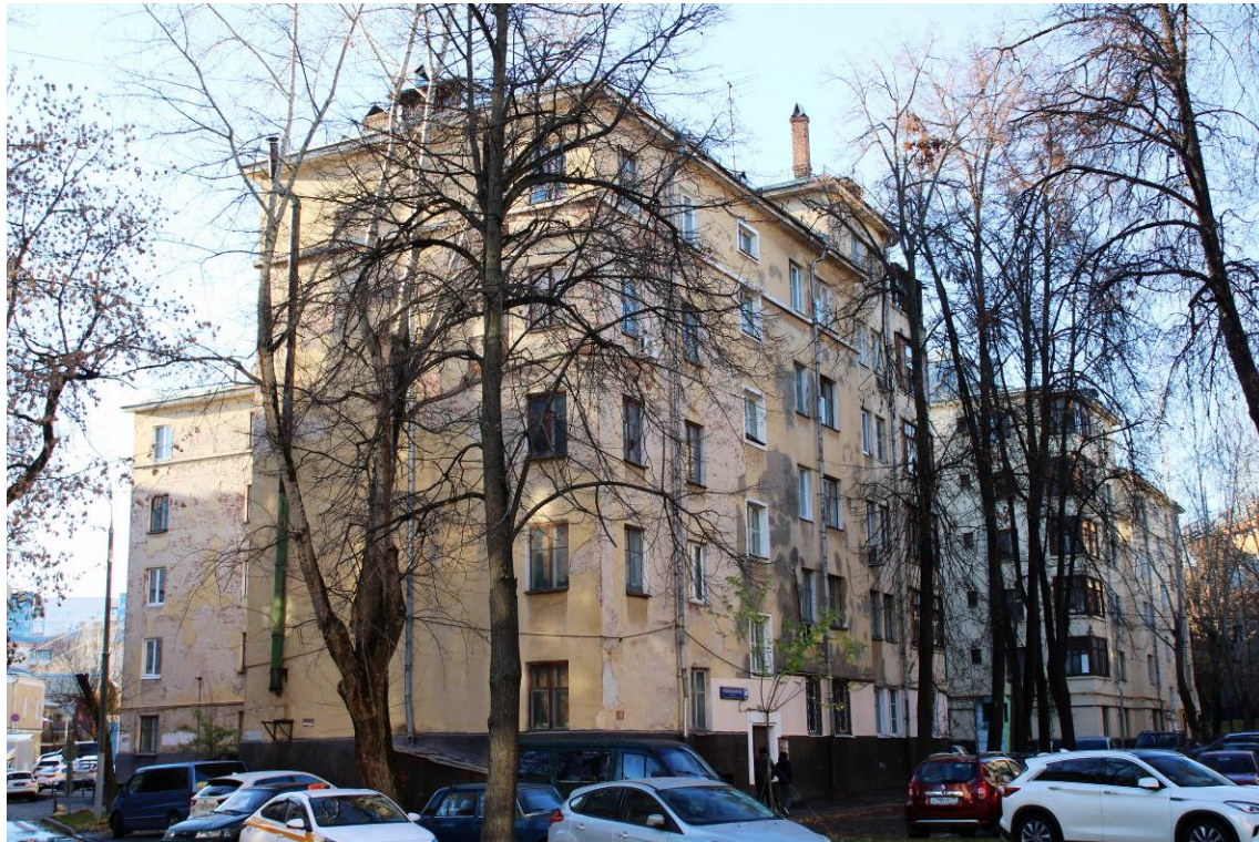
Фото 10. Вид корпуса с северо-восточной стороны по адресу: ул. Преображенский Вал, корп. 6 (дата съемки октябрь 2024 г.)
