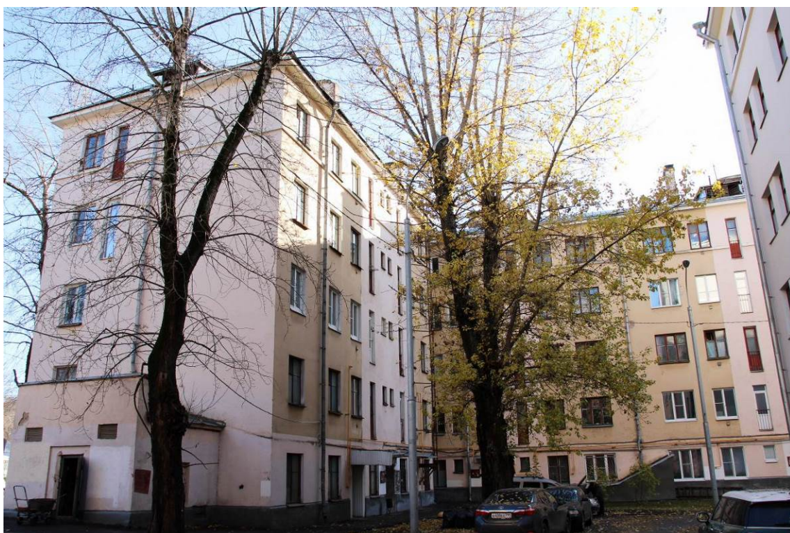
Фото 12. Вид корпуса с северо-восточной стороны по адресу: ул. Преображенский Вал, корп. 3 (дата съемки октябрь 2024 г.)
