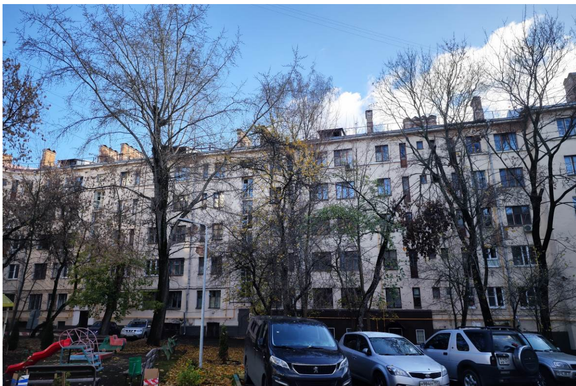
Фото 11. Вид корпуса с запада по адресу: ул. Преображенский Вал, корп. 1 (дата съемки октябрь 2024 г.)
