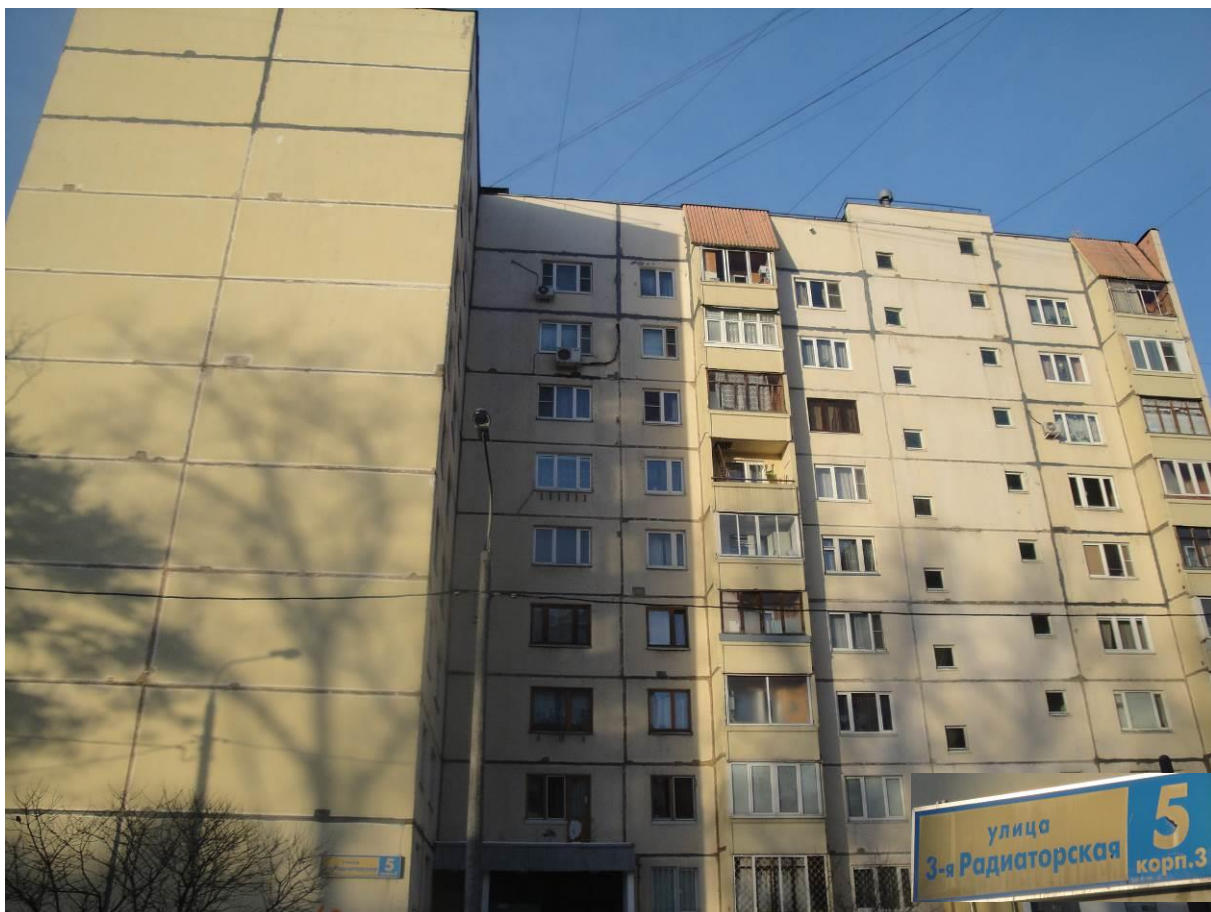
Рис. 1. Общий вид фасада д.5, корп.3, по 3-й Радиаторской улице
