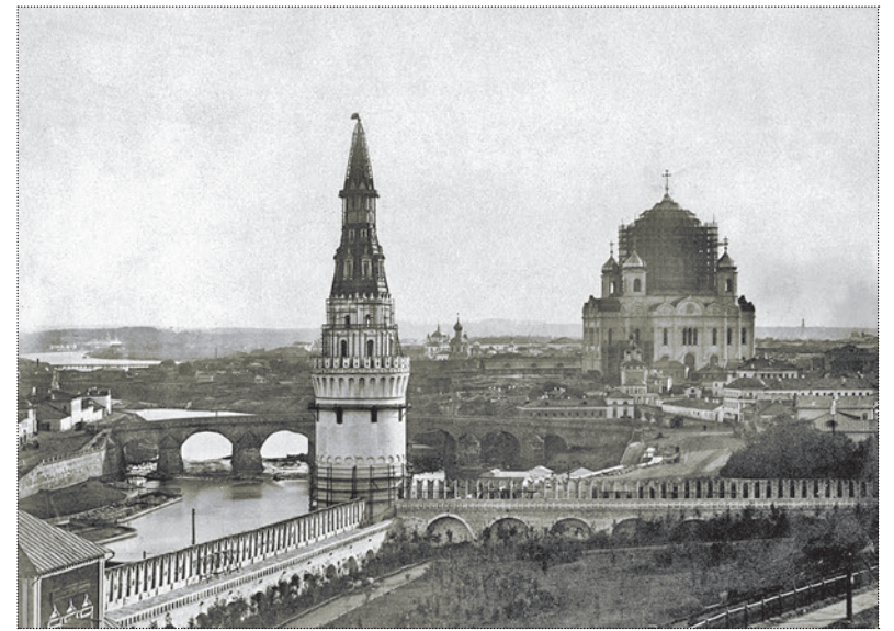
Вид из Кремля на строящийся храм. Фото 1856 года
