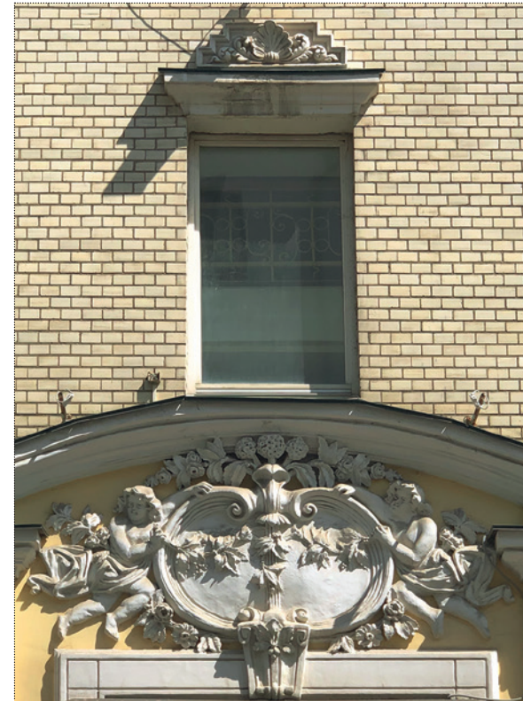
Дом № 4. Картуш над главным входом в здание. Фото автора, 2024 год
