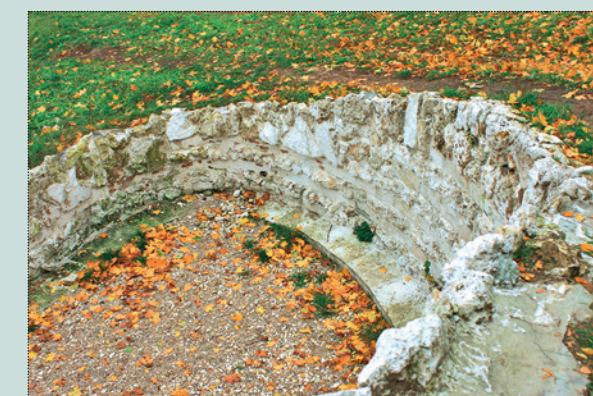
Подпорная стенка у одноарочного грота. Фото автора, 2009 год
