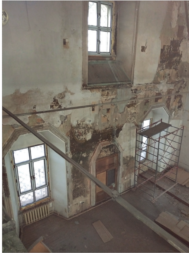
Состояние северной стены храма после расчистки в ходе исследовательских работ. Фото: ООО «Пирит-99», 2020 год
