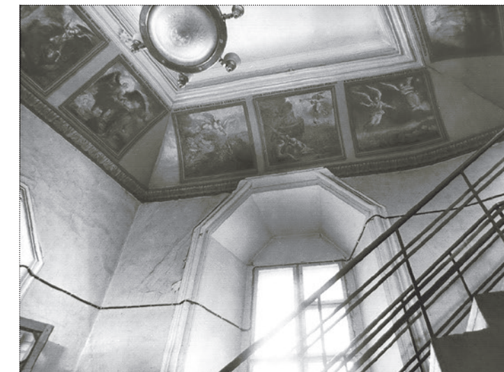
Церковь Петра и Павла. Лестница. Фото 1981 года
