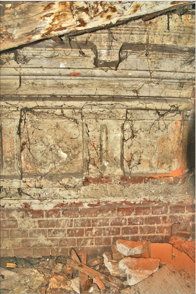
Фрагменты фриза и венчающего карниза северного фасада трапезной малого (старого) храма. Фото 2011 года
