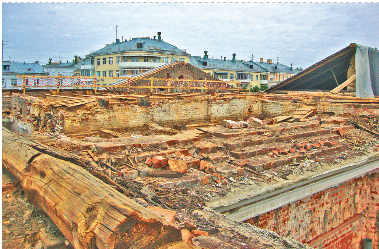
Объект культурного наследия федерального значения «Дом Дурасова с двумя воротами и оградой», конец XVIII века, арх. М.Ф. Казаков. Вид на фронтон со стороны чердака после демонтажа аварийных стропильных конструкций. Фото 2013 года
