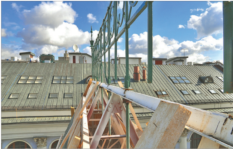
Крепление отреставрированного гребня на усиленные конструкции исторического шатра. Фото 2012 года
