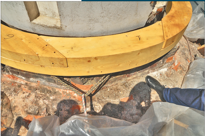
Опорное кольцо в основании глухого барабана главки. Фото 2013 года
