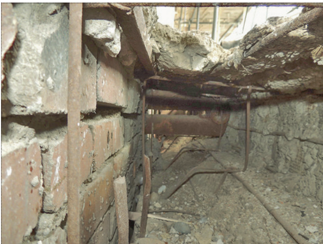
Секции чугунных радиаторов отопления, которые стали основной несущей частью, сформировавшей последующее тело карниза фасада. Фото 2014 года
