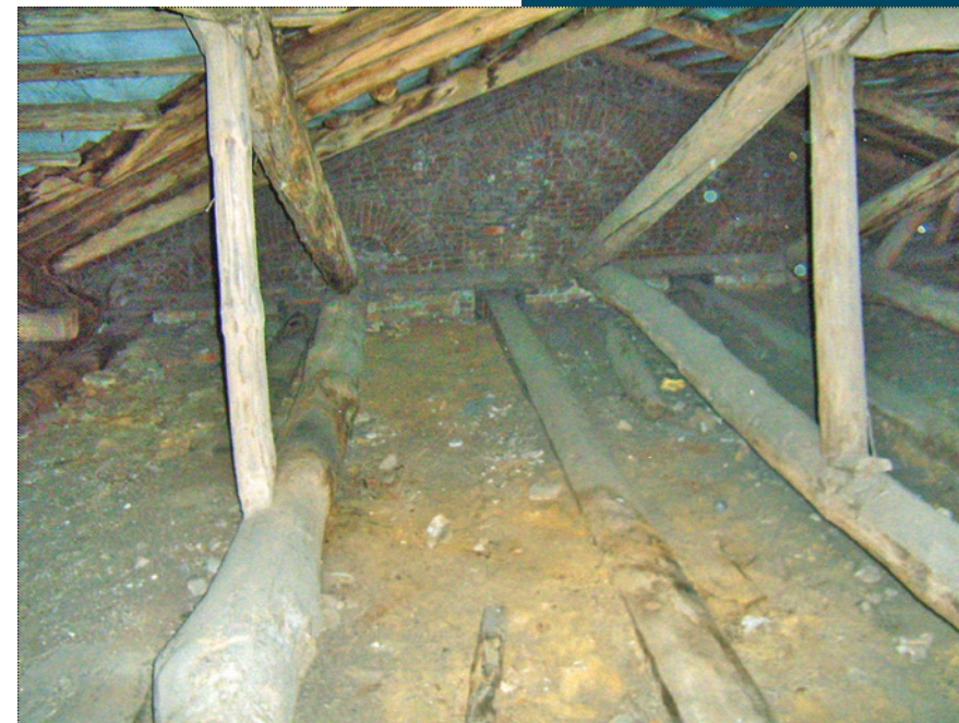
Вид на фронтон со стороны чердака до начала работ. Объект культурного наследия федерального значения «Дом Дурасова с двумя воротами и оградой». Фото 2008 года
