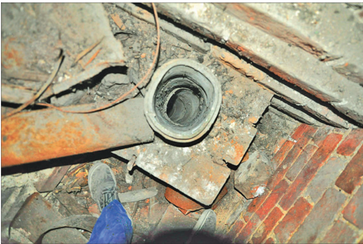
Керамическая труба системы калориферного отопления малого (старого) храма. Фото 2011 года
