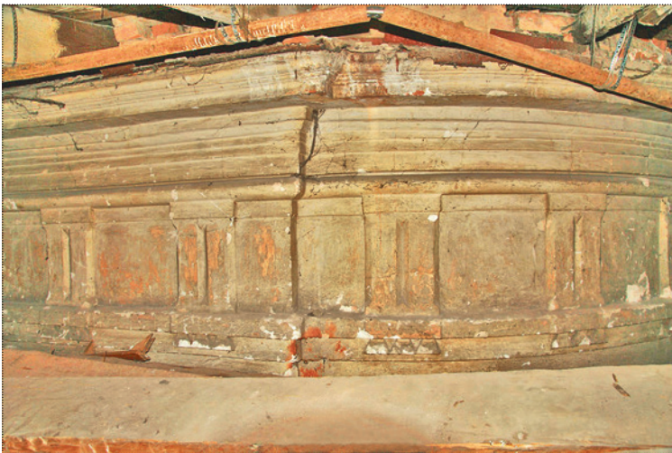
Фрагменты фриза и венчающего карниза северного фасада трапезной малого (старого) храма. Фото 2011 года
