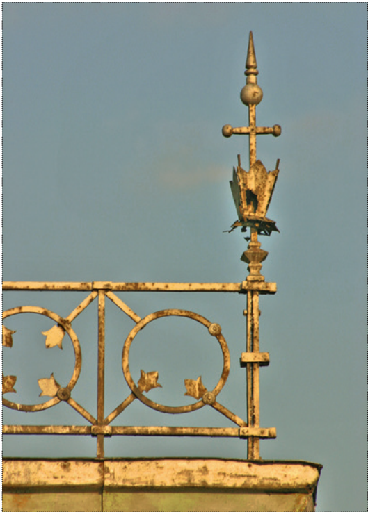
Состояние венчающего гребня шатра. Фото 2010 года
