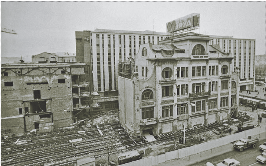
Передвижка здания редакции газеты «Труд». Фото: А. Сенцов, 1979 год
