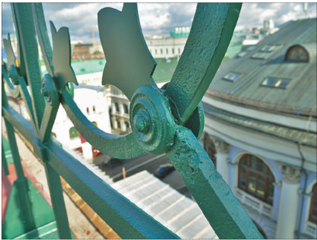
Отреставрированные и новые элементы гребня шатра. Фото 2012 года
