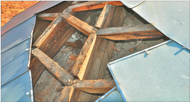
Конструкция купола малого (старого) храма: соединения шпангоутов (продольные элементы) и стрингеров (поперечные элементы). Фото 2011 года
