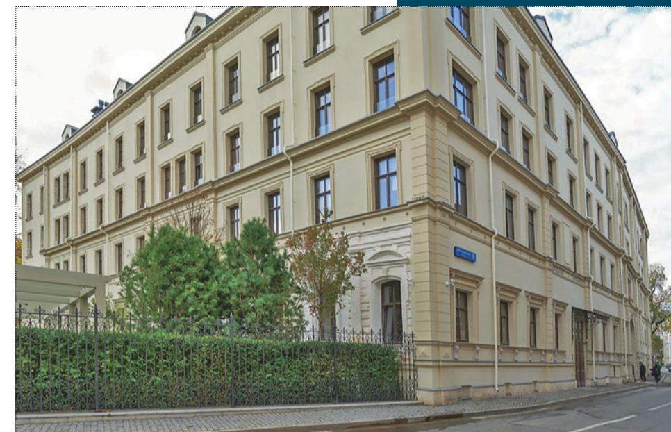
«На момент реставрации дом был в аварийном состоянии. Специалисты восстановили фасады, планировку, интерьеры времён последних дореволюционных владельцев — купцов Абрикосовых. Они жили на первом и втором этажах», — рассказал Мэр Москвы
