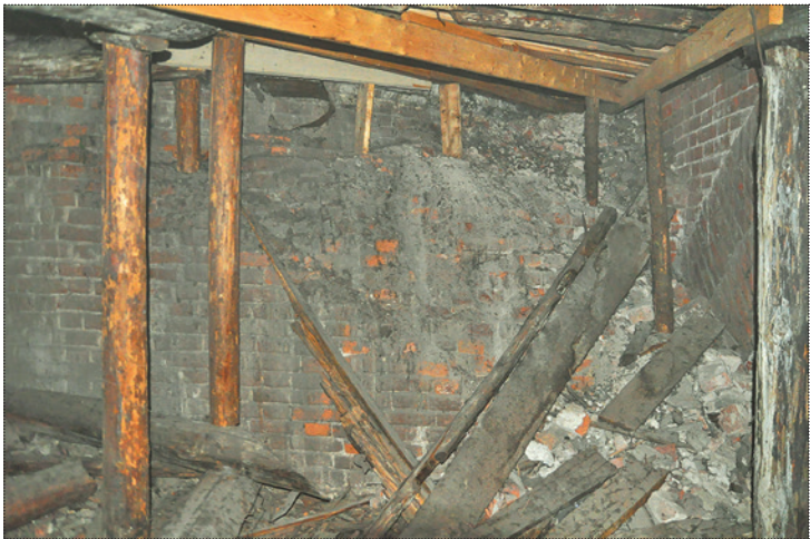
Справа — стена нового храма, арки перекинуты через южную, разобранную апсиду малого храма. Прямо — основание купола малого (старого) храма. Фото 2011 года
