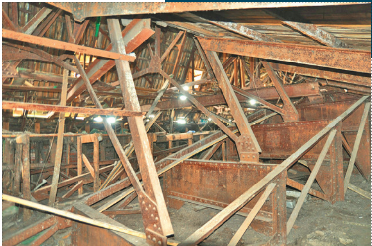
Вид внутренних конструкций Главного шатра (на Красную площадь). Стальные конструкции на переднем плане — несущие элементы ложного подвального свода парадного зала. Фото 2010 года
