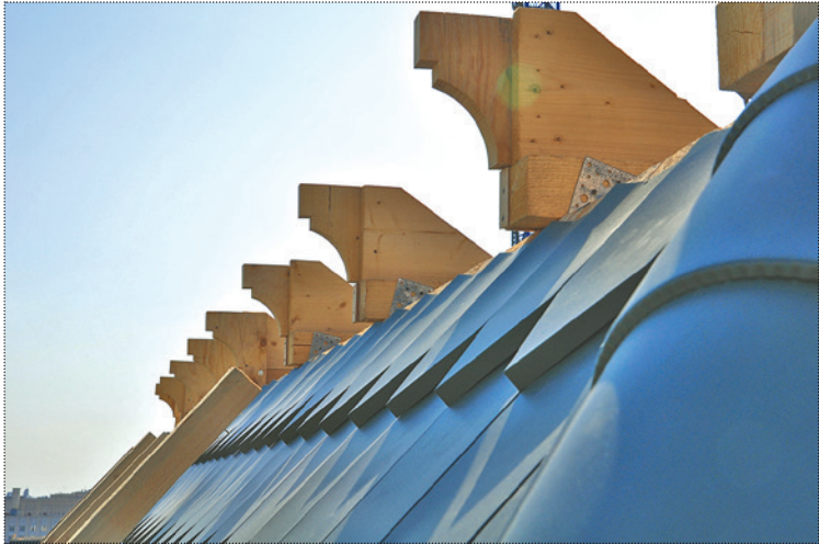
Установка кобылок для формирования венчающего карниза шатра. Фото 2012 года
