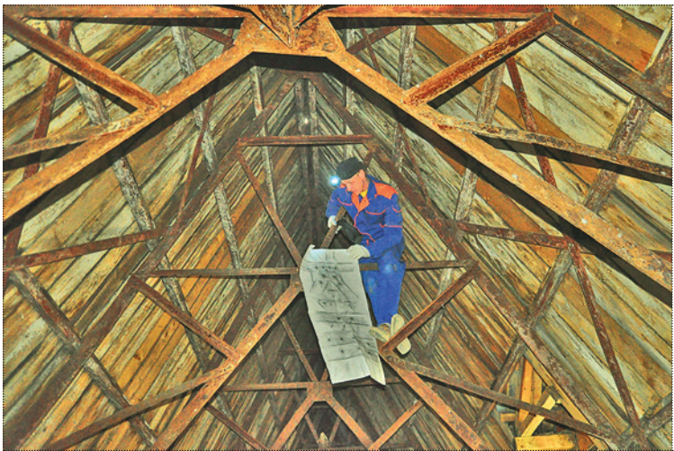
Инженер Д.В. Писарев снимает шаблон соединений ферм шатра: угол Хрустального переулка и улицы Варварка. Фото 2010 года
