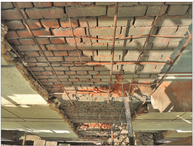
Каркас из прокатной арматуры и полосовой стали, на который была закреплена мелкая сетка, удерживающая непосредственно фасадную штукатурку. Фото 2014 года
