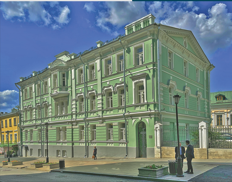
Доходный дом Тюляевой построен в 1900 году архитектором Сергеем Воскресенским. В начале XX века он был очень востребован у частных заказчиков — застройщиков доходных домов. Наиболее известные свои постройки создал в стилях рациональный модерн и неоклассицизм
