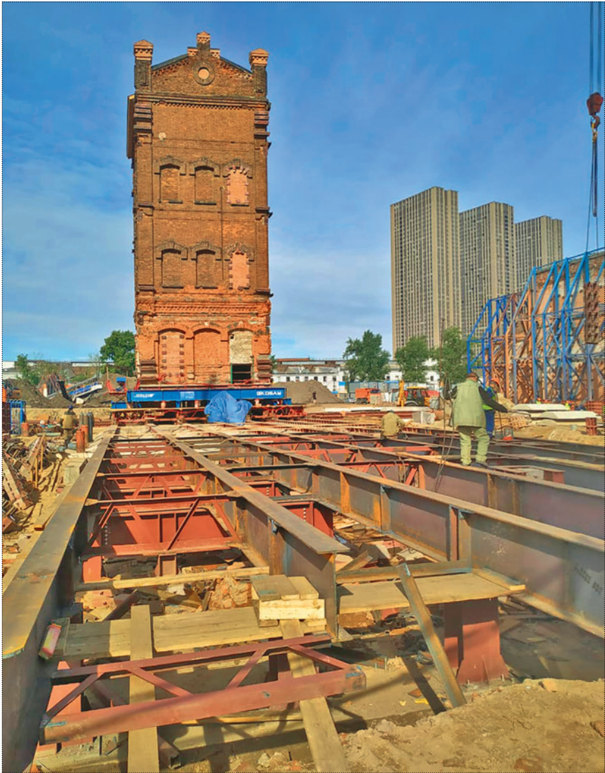
Передвигаемая башня и накаточные пути на Складочной улице. Фото: О. Евлашкин, 2020 год
