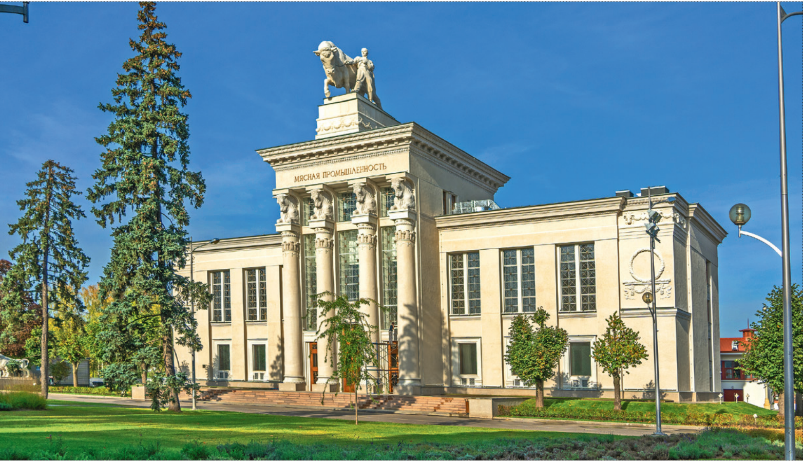
Павильон ВДНХ № 51 «Мясная промышленность» в этом году стал лауреатом премии «Московская реставрация». Построен в 1954 году и с тех пор ни разу не реставрировался. Специалисты провели там комплексные работы, восстановили скульптуру «Боец с быком» на главном фасаде, деревянные парадные двери с металлическим декором
