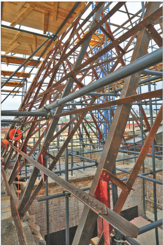
Каркас расчищенного от коррозии шатра по Хрустальному переулку перед работами по усилению. Фото 2012 года
