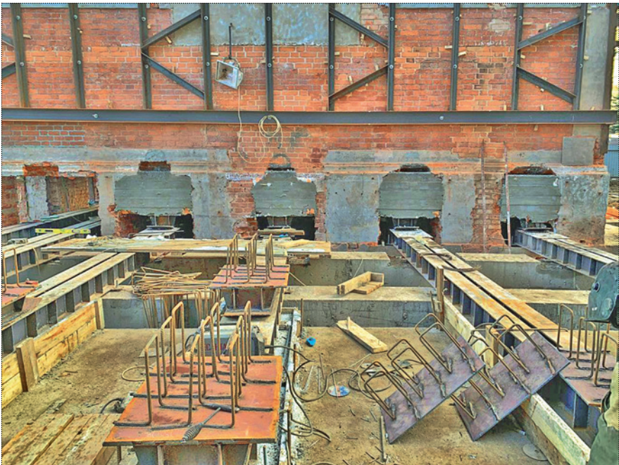
Монтаж салазок и путей скольжения Домика обходчика» на станции Кутузовская МЦД-4. Фото: О. Евлашкин, 2022 год
