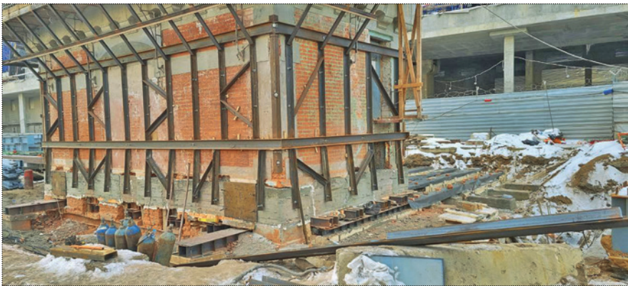
Подготовка к передвигке «Домика обходчика» на станции Кутузовская МЦД-4. Фото: О. Евлашкин, 2022 год
