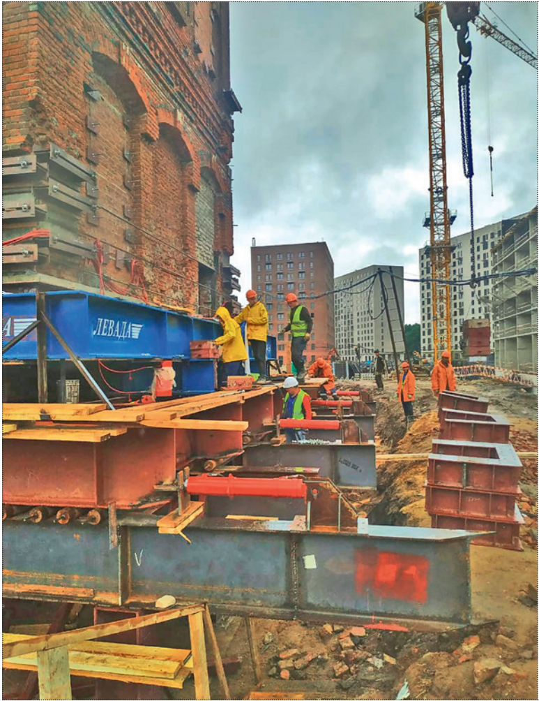
Начало движения башни на Складочной улице. Фото: О. Евлашкин, 2020 год
