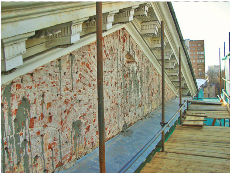
Вид на фронтон со стороны главного фасада после демонтажа штукатурки, в процессе инъекционного укрепления. Объект культурного наследия федерального значения «Дом Дурасова с двумя воротами и оградой». Фото 2013 года
